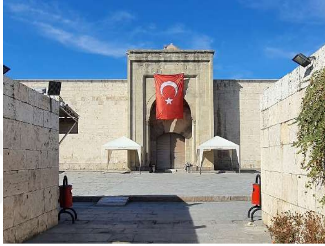
Şekil 3.52. Horozlu Han kapalı kısma ait taç kapı (Kişisel arşiv)
