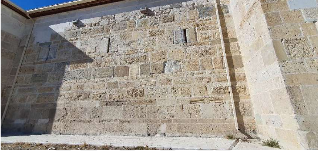
Şekil 3.46. Hanın duvarlarında kullanılan devşirme malzemeler (Kişisel arşiv)
