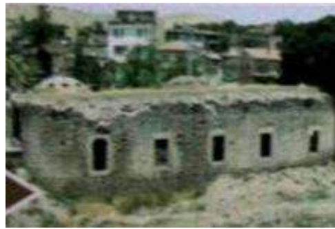
Şekil 3.34. Ak Hamam restorasyondan önce çekilmiş bir fotoğraf (Sanal 10, 2021)
