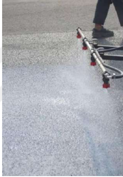
Şekil 2.4. TiO 2 sıvı süspansiyonun püskürtmeli uygulanması (Crispino, 2010)
