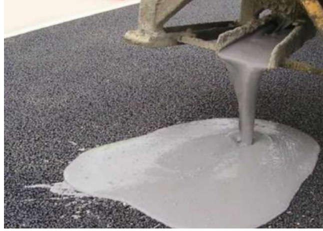
Şekil 2.3. TiO 2 karışimli çimento harcının asfalta dökülmesi işlemi (Crispino, 2010)
