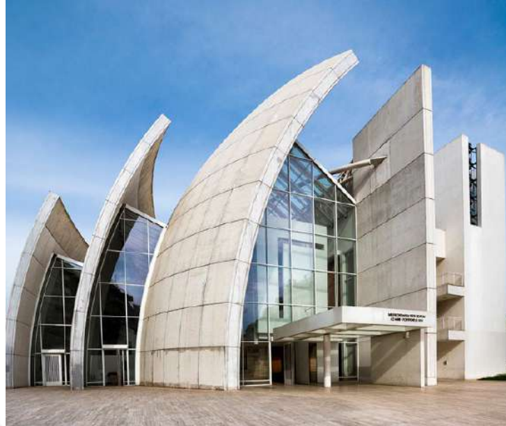
Şekil 2.10. Dives in Misericordia Kilisesi'nin cephesinde biriken kirlilik (Wikimeadia, 2012)
