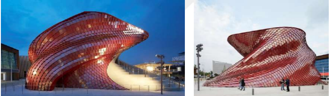
Şekil 2.6, 2.7. Vanke Pavilyonu'nun cephesinde bulunan fotokatalitik seramikler (ArchDaily, 2015)
