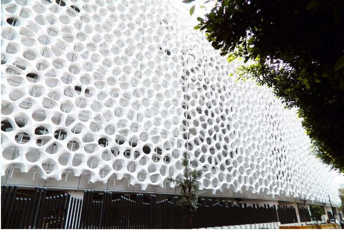
Şekil 2.12. Hastanenin cephesinde bulunan Prosolve370e Modülleri (Zva Architects)
