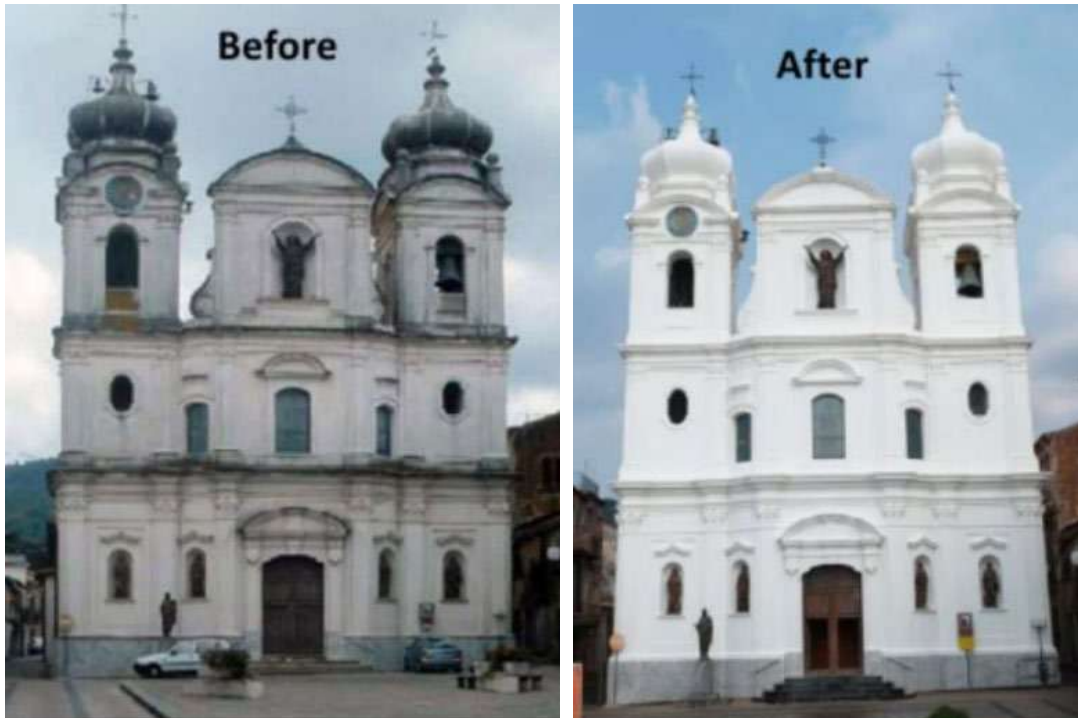
Şekil 2.5. Cephesinde TiO 2 içerikli malzeme kullanılan Matrice di Cittanova Kilisesi'nin önceki ve sonraki hali (Acar, 2022)
