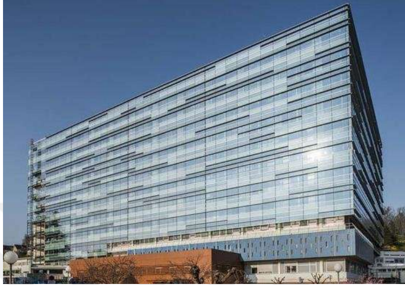
Şekil 2.9. Cam sistemi TiO 2 bazlı ince filmle kaplı olan Brive-la-Gaillarde Hastanesi (Curcic, 2018)
