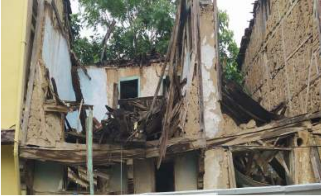
Fotoğraf 229: Ulu Camii Mahallesi Hacı Tahir Sokak 23 Nolu Yıkım Aşamasında Olan Evin Üst Kat Görünümü(Kağancan Ayaz'dan)
