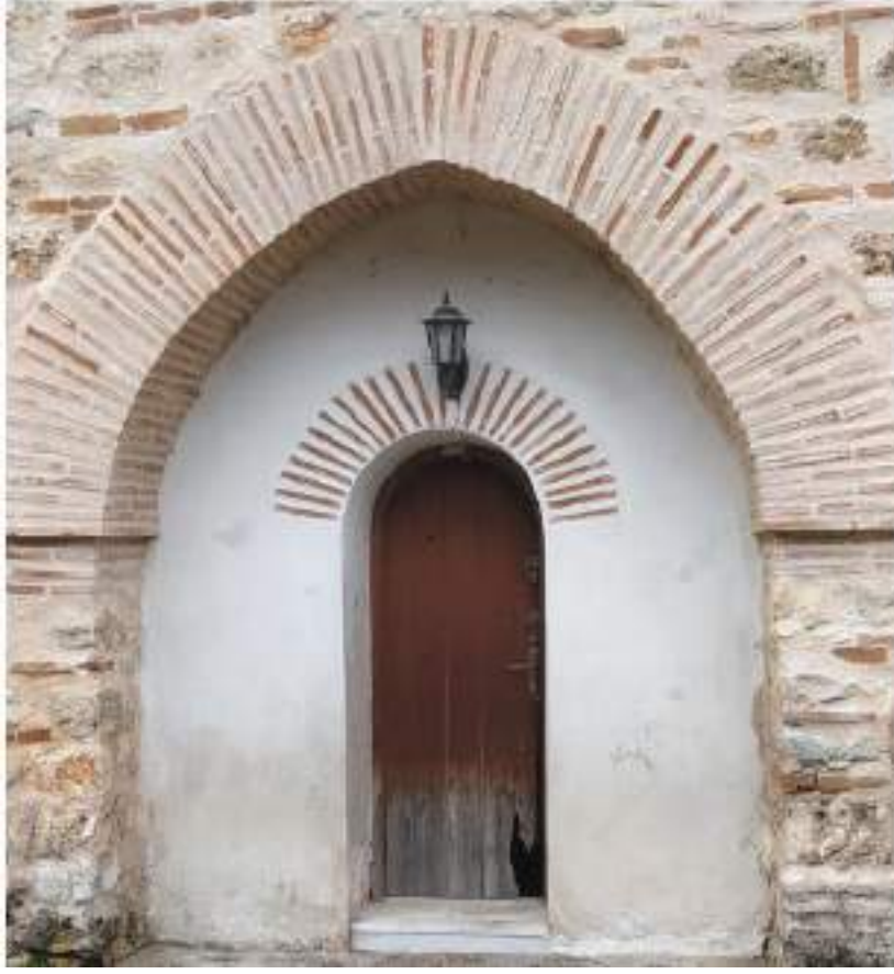
Fotoğraf 76 Yarhisar Hamamına Giriş Sağlayan Sivri Kemerli Nişe Sahip Kapı Görünümü (Kağancan Ayaz'dan)
