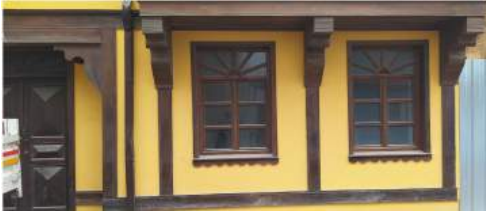
Fotoğraf 237: Yorgancıođlu Konađı Alt Kat Kapı ve Batı Cephesi Pencereleri (Kađancan Ayaz'dan)
