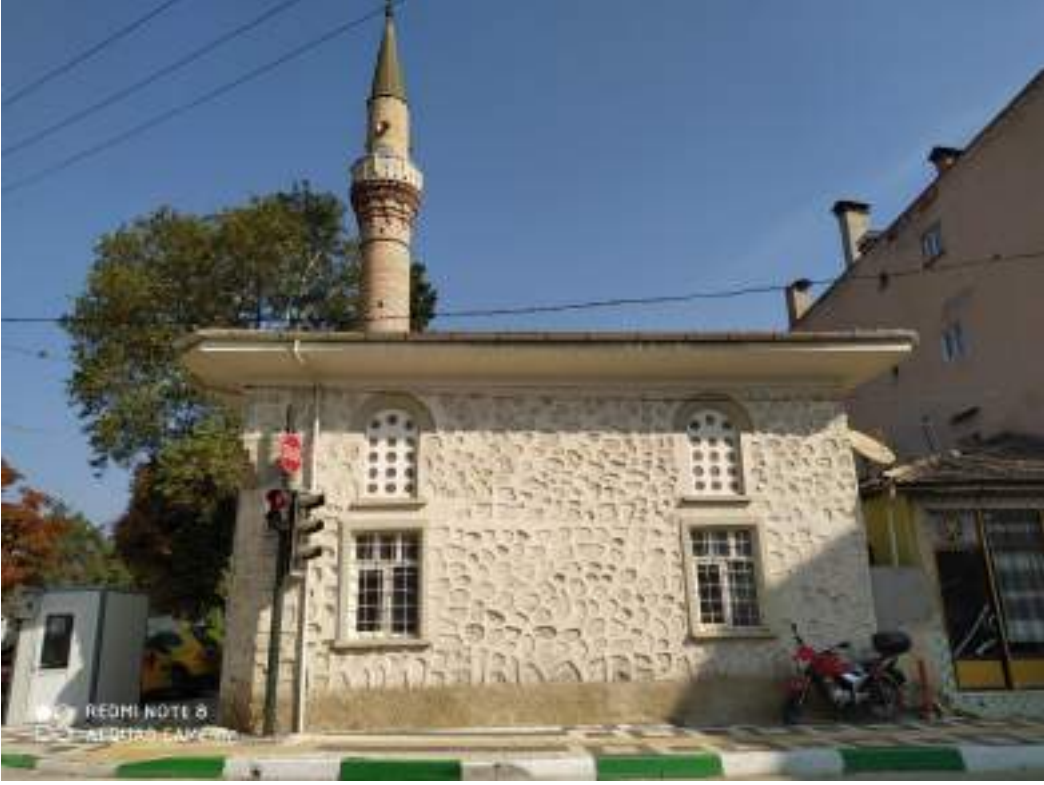
Fotoğraf 3: Kumluk Camisi Güney Cephe Genel Görünümü (Kağancan Ayaz'dan)
