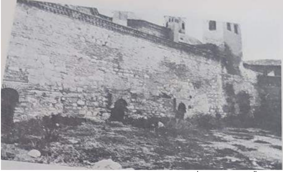
Fotoğraf 148: Sinan Paşa Arastası Batı Duvarında İnşa Edilmiş Üç Yuvarlak Kemerli Ocak Nişi Genel Görünüm (Vakıflar Bölge Müdürlüğünden)
