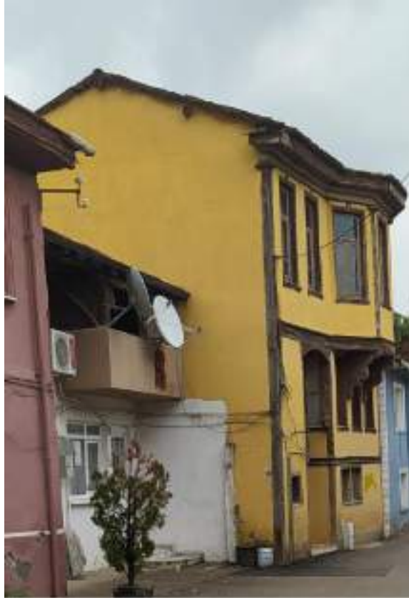
Fotoğraf 225: 27 Nolu Ev Uzaktan Genel Görünümü(Kağancan Ayaz'dan)
