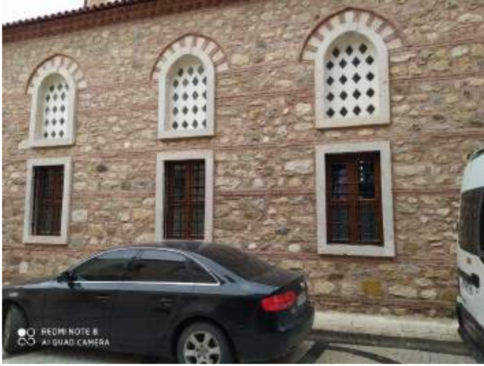
Fotoğraf 44: Voyvoda Çınarlı Camisi Doğu Cephesi (Kağancan Ayaz'dan)
