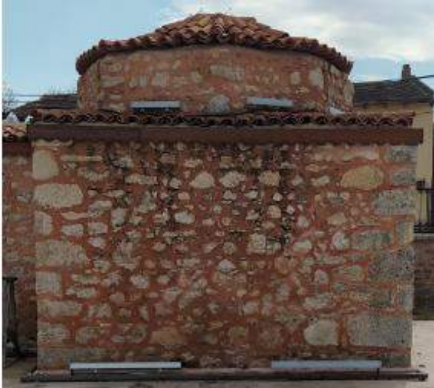
Fotoğraf 83: Ayaz köyü Hamamı Doğu Cephesi (Kağancan Ayaz'dan)
