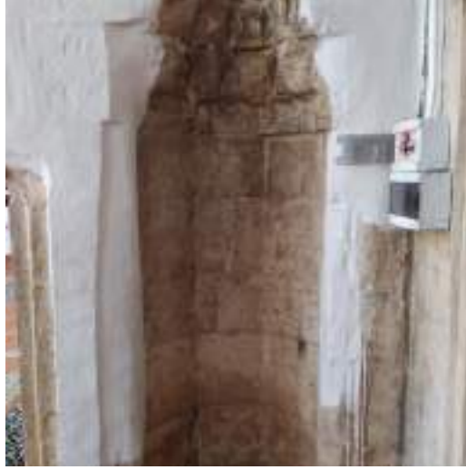
Fotoğraf 63: Bali Bey Camisi Kapının Doğu Cephesinde Bulunan Niş (Kağancan Ayaz'dan)
