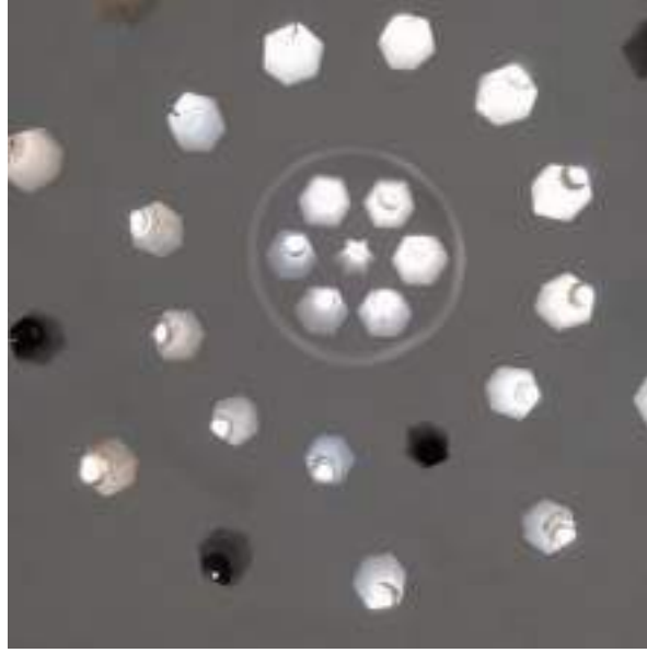
Fotoğraf 103: Tarihi Hamam Sıcaklık Bölümü Aydınlik Açıklığı (Kağancan Ayaz'dan)
