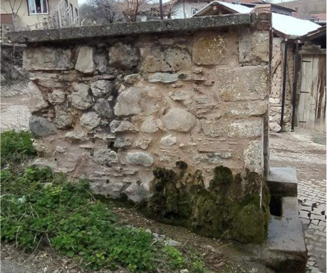
Fotoğraf 73: Yarhisar Çeşmesi Doğu Cephesi (Kağancan Ayaz'dan)
