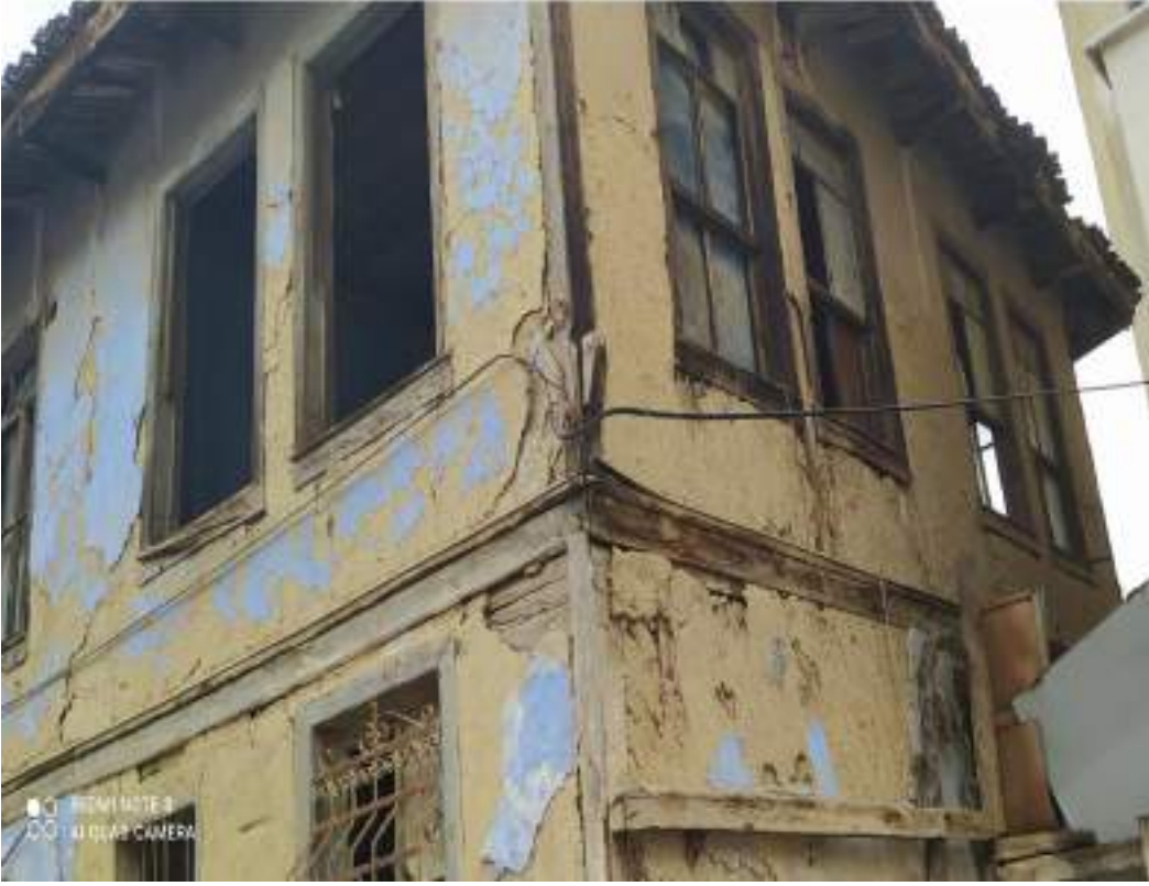
Fotoğraf 234: Ulu Camii Mahallesiinde Yer Alan Numarası Bilinmeyen Ev Kuzeybatı Cephesi Genel Görünümü (Kağancan Ayaz'dan)
