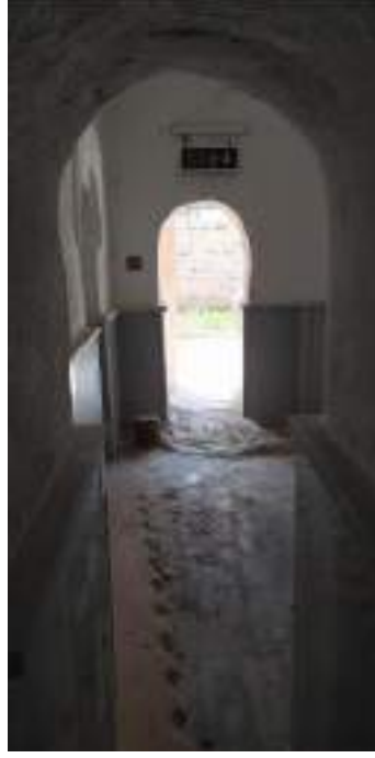
Fotoğraf 84: Ayaz köyü are Mekândan Soğukluk Mekânına Bakış (Kağancan Ayaz'dan)
