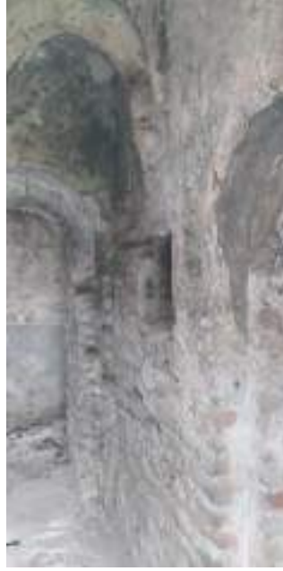
Fotoğraf 92: Mentese Hamamı Soğukluk Mekânından Sıcaklık Mekânından Gözüktüğü Kare Planlı Açıklık Bölümüne Bakış (Kağancan Ayaz'dan)
