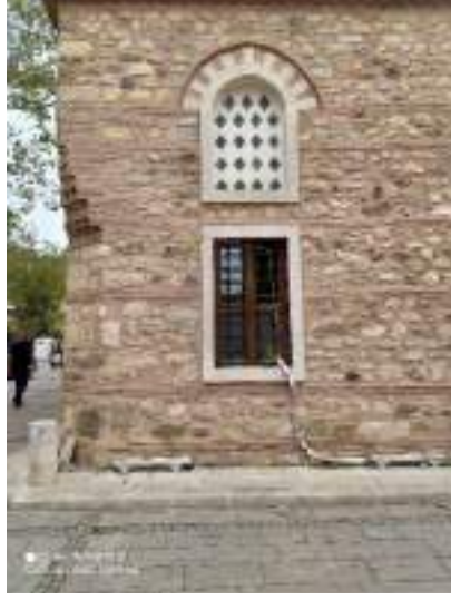
Fotoğraf 46: Voyvoda Çınarlı Camisi Güneybatı Cephesinde Yer Alan Pencere Düzeni ve Pahlanmış Kısım (Kağancan Ayaz'dan)
