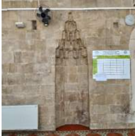
Fotoğraf 57: Bali Bey Camisi Son Cemaat Yerinde Doğu Cephesinde Bulunan Mihrabiye (Kağancan Ayaz'dan)
