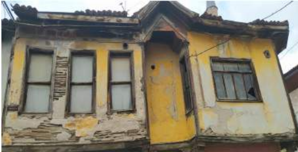
Fotoğraf 231: Orhangazi Ulu Camisi Karşısında Yer Alan Ev Doğu Cephesi Genel Görünümü (Kağancan Ayaz'dan)
