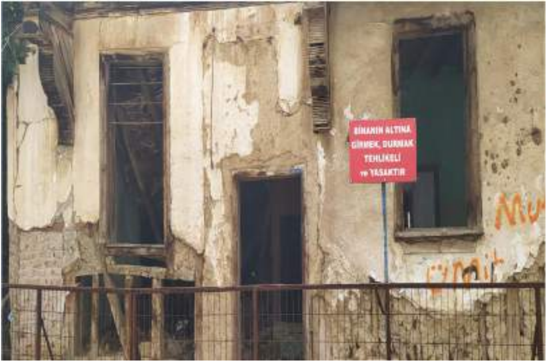
Fotoğraf 221: Tapucuların Konağı Doğu Cephesi Görünümü(Kağancan Ayaz'dan)
