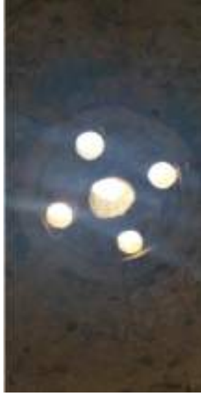
Fotoğraf 96: Mentеше Hamamı Sıcaklık Bölümünde Yer Alan Beş Aydınlık Açıklığı (Kağancan Ayaz'dan)
