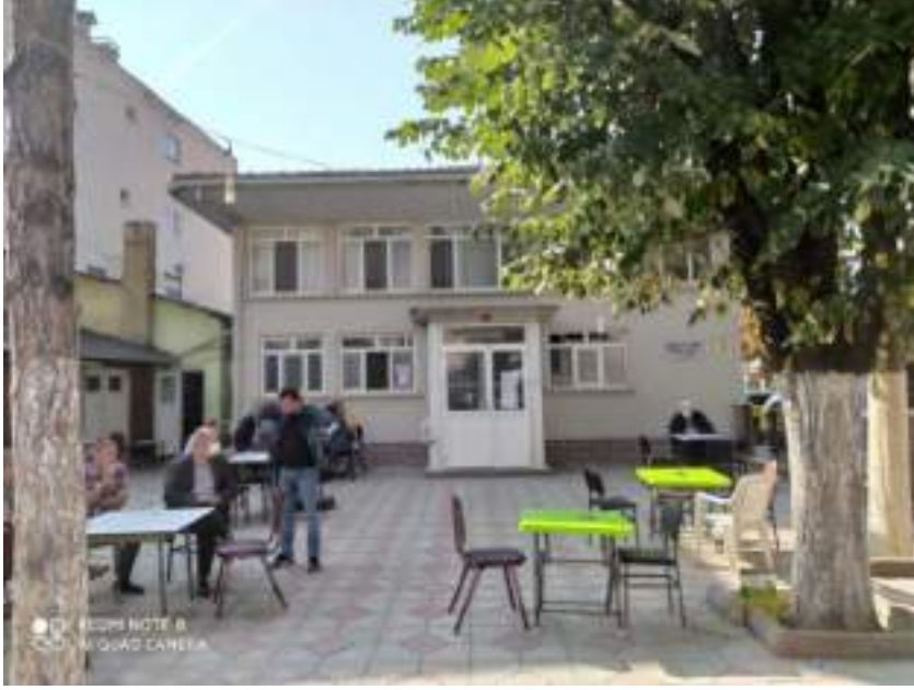
Fotoğraf 1: Kumluk Camisi Kuzey Cephe Genel Görünümü (Kağancan Ayaz'dan)
