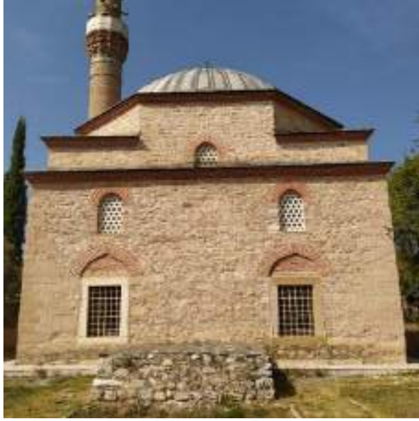
Fotoğraf 120: Sinan Paşa Camisi Güney Cephesi (Kağancan Ayaz'dan)
