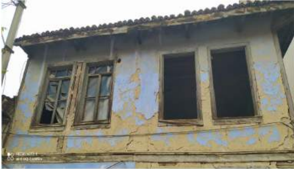
Fotoğraf 233: Ulu Camii Mahallesinde Yer Alan Numarası Bilinmeyen Ev Üst Kat Genel Görünümü (Kağancan Ayaz'dan)
