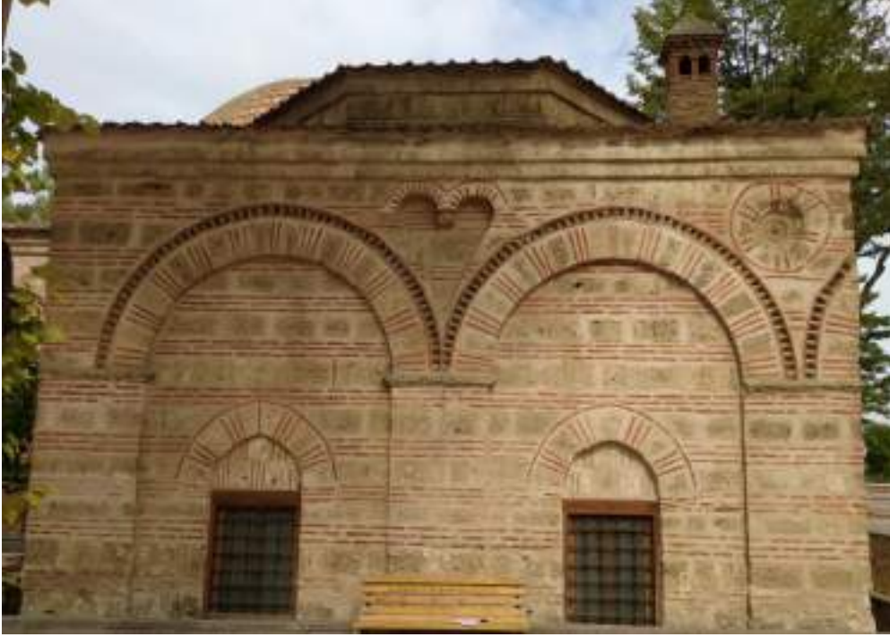
Fotoğraf 28: Postumpost Camisi Güney Cephesi Genel Görünümü (Kağancan Ayaz'dan)
