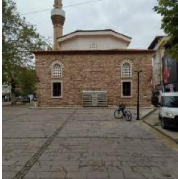
Fotoğraf 45: Voyvoda Çınarlı Camisi Güney Cephesi (Kağancan Ayaz'dan)
