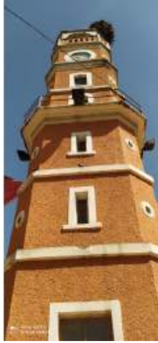
Fotoğraf 164: Yenişehir Saat Kulesi Aşağıdan Yukarıya Görünüm (Kağancan Ayaz'dan)
