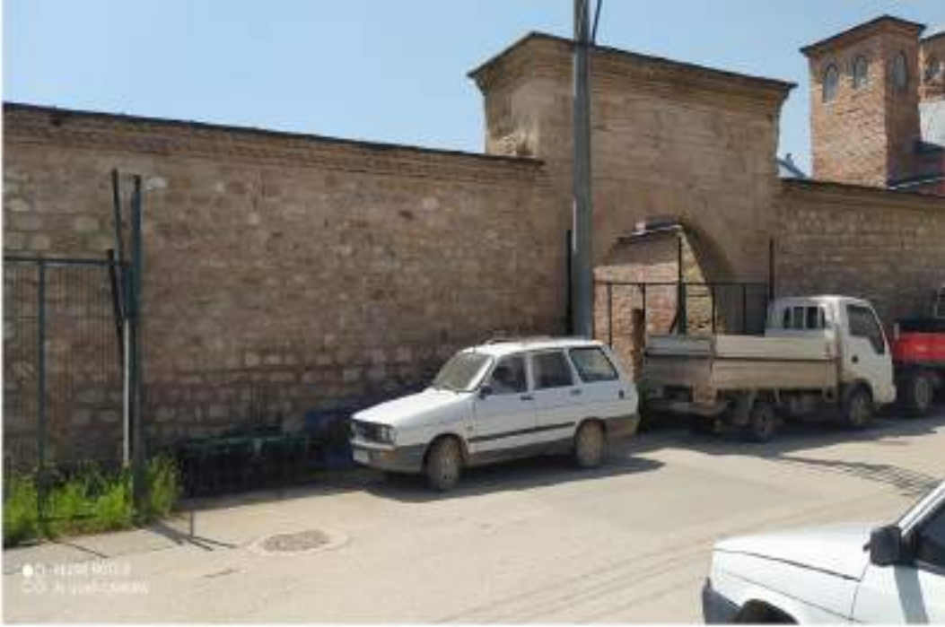
Fotoğraf 146: Sinan Paşa Arastası Olduğu Düşünülen Yapı (Kağancan Ayaz'dan)
