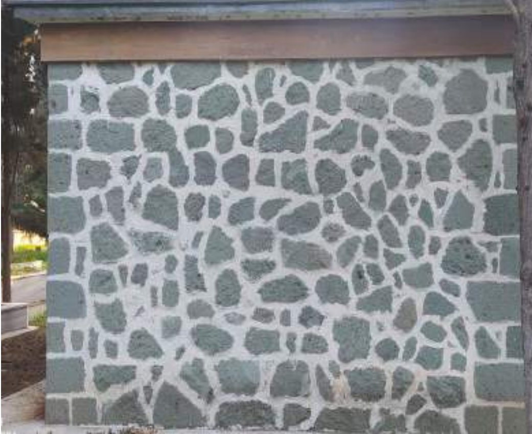
Fotođraf 173: Aydođdu Bey Türbesi Güney Cephesi Görünümü (Kađancan Ayaz'dan)
