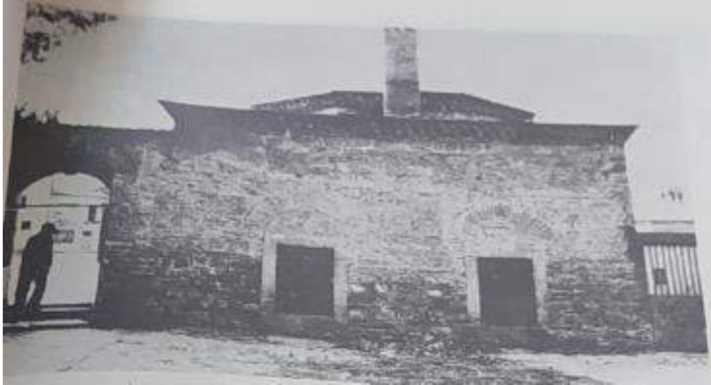
Fotoğraf 141: Sinan Paşa Medresesi A Mekânı Güney Cephe ve Külliye Giriş Kapısı Genel Görünüm (Vakıflar Genel Müdürlüğünden)
