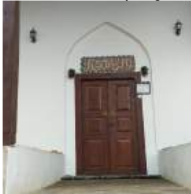
Fotoğraf 13: Yarhisar Ulu Camisi Kuzey Cephede Yer Alan Harim Mekânına Girişi Sağlayan Çift Kanatlı Ahşap Kapı (Kağancan Ayaz'dan)
