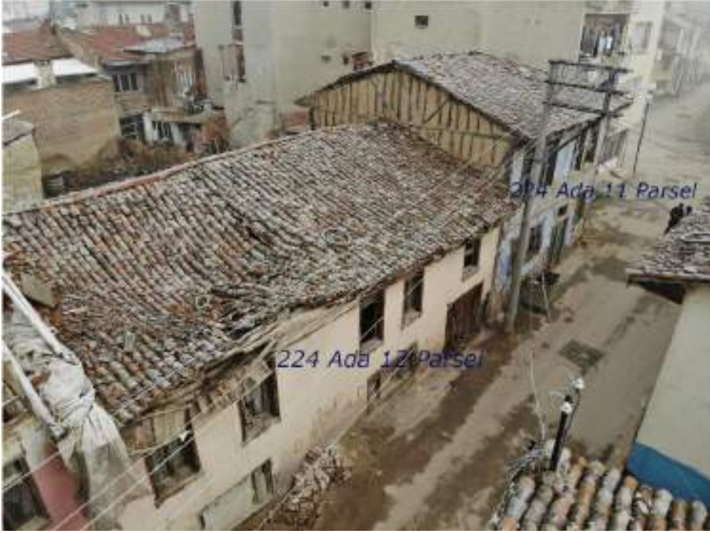
Fotoğraf 116: Ferah Sokak No 2 ve No 4 Parsel 11 Parsel 12 Tescilli Evler Ön Cephe (Yenişehir Belediyesinden)
