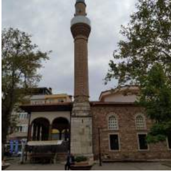
Fotoğraf 47: Voyvoda Çınarlı Camisi Kuzeybatı Cephede Yer Alan Minare Görünümü (Kağancan Ayaz'dan)
