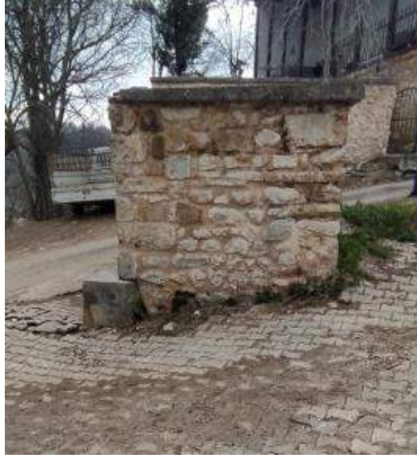
Fotoğraf 74: Yarhisar Çeşmesi Batı Cephesi (Kağancan Ayaz'dan)
