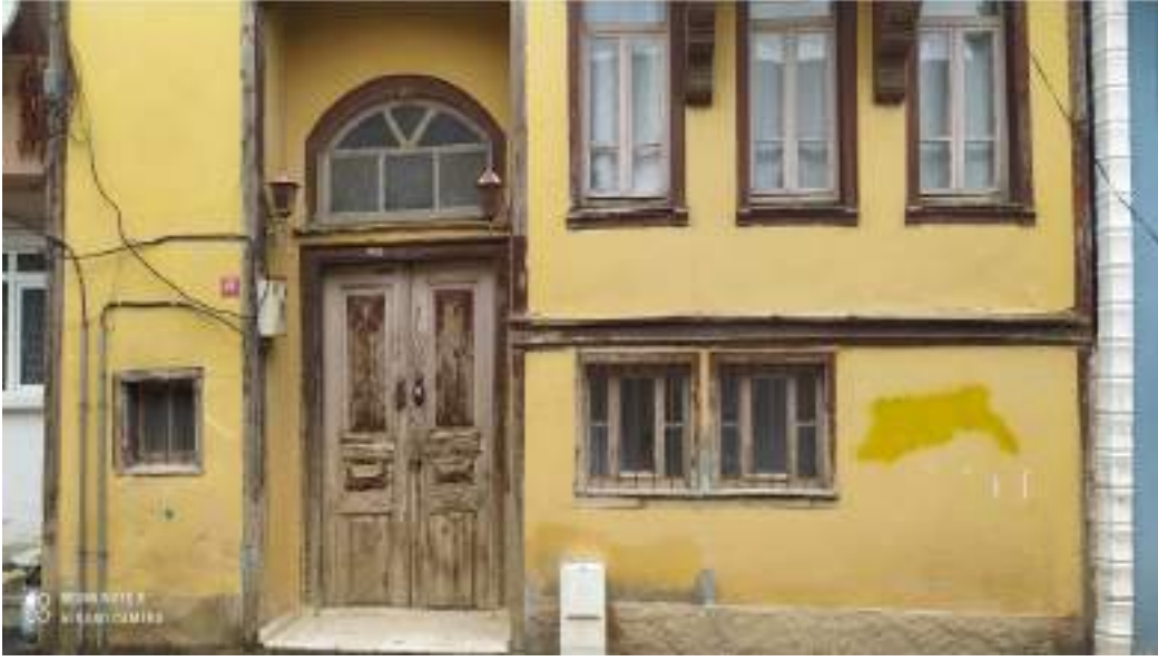
Fotoğraf 226: 27 Nolu Ev Genel Görünümü(Kağancan Ayaz'dan)
