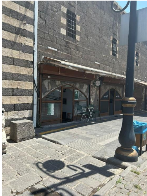
Şekil 4.5. Kervansaray Otel Dükkanlar Görünüş (Yazarın Arşivinden)
