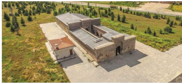
Şekil 2.7. Konya Kuruçeşme Han Havadan Görünüş (URL-7)
