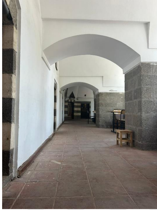
Şekil 4.9. Kervansaray Otel Revaklı Koridor Görünüşü (Yazarın Arşivinden)
