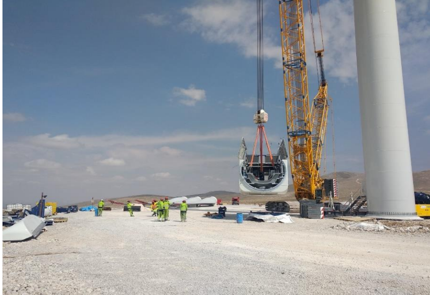
Şekil 2.3. Bağlar rüzgâr santrali nasel inşa aşaması
