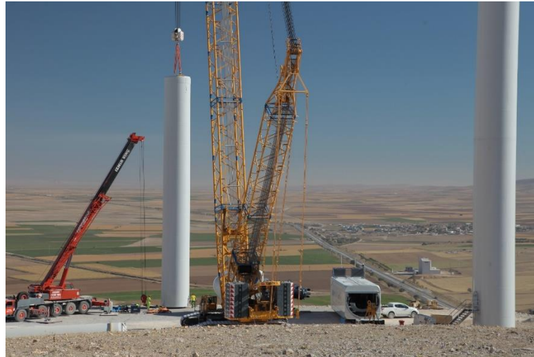
Şekil 2.4. Bağlar rüzgâr santrali kule inşa aşaması
