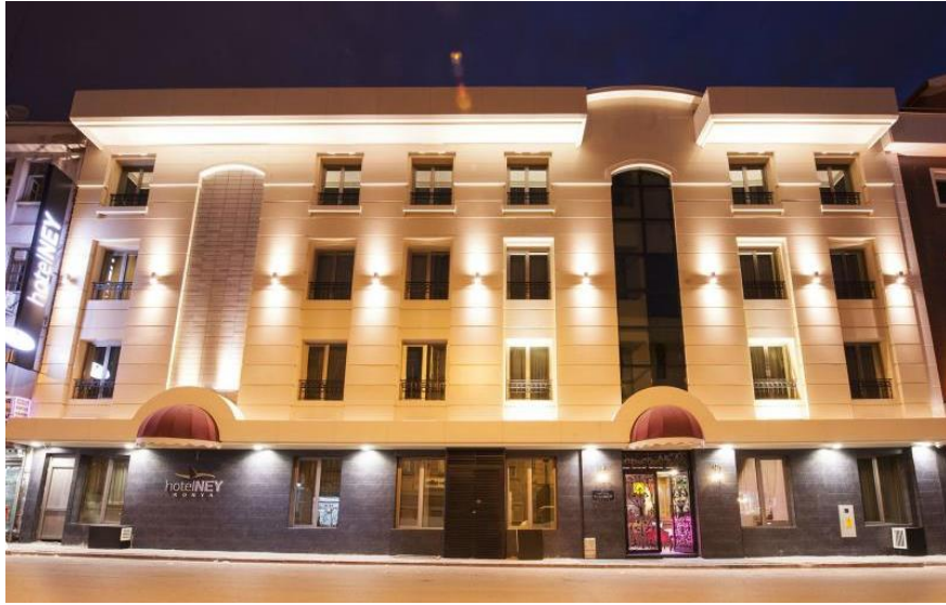
Şekil 4.30. Ney Otel cephesi (URL-25)
