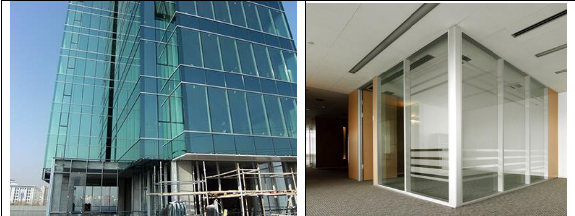
Resim 9. Giydirme Cephe ve Cam Bölme Duvar Sistemleri(URL-12)
