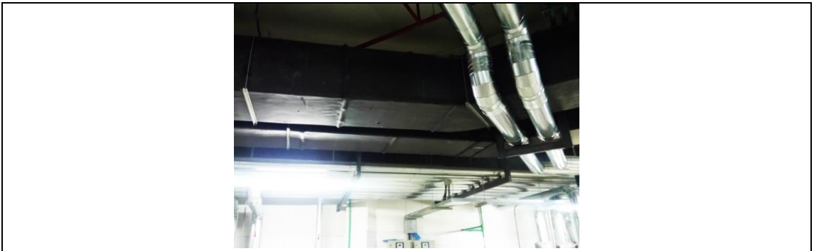
Resim 11. HVAC Montaj ve Yalıtımı (Seher Öz Arşivi, 2018)
