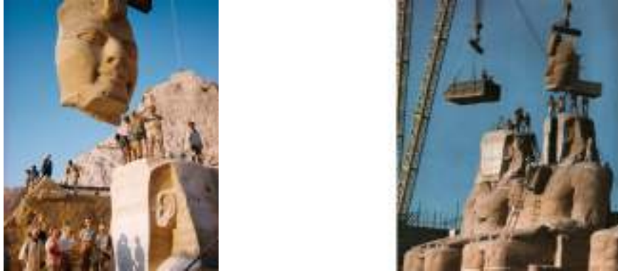
Şekil 2.3. Abu Simbel Tapınakları'nın taşınması (Kaynak:Url 3-4)
