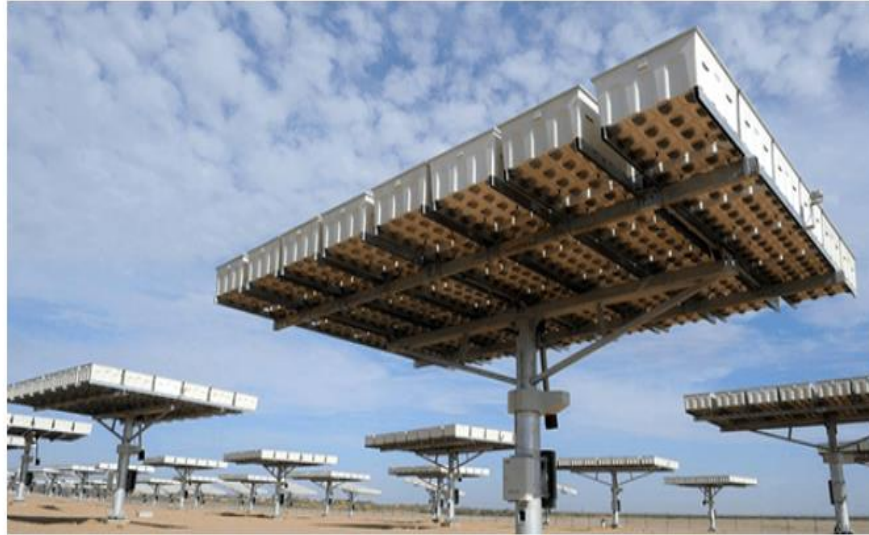
Şekil 4.5. Çift eksenli güneş takip sistemi (URL05)
