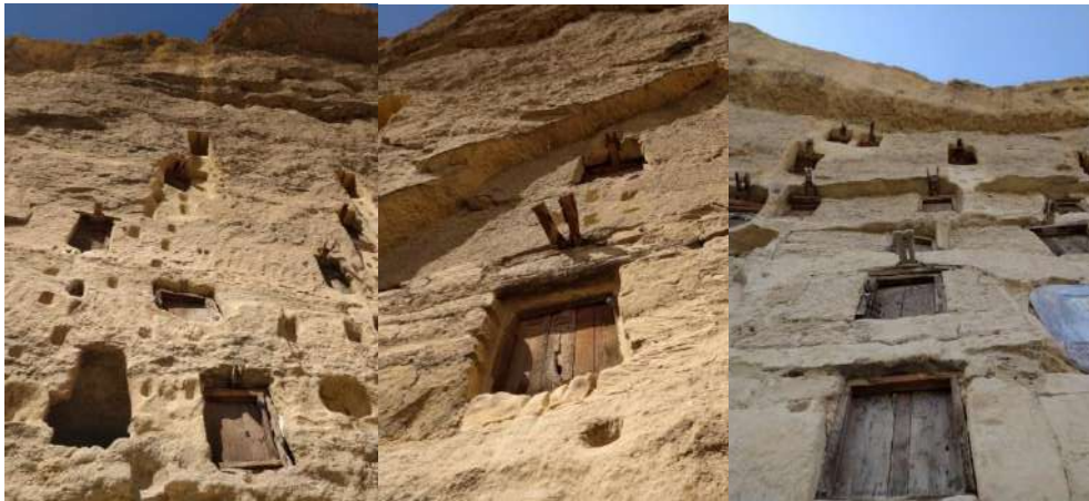
Şekil 3.16. Tahıl Ambarları Tutamak, Sekemek ve Makara Sistemi Detayları (Yazarın Arşivinden, 2021).
