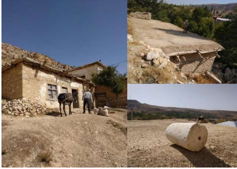
Şekil 3.37. Düz Toprak Dam Konut ve Yuvak Taşı (Yazarın Arşivinden, 2021).
