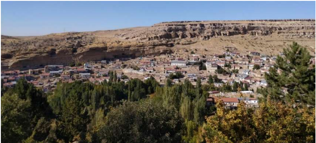
Şekil 3.34. Teraslanmış Şekilde İnşa Edilen Konutlar (Yazarın Arşivinden, 2021).
