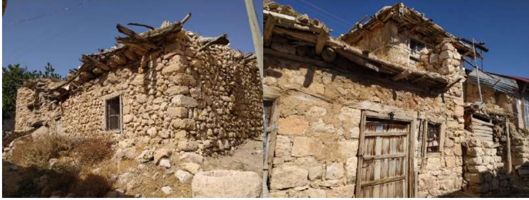
Şekil 3.42. Taş, Toprak ve Ahşap Malzeme ile İnşa Edilmiş Konutlar (Yazarın Arşivinden, 2021).
