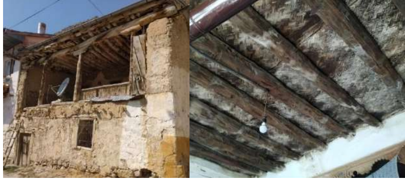
Şekil 3.36. Toprak Dam Detayları (Yazarın Arşivinden, 2021).
