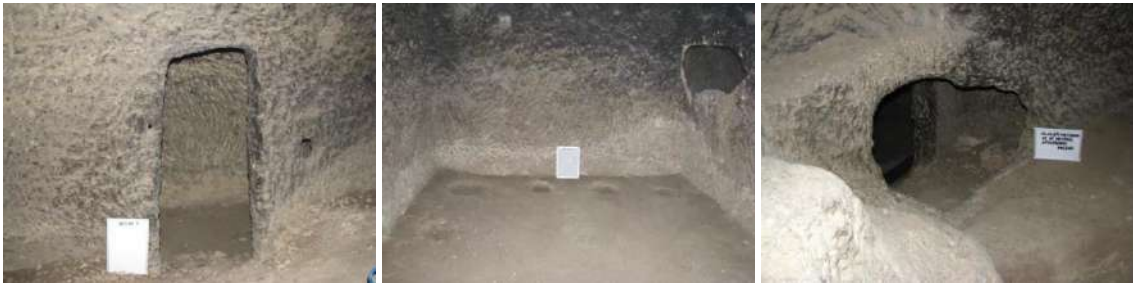
Şekil 3.31. Ölüler Meydanı'nda Yer Alan 9 ve 23 Numaralı Hücre ile At Meydanı ile Arasında Yer Alan Mezar (Taşkale Koruma Raporu).
