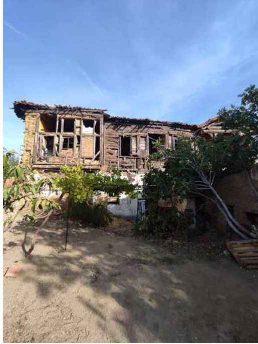
Resim 5 Hacı Kabakçılar Konağı arka cephe
