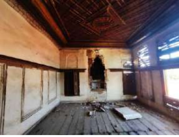
c) Odanın kuzey duvarı
