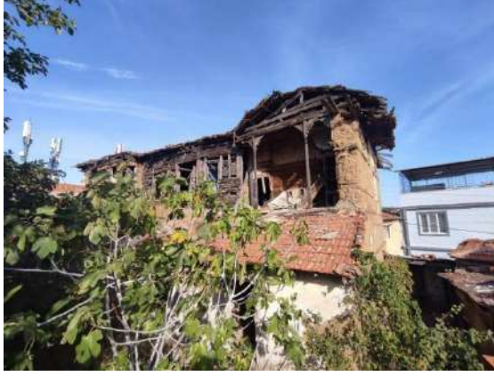
Resim 4 Hacı Kabakçılar Konağı Avlu Yönünden Görünüşü
