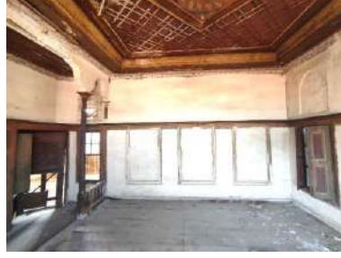
b) Odanın batı duvarı
