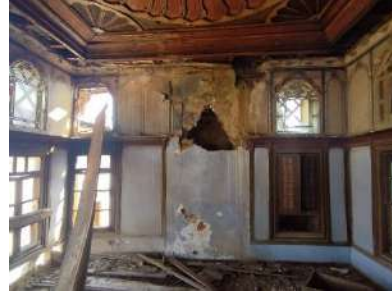
b) Odanın güney duvarı
