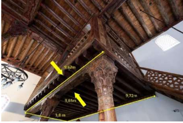
Resim 14: Bey Mahfilinde ahşap yapıların boyutları
