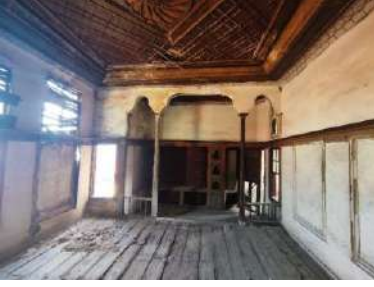
a) Odanın güney duvarı
