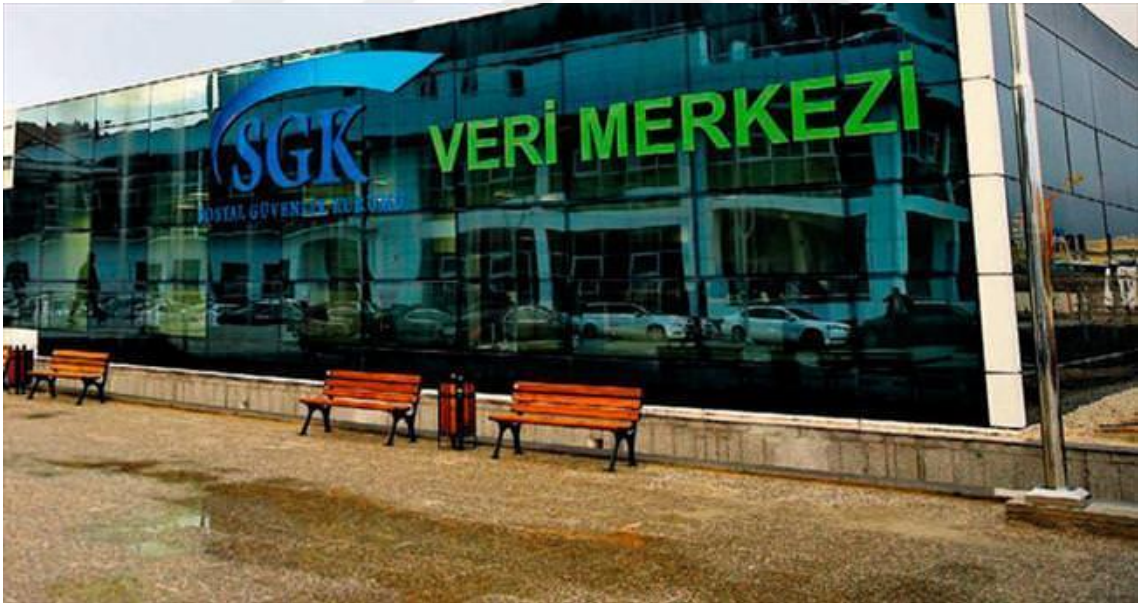
Şekil 4.14. SGK Batıkent Veri Merkezi (SGK, 2016)
