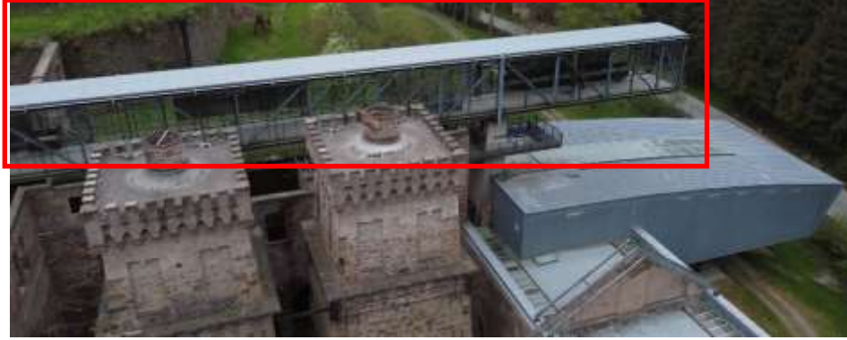
Şekil 2.9. Eski Demir Fabrikasının Kültür Merkezi Olarak Kullanımında İhtiyaç Sonucu Uygulanan Ek Yapı (Mısırlısoy, 2011).
