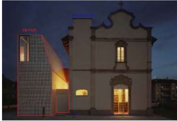
Şekil 3.4. Tarihi Yapı-Ek Yapı İç İçe Şekillenmiş Örneği Elsa Morante Kütüphanesi (URL:12)
