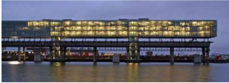
Şekil 4.18. Kranpoor Ofis Binaları Yeniden Kullanımı (URL19)
