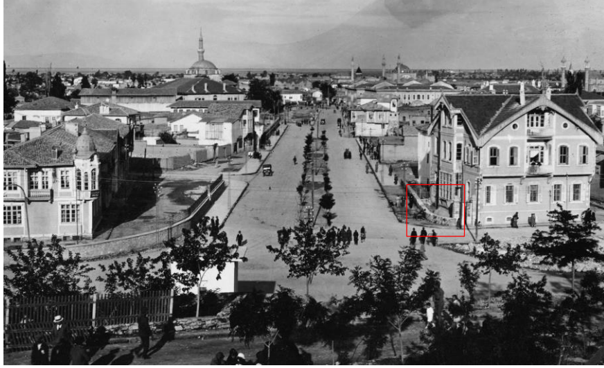
Resim 4.25 Alaaddin Bulvarı'nın açıldığı ilk yıllarda Yusuf ŞAR Konağı (Uz ve Doğan, 2010)
