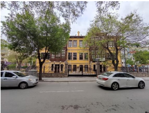
Resim 4.132 Mimarlar Odası'nın cephe verdiği 345 ada 11 parseldeki Eski Kız Orta Okulu Binası
