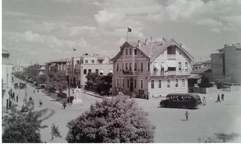
Resim 4.20 1940-1950 yılları arasında Yusuf ŞAR Konağı-Eski Belediye Binasının çevresi (Civelekoğlu, 2017)
