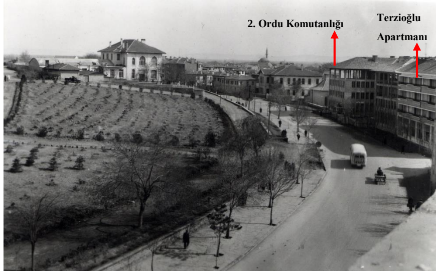
Resim 4.40 Alaaddin Tepesi, 2. Ordu Komutanlığı binasının inşası (Acar, 2025)
