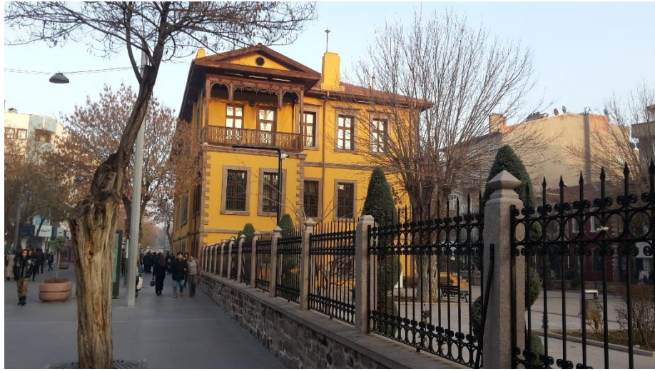
Resim 4.113 Eski Kız Ortaokulu kuzeybatı görünümü (Kaçar Demirbaş Arşivi, 2019)
