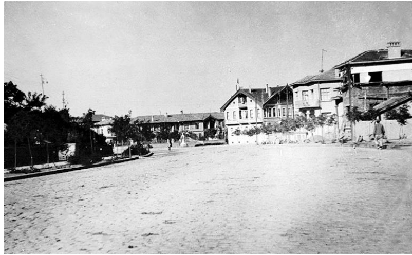
Resim 4.29 Eski Belediye Binası (Yusuf ŞAR Konağı) güney ve batı cepheleri (Ataberk, t.y.)
