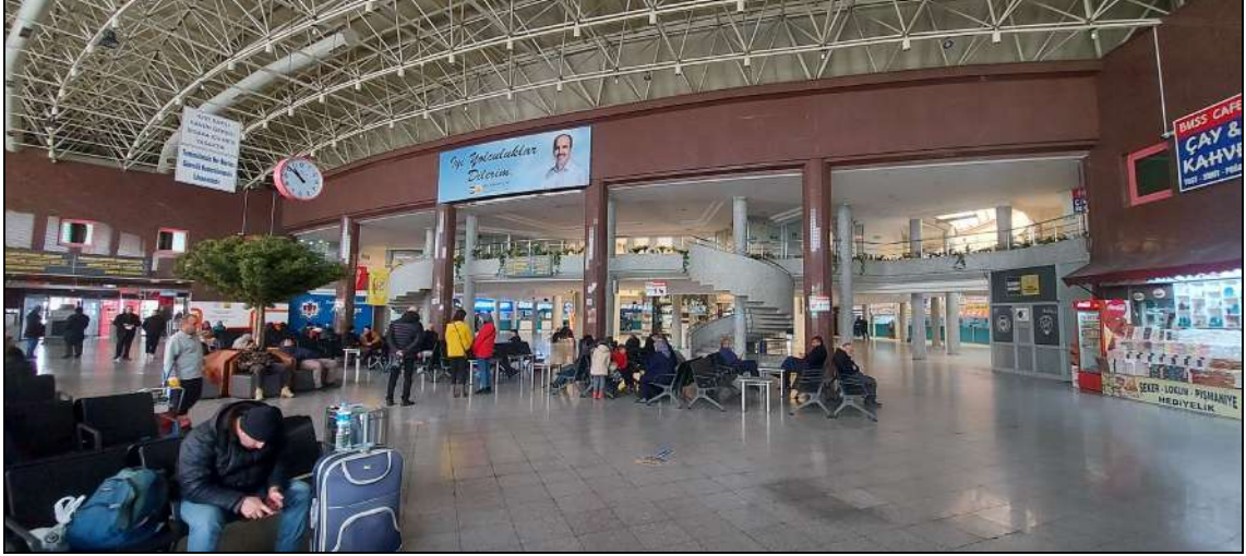
Şekil 4.48. Konya Otogarı Bozulan Zemin Kaplamaları (Yazar Arşivi)
