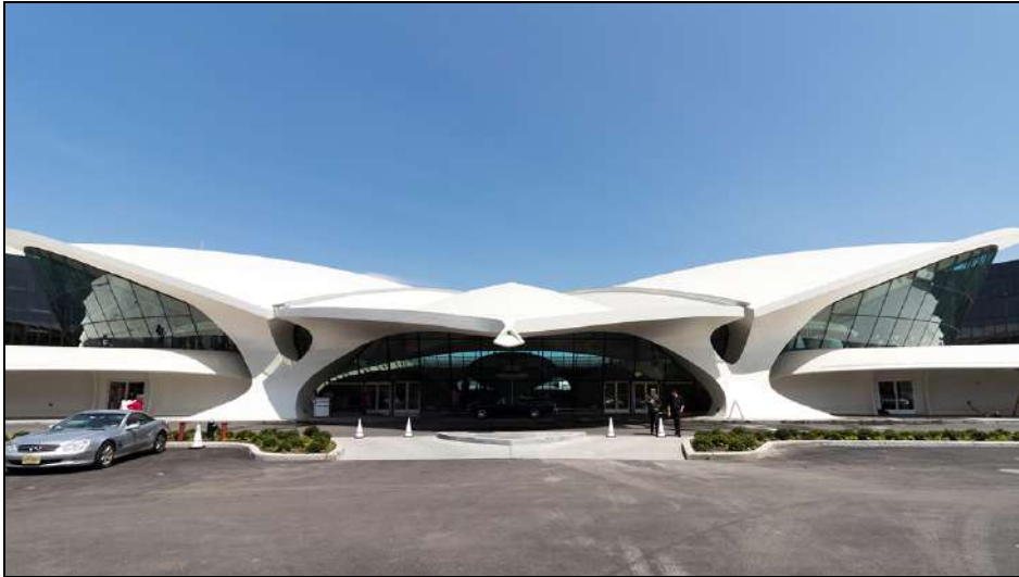
Şekil 3.29. TWA Hotel Yenilenen Beton ve Cam Yüzeyler (URL-14)
