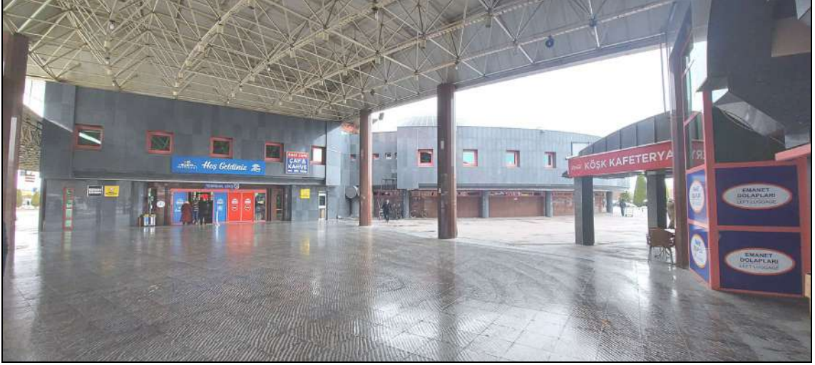
Şekil 4.44. Konya Otogar Batı Cephesi (Yazar Arşivi)
