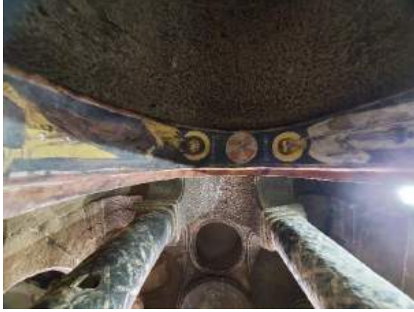
Fotoğraf 114 – Kuzey Duvarı Mezar Nişi
