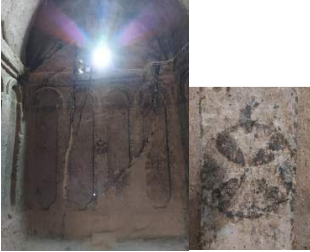
Fotoğraf 96 – Narteks Mekanı Güney Duvarları
