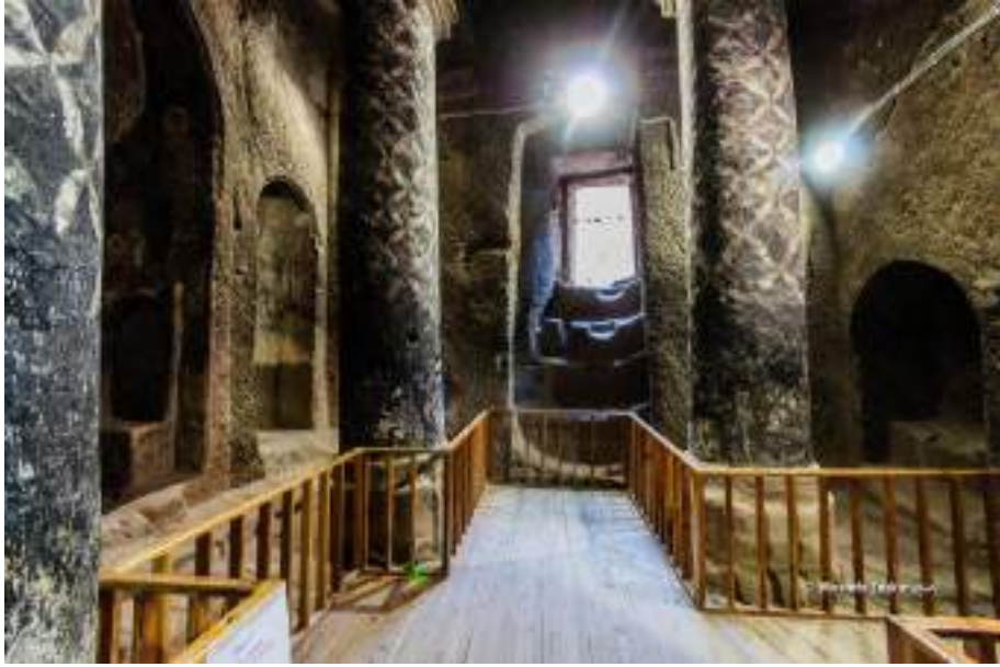
Fotoğraf 100 – Ana Kilise Mekanı Güney Duvarı
