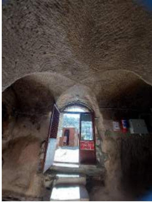
Fotoğraf 64- Giriş Holü Örtü Sistemi
