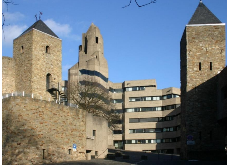
Şekil 3.10. Bensberg Belediye Binası (URL 6)
