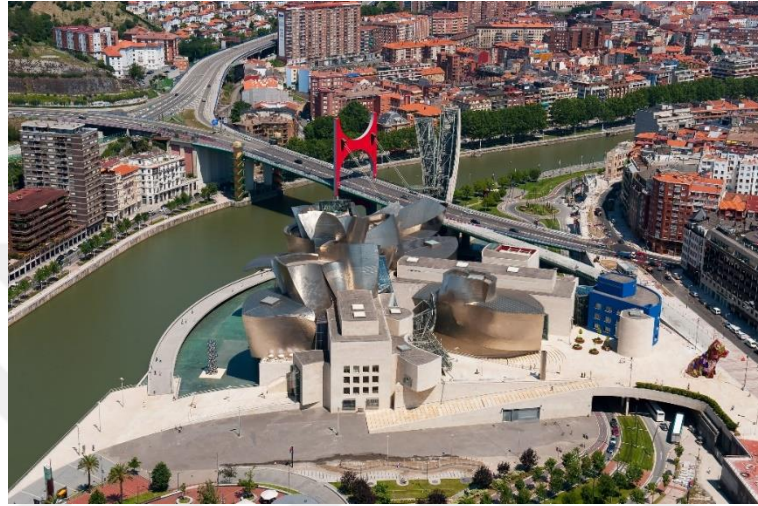
Şekil 4.9. Guggenheim Bilbao Müzesinin Girişine Bakan Cehesi (URL 29)
