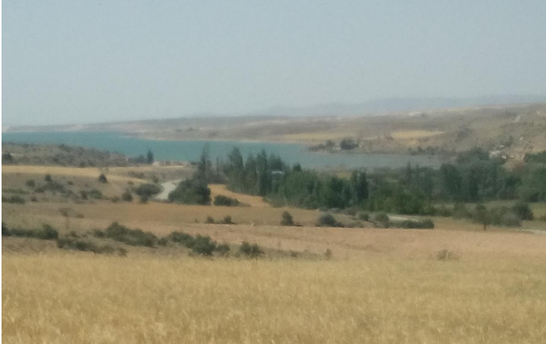
Foto 18: Yeşildere'nin aşağı çıkışında yer alan İbrala (Yeşildere) Barajı kuzeydoğu-güneybatı.
