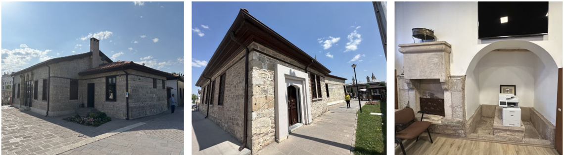
Şekil 4.29. Çelebi Dairesi ve bitişikinde bulunan fırın binası ile fırının iç mekânında bulunan ocak detayı (Leyla Betül Küçük Arşivi, 2025)
