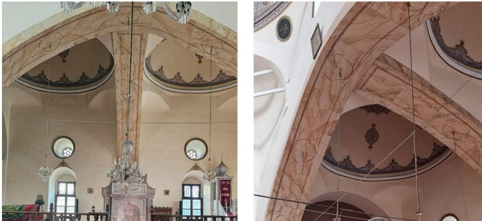
Şekil 4.49. Nadir görülen inşa yöntemlerinden olan kemer bindirme tekniğinin semâhâne içerisinden ve yakından fotoğrafları (Kişisel Arşiv, 2025)
