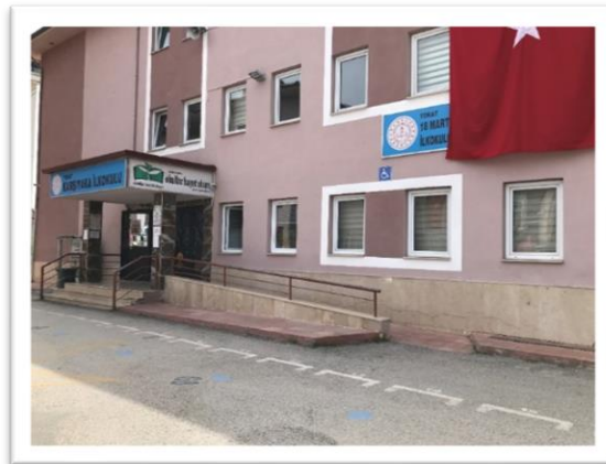
Şekil 4.37. Tokat Karşıyaka İlkokulu bina girişi rampa sistemi
