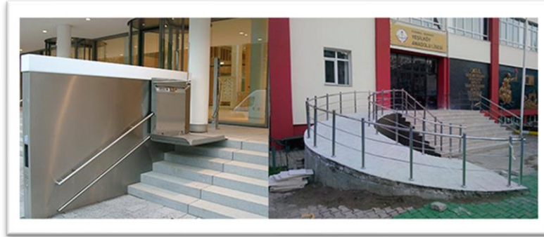
Şekil 2.12a. Platform asansör (URL 5) Şekil 2.12b. Engelli rampası (URL 6)
