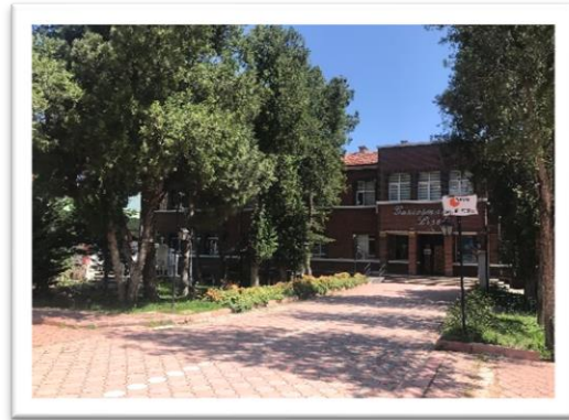
Şekil 3.7. Tokat Gazi Osman Paşa Lisesi Yeni Hali (URL 24)
