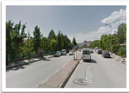
Şekil 4.93. Tokat Güzel Sanatlar Lisesi önünde bulunan yol (URL 21)
