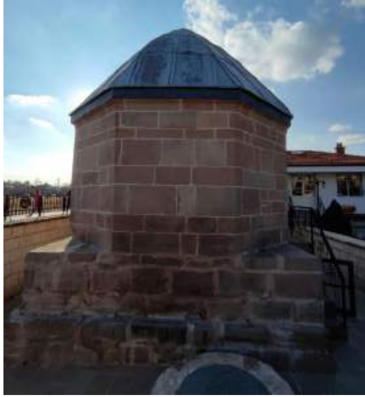
Fotoğraf 95: Ateşbâz-ı Veli Türbesi Doğu Cephesi
