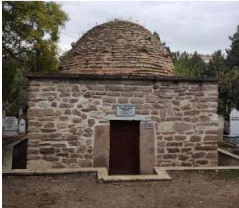
Fotoğraf 135: Evhadü'd-Din Hamid Bin Ebulfahır Kirmanî Türbesi Ana Cephesi
