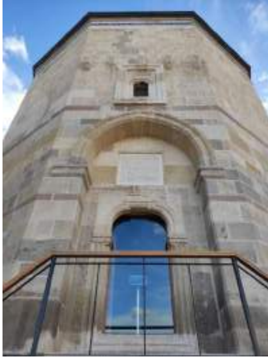
Fotoğraf 3: II. Kılıçarslan Kümbeti Kuzeydoğu Cephe Ana Giriş
