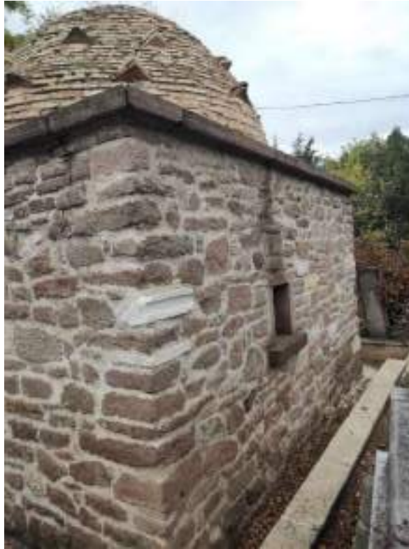
Fotoğraf 141: Evhadü'd-Din Hamid Bin Ebulfahr Kirmanî Türbesi Güney Cephesi
