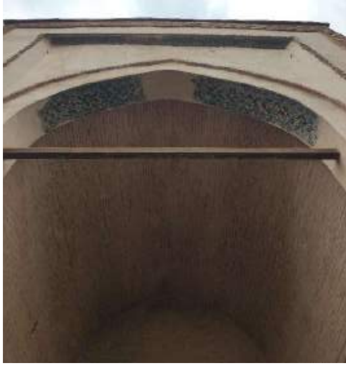
Fotoğraf 181: Gömeç Hatun Türbesi (Kız Kulesi) Giriş Açılışı Kemer
