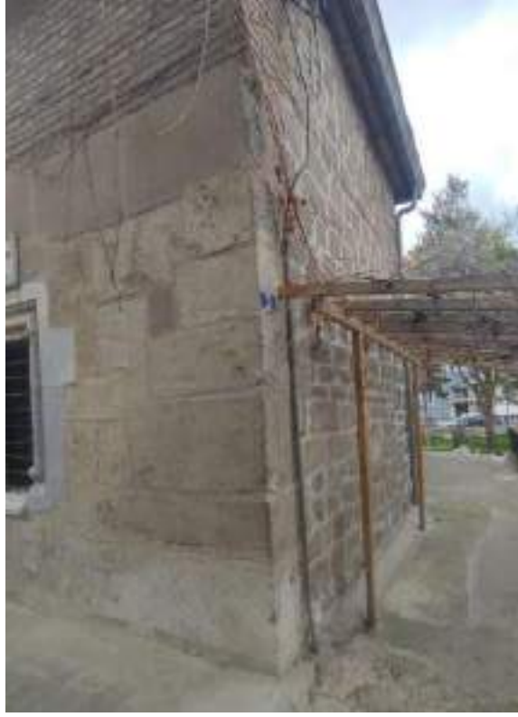
Fotoğraf 146: Beyhekim Türbesi Kuzey ve Doğu Cephesi
