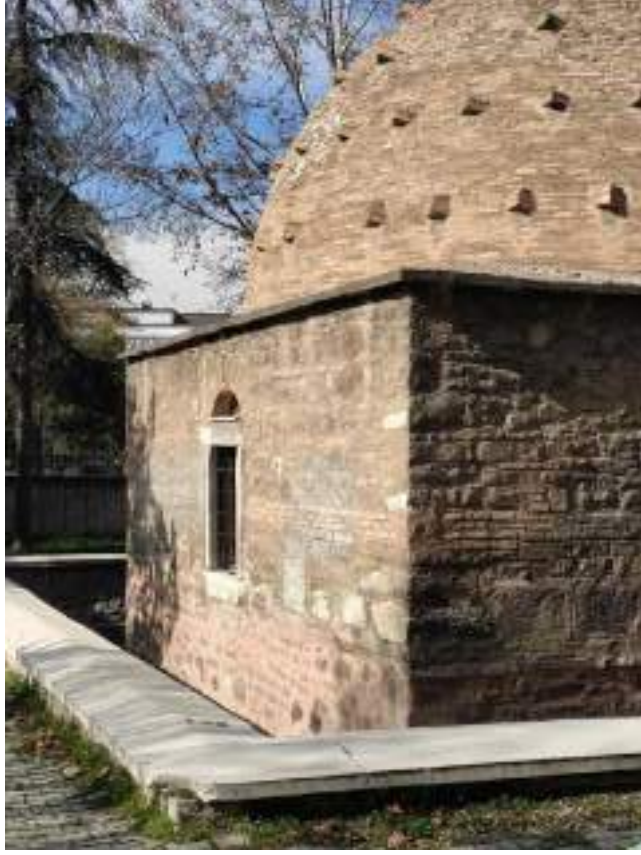
Fotoğraf 205: Turgutoğlu Türbesi Batı Cephesi
