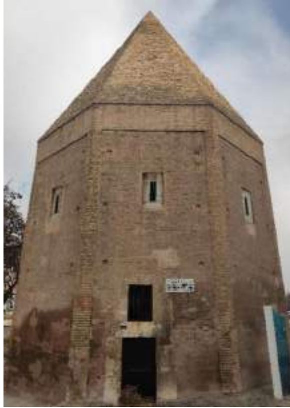
Fotoğraf 48: Emir Seyfeddin Karasungur Kumbeti Batı Cephesi İkinci Giriş Açıklığı
