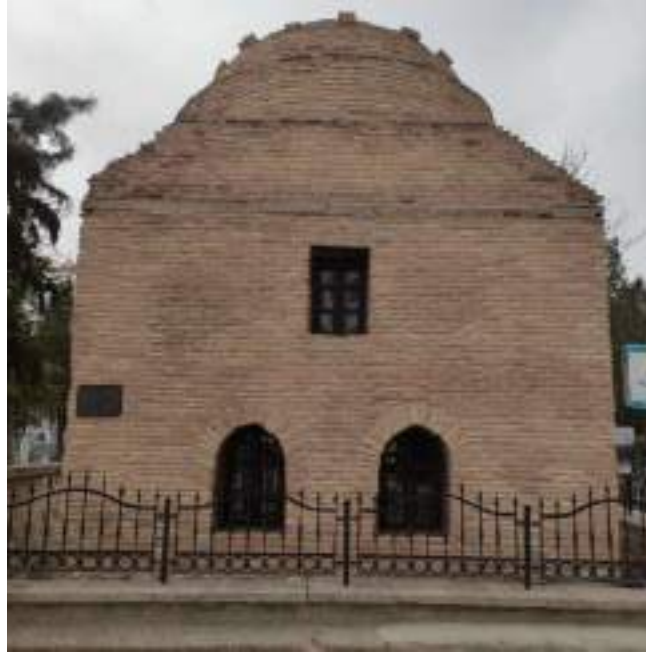
Fotoğraf 70: Hocacihan Türbesi Kuzey Cephesi
