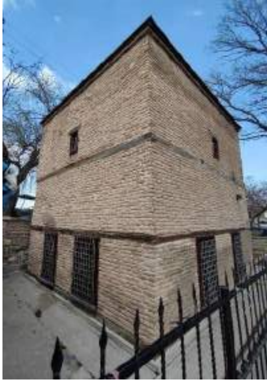
Fotoğraf 36: Pir Esad (Pisili) Türbe Batı ve Kuzey Cephe
