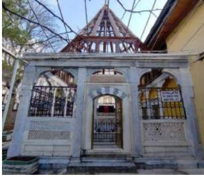
Fotoğraf 54: Şeyh Sadrettin Konevi Türbesi Ana Cephesi
