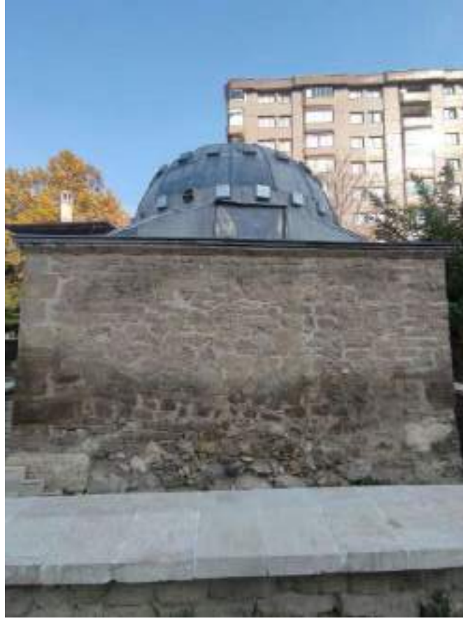
Fotoğraf 133: Halkabegüş Türbesi Güney Cephesi
