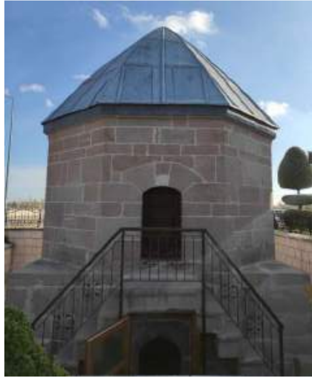
Fotoğraf 92: Ateşbâz-ı Veli Türbesi Ana Cephesi
