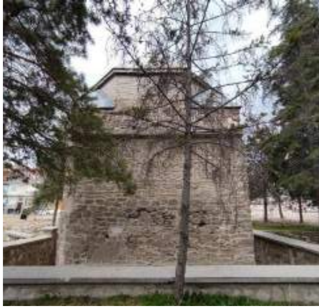
Fotoğraf 222: Şeyh Osman-ı Rumi Türbesi Batı Cephesi
