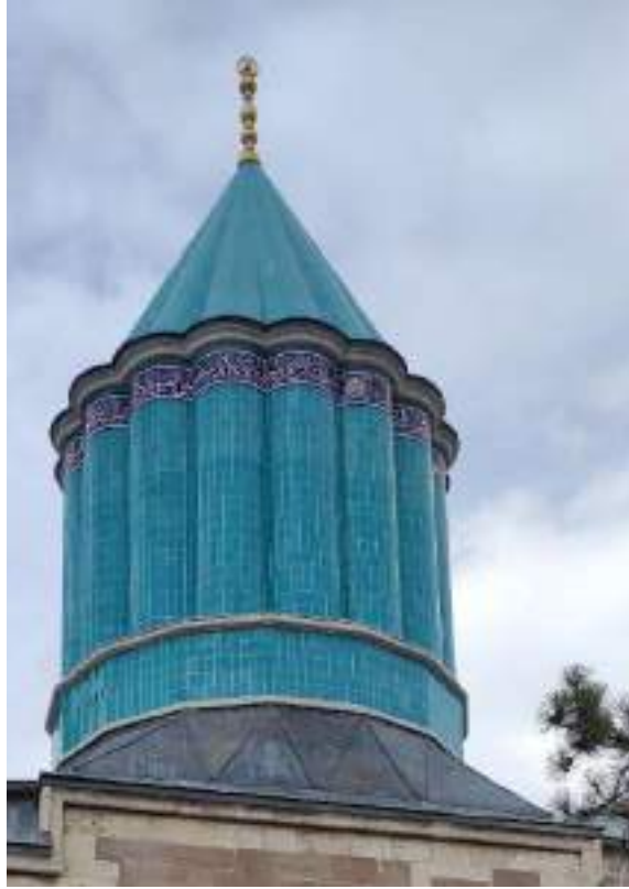
Fotoğraf 66: Mevlâna Türbesi Üst Örtü Sistemi
