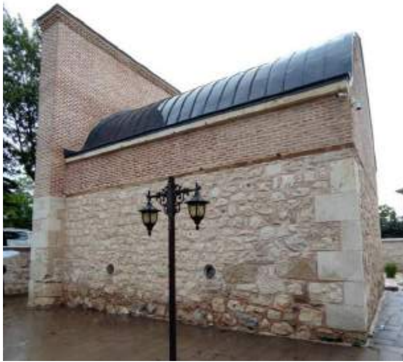
Fotoğraf 170: Bedreddin Gühertaş (Gevhertaş) Türbesi Doğu ve Güney Cephe
