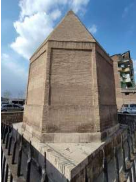
Fotoğraf 117: Sephevan (Emir Nureddin) Türbesi Güneybatı Cephe
