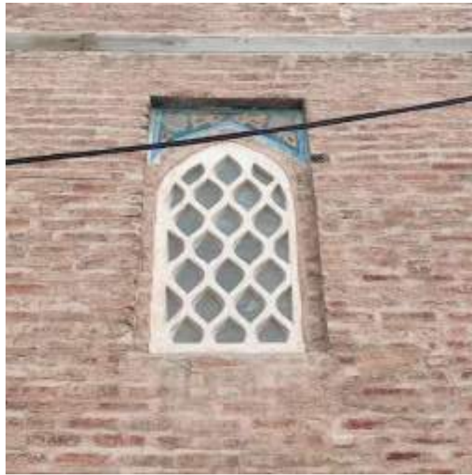
Fotoğraf 124: Siyavuş Sultan Türbesi Kuzey Cephe Penceresi
