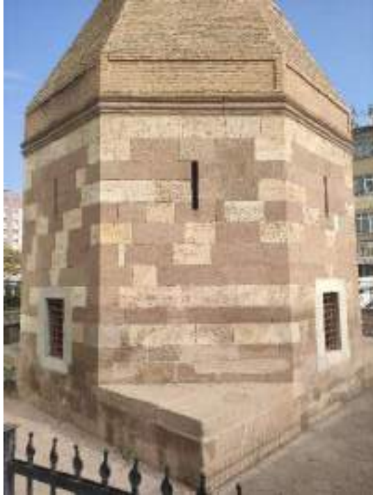
Fotoğraf 192: Ulaş Baba Kümbeti Kuzeydoğu Cephesi
