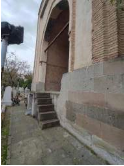
Fotoğraf 179: Gömeç Hatun Türbesi (Kız Kulesi) Ana Cephesi
