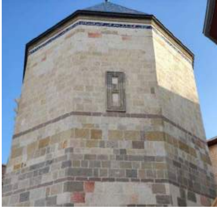
Fotoğraf 9: II. Kılıçarslan Kümbeti Dokuzuncu Duvar Yüzeyinde Bulunan Kapatılmış Mazgal Pencere
