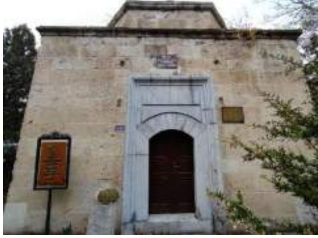
Fotoğraf 197: Şeyh Şücaeddin Türbesi Ana Cephesi
