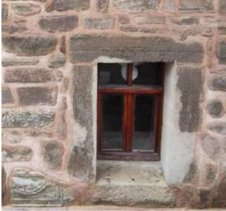
Fotoğraf 106: Şeyh Alaman (Ulema) Türbesi Pencere Açıklığı ve Devşirme
