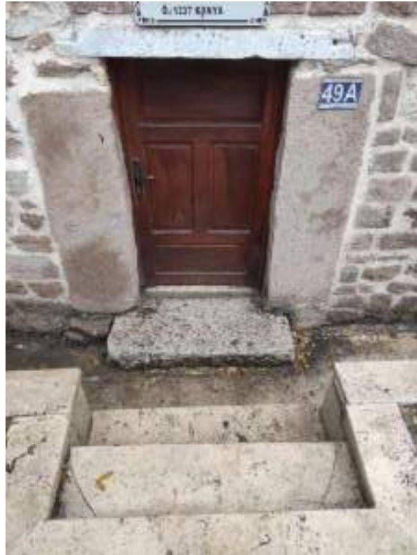
Fotoğraf 137: Evhadü'd-Din Hamid Bin Ebulfahır Kirmanî Türbesi Merdivenler
