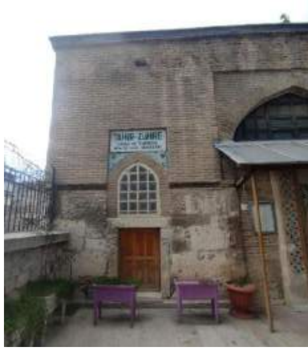
Fotoğraf 150: Tahir ile Zühre Türbesi Ana Cephesi
