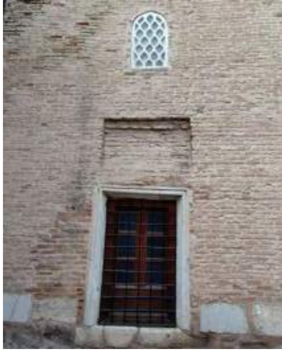
Fotoğraf 127: Siyavuş Sultan Türbesi Güney Cephesi Detay
