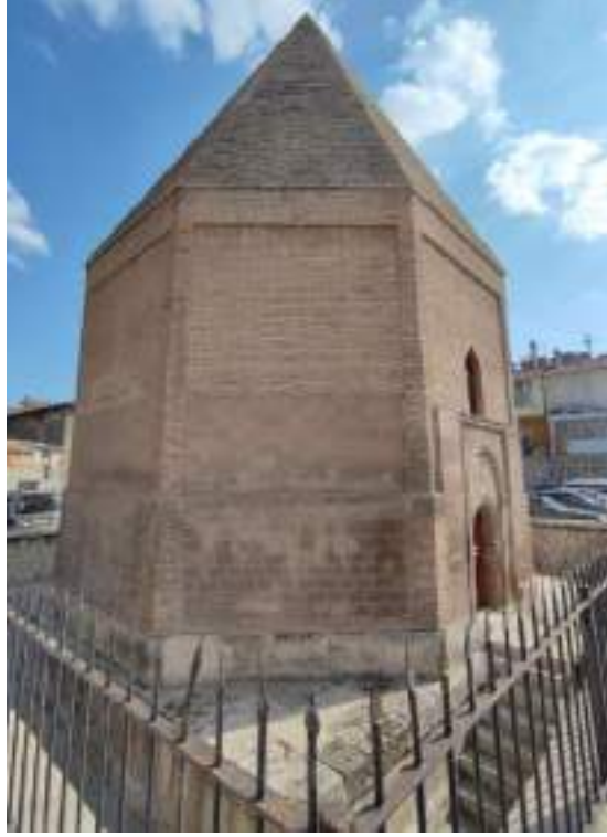
Fotoğraf 116: Sephevan (Emir Nureddin) Türbesi Kuzeydoğu Cephe
