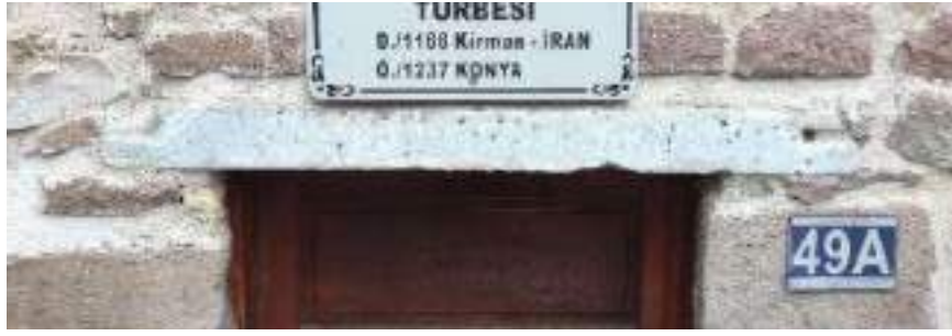
Fotoğraf 138: Evhadü'd-Din Hamid Bin Ebulfahır Kirmanî Türbesi Giriş Açıklığı Devşirme Lento Parça
