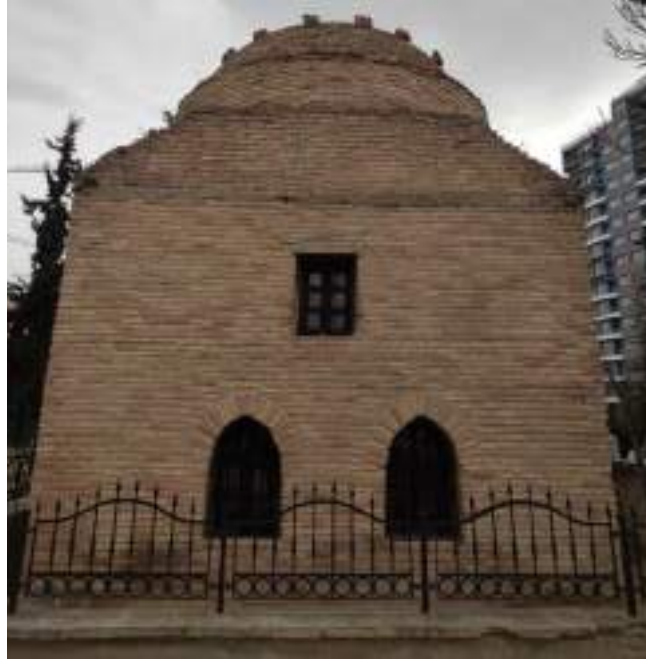
Fotoğraf 71: Hocacihan Türbesi Doğu Cephesi
