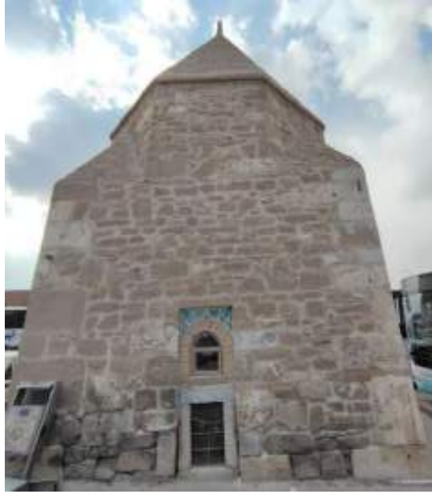
Fotoğraf 214: Fakih Dede Türbesi Doğu Cephe
