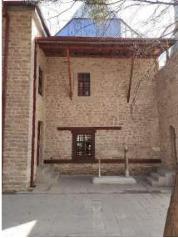
Fotoğraf 227: Şemsi Tebrizi Türbesi Kuzey Cephesi
