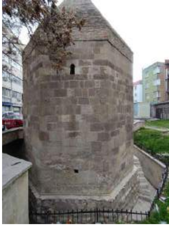
Fotoğraf 41: İç Karaaslan Kümbeti Kuzey Cephesi
