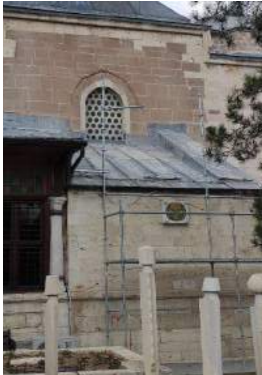
Fotoğraf 65: Mevlâna Türbesi Güney Duvarı Ayrıntı
