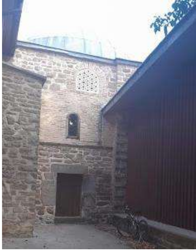
Fotoğraf 78: Sahip Ata Türbesi Batı Cephe Giriş Açıklığı
