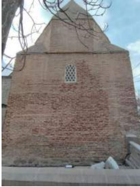
Fotoğraf 125: Siyavuş Sultan Türbesi Doğu Cephesi
