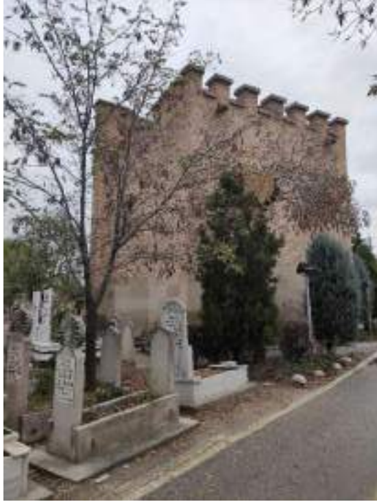
Fotoğraf 176: Gömeç Hatun Türbesi (Kız Kulesi) Genel Görünüş
