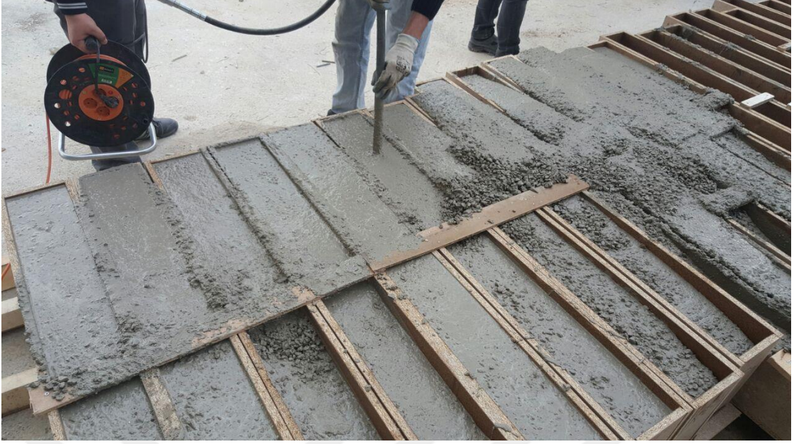
Resim 3.3.7. Beton dökümü – vibrasyon
