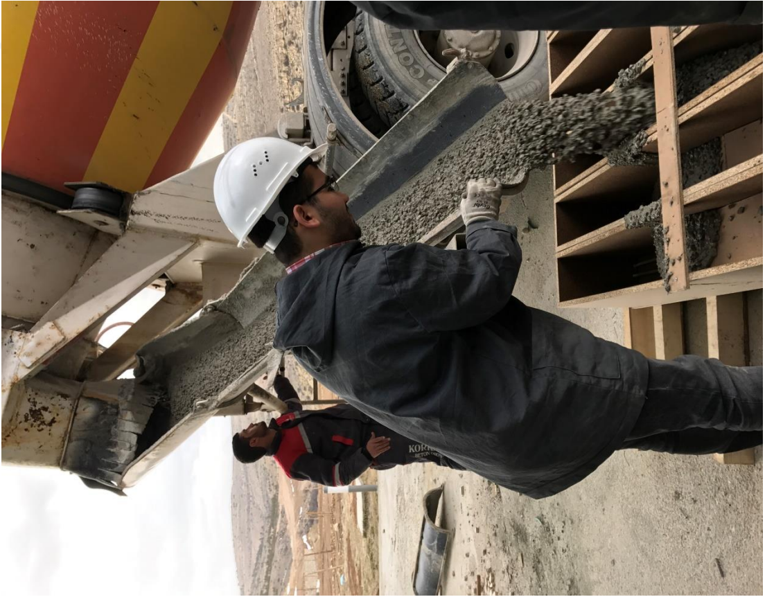
Resim 3.3.6. Beton dökümü
