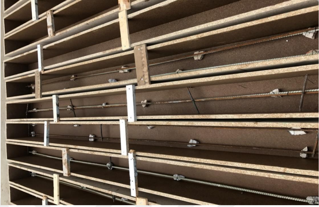
Resim 3.3.4. Donatların kalıplara yerleştirilmesi
