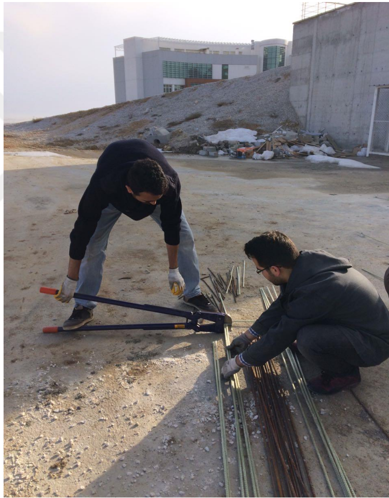
Resim 3.3.3. Donatıların kesilmesi
