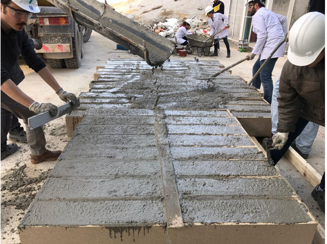
Resim 3.3.8. Beton yüzeyinin düzlenmesi
