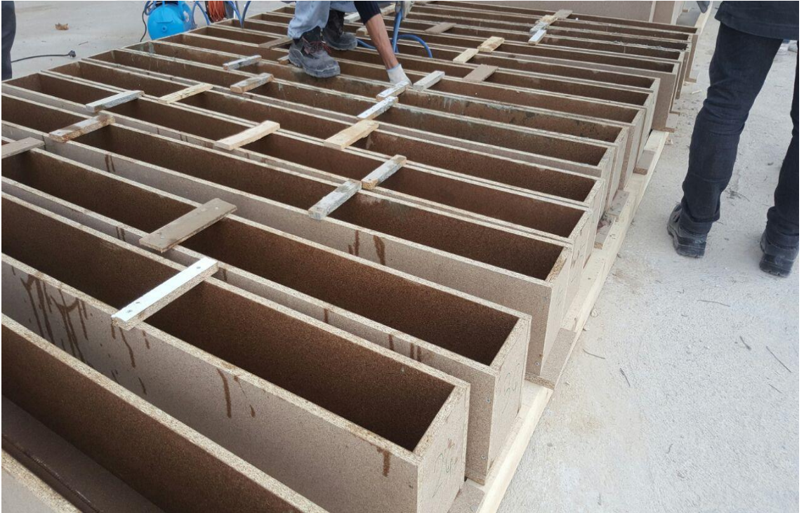
Resim 3.3.2. Kalıpların temizlenmesi ve yağlanması
