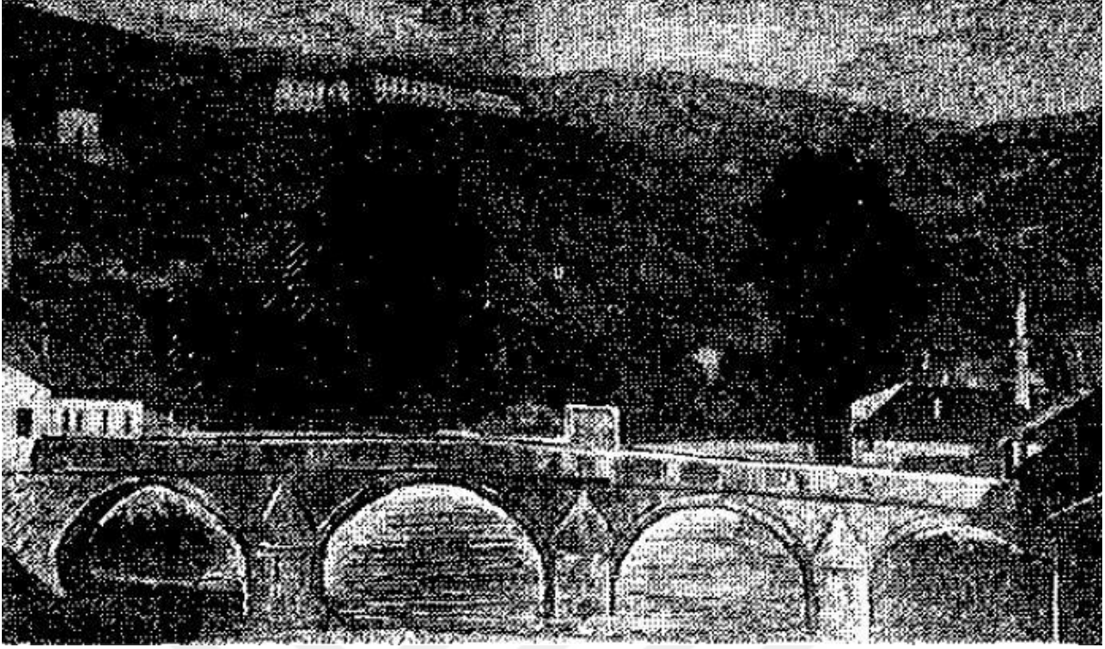
Fotoğraf: 24 Hünkâr köprüsü. (M.Müezzinoğlu)
