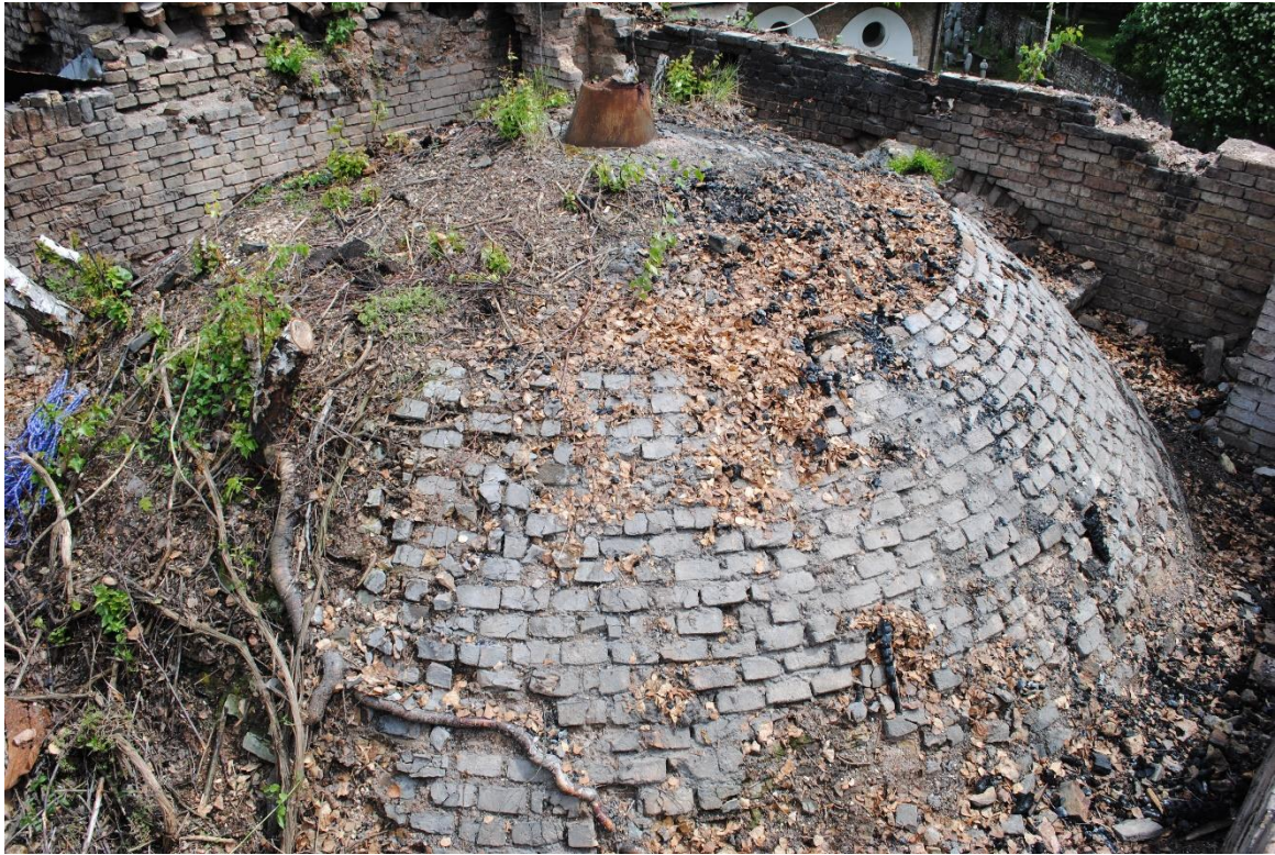
Fotoğraf: 57 İsa Bey Hamamı restorasyon öncesi sıcaklık bölümü kubbe üstü çürütme işlemi. 2013
