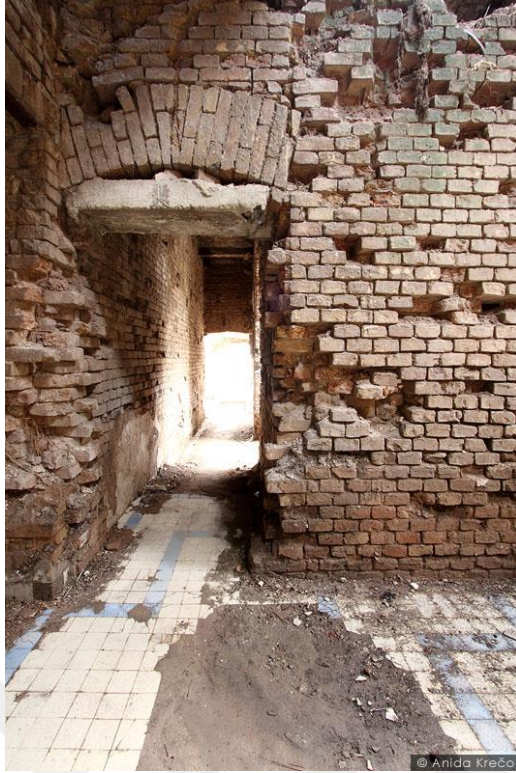
Fotoğraf: 77 İsa Bey Hamamı yenileme esnasında, derz çalışması. 2013
