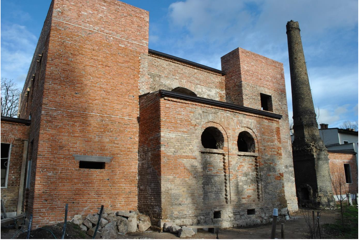
Fotoğraf: 91 İsa Bey Hamamı dođu cephe.
