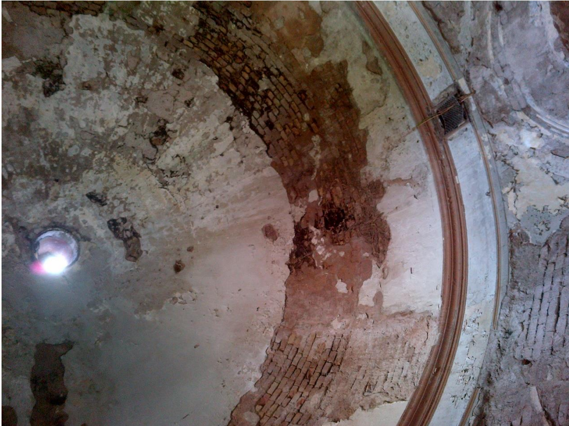
Fotoğraf: 63 İsa Bey Hamamı yenileme esnasında, iç kubbe temizleme çalışması. 2013
