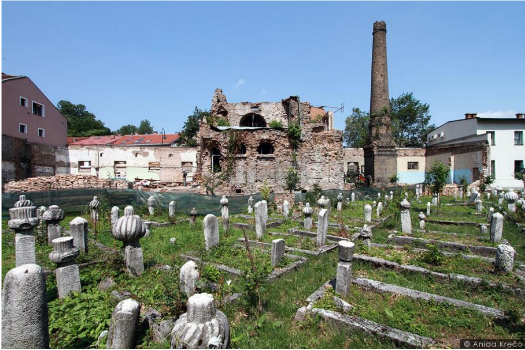
Fotoğraf: 88 İsa Bey Hamamı restorasyon esnasında, sökülme işleri ve derz çalışması. 2013
