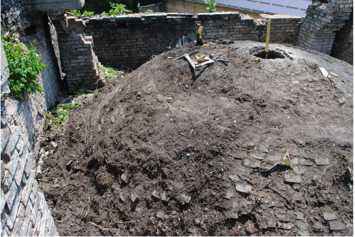
Fotoğraf: 62 İsa Bey Hamamı yenileme esnasında, kubbe temizleme çalışmaları. 2013
