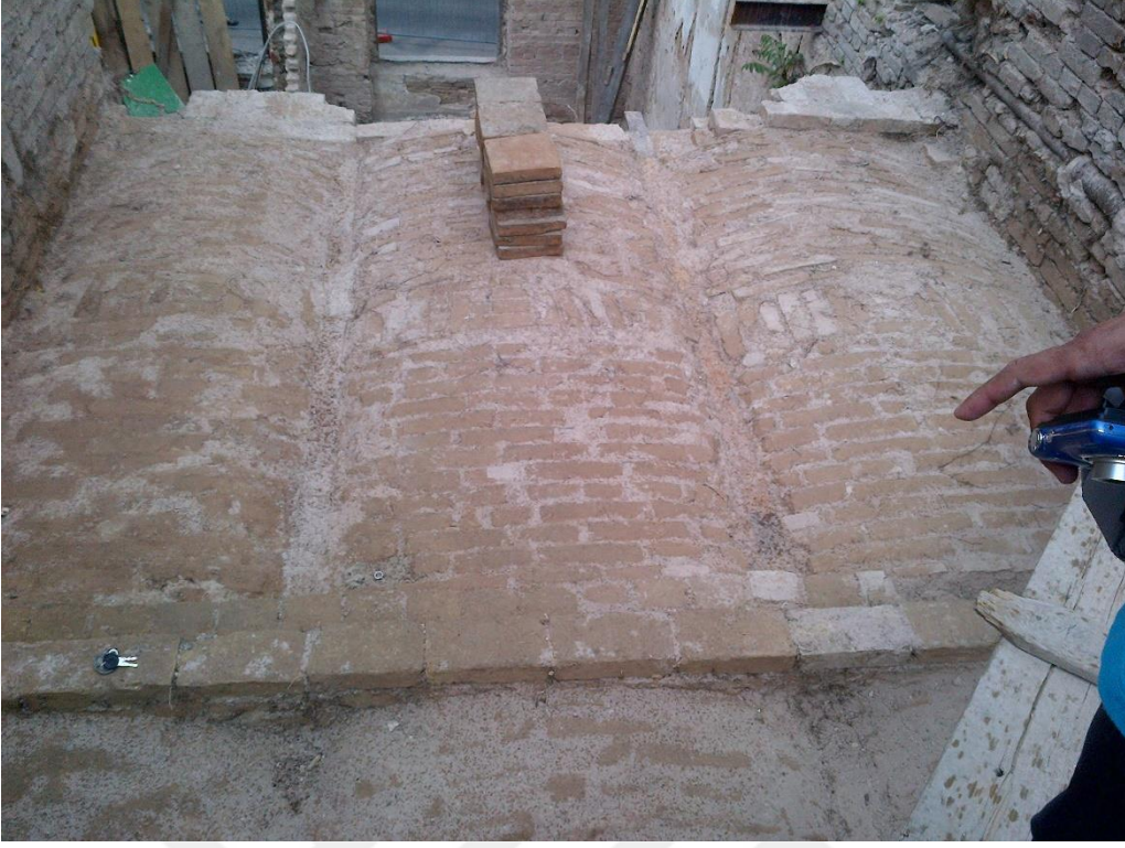
Fotoğraf: 89 İsa Bey Hamamı soyunmalık bölümü volta döşemesi.
