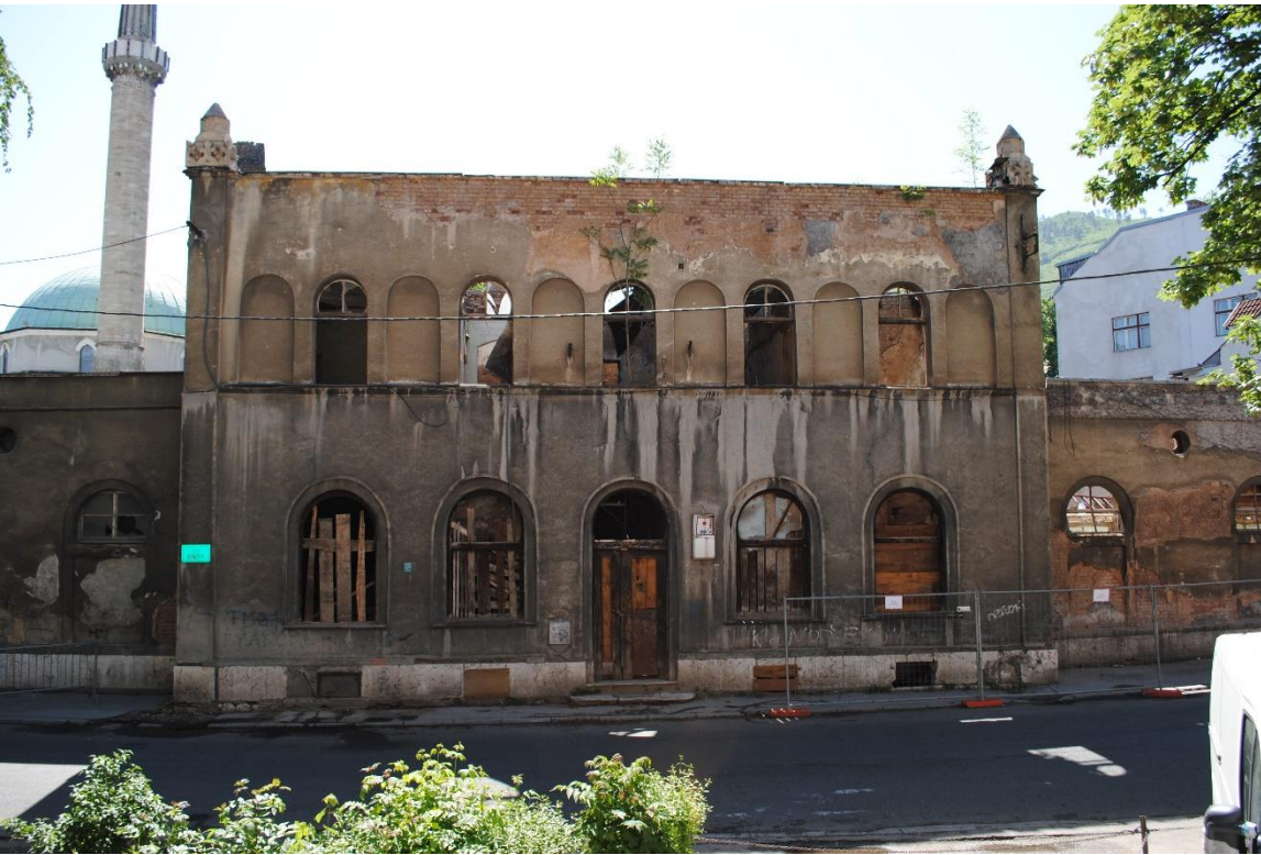
Fotoğraf: 59 İsa Bey Hamamı yenileme Öncesi Ana cephe. 2013
