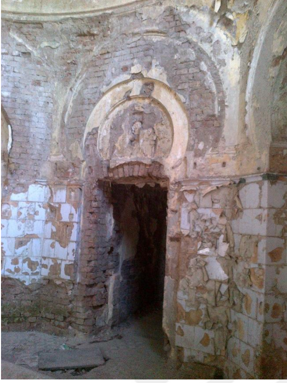
Fotoğraf: 64-65 İsa Bey Hamamı yenileme esnasında, söküm işleri. Sıcaklık bölümü ve uçluk bölümü. 2013
