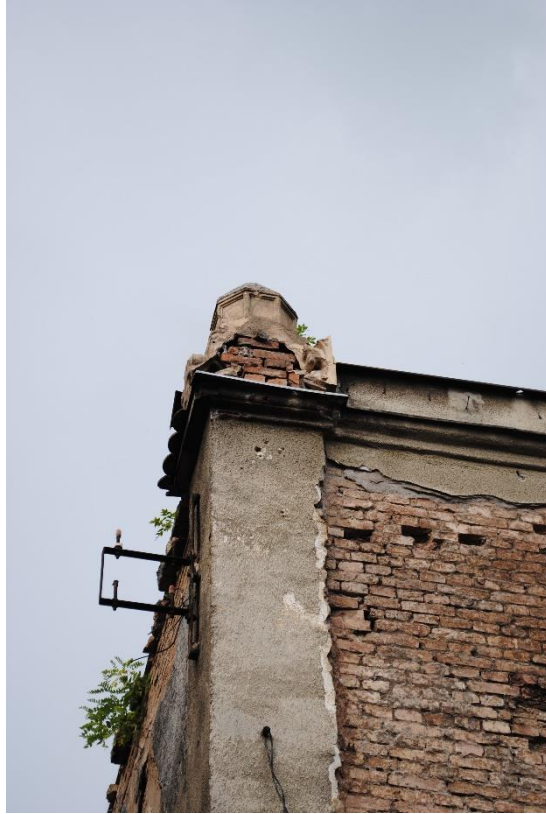
Fotoğraf: 61 İsa Bey Hamamı yenileme esnasında, derz temizleme işleri. 2013
