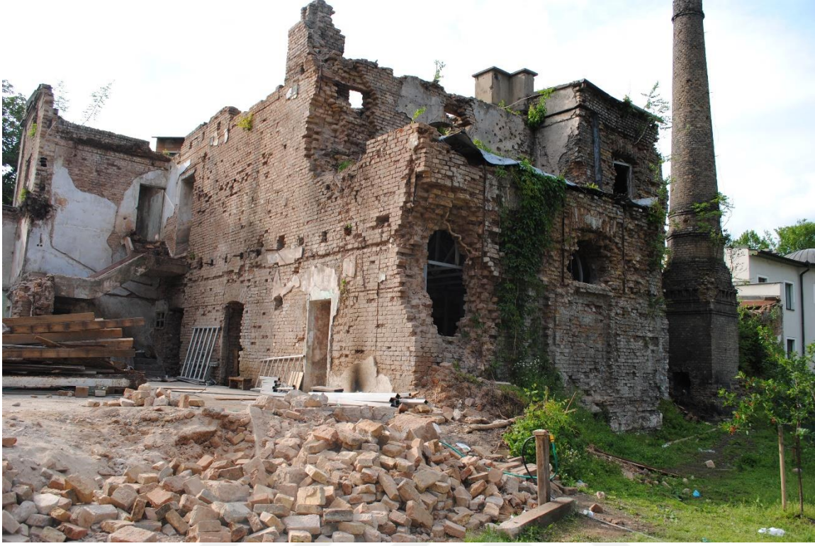
Fotoğraf: 60 İsa Bey Hamamı yenileme esnasında, söküm işleri. 2013
