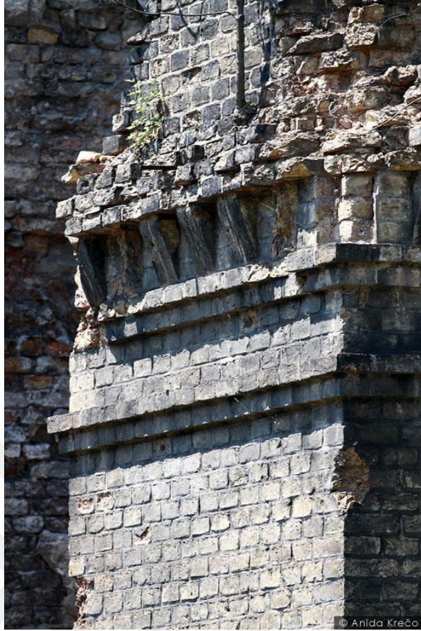
Fotoğraf: 83 İsa Bey Hamamı restorasyon esnasında, sökülme işleri ve derz çalışması. 2013
