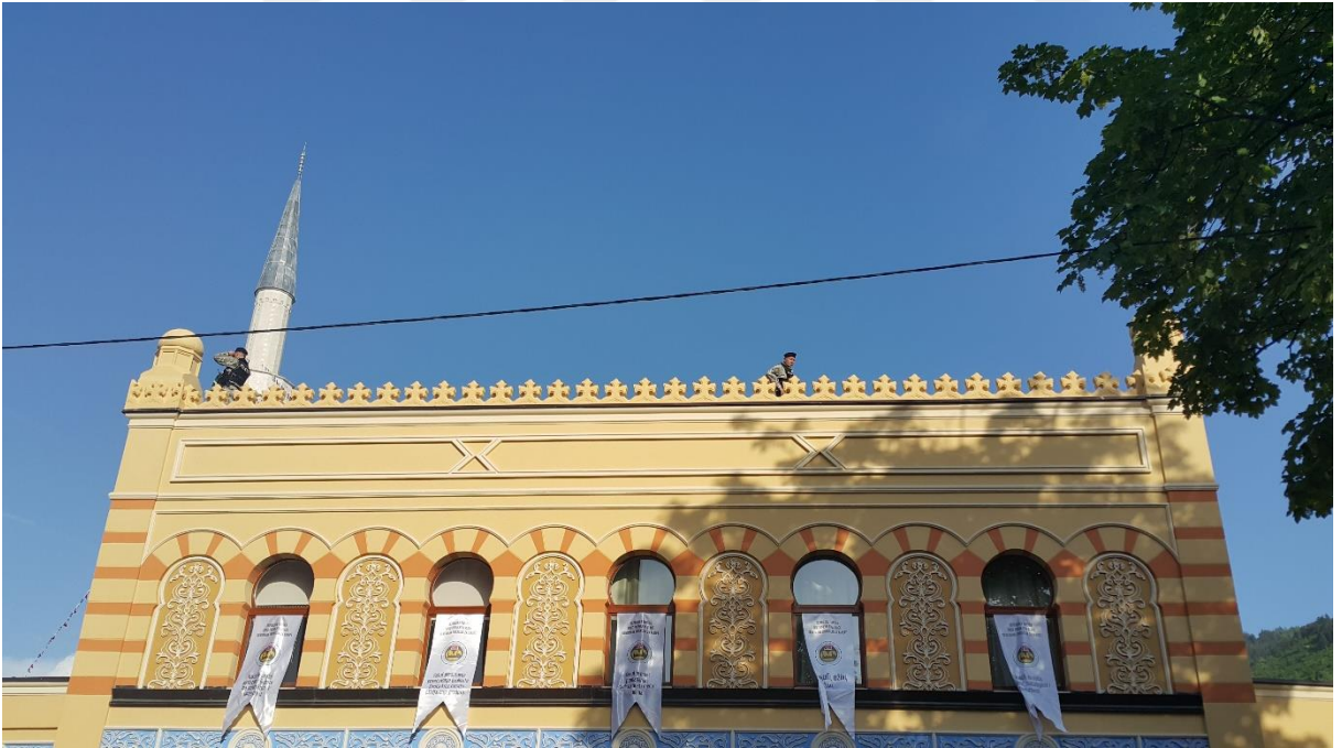
Fotoğraf: 92 İsa Bey Hamamı batı ana cephe.
