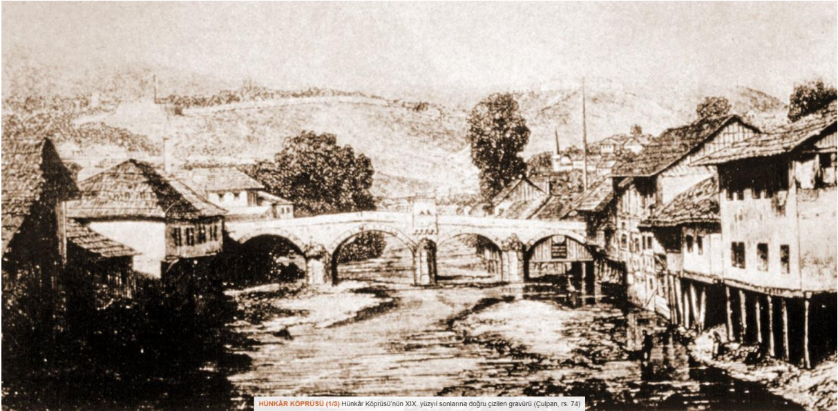
Fotoğraf: 25 Hünkâr köprüsü. (M.Müezzinoğlu)
