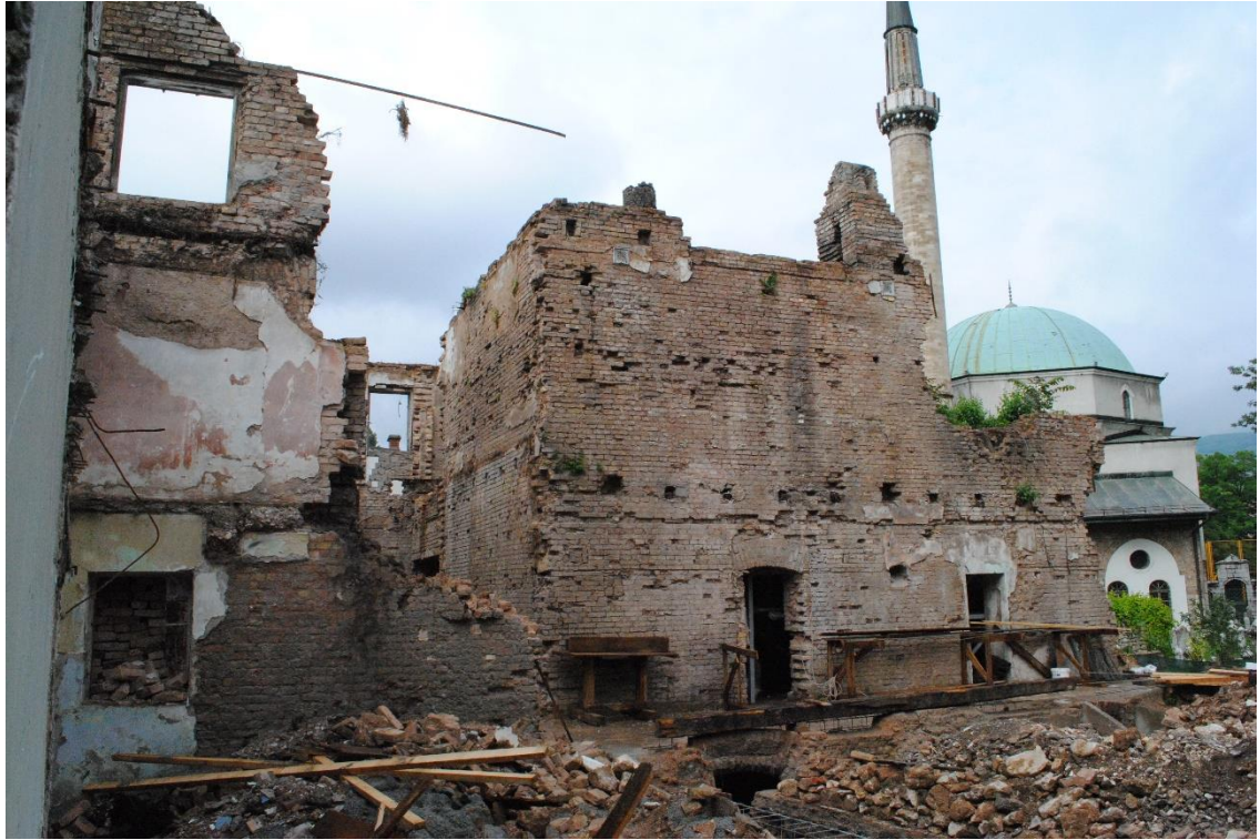
Fotoğraf: 66 İsa Bey Hamamı yenileme esnasında, derz açma çalışmaları. 2013
