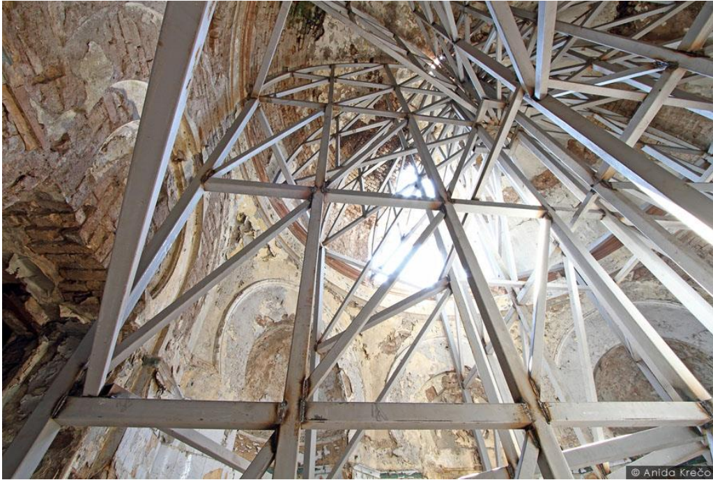
Fotoğraf: 80 İsa Bey Hamamı yenileme esnasında, sıcaklık bölümünün kubbe altı iskele çalışması. 2013
