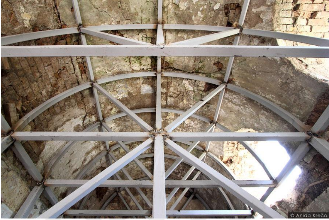
Fotoğraf: 79 İsa Bey Hamamı yenileme esnasında, tonozlu bölüm iskele çalışması. 2013
