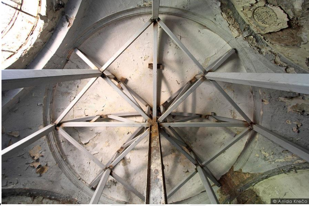
Fotoğraf: 81 İsa Bey Hamamı yenileme esnasında, kubbeli bölüm iskele çalışması. 2013
