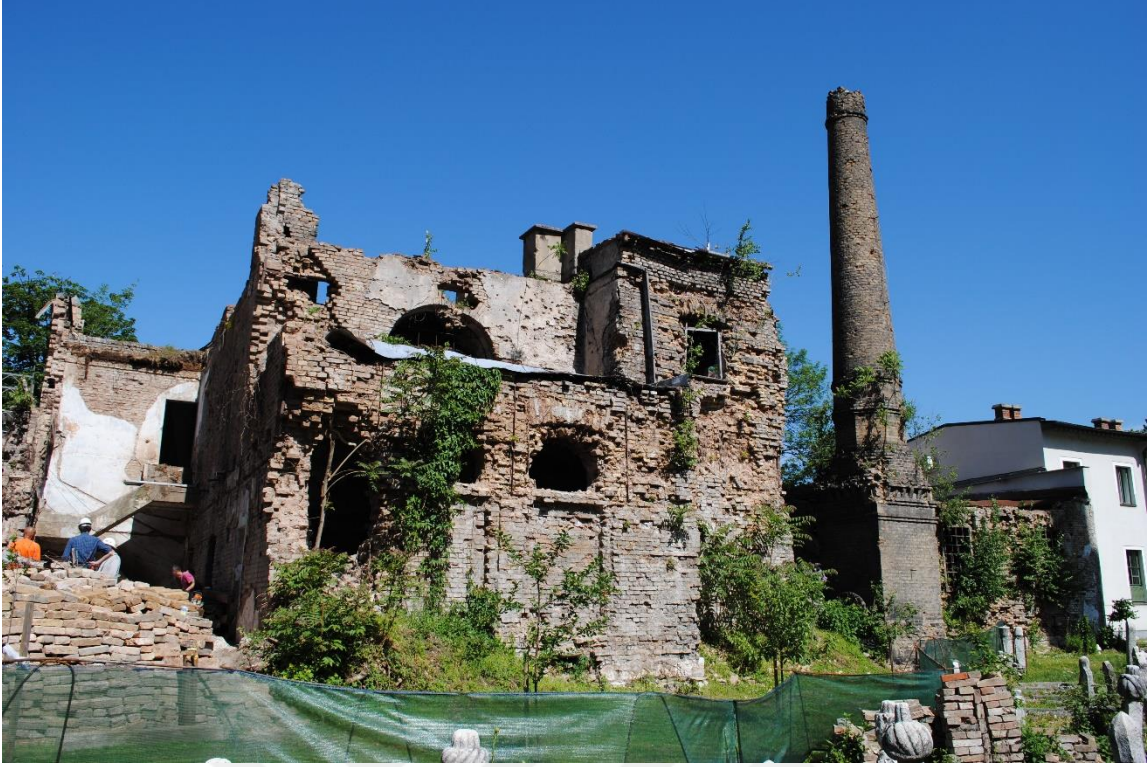
Fotoğraf: 58 İsa Bey Hamamı yenileme esnasında. 2013
