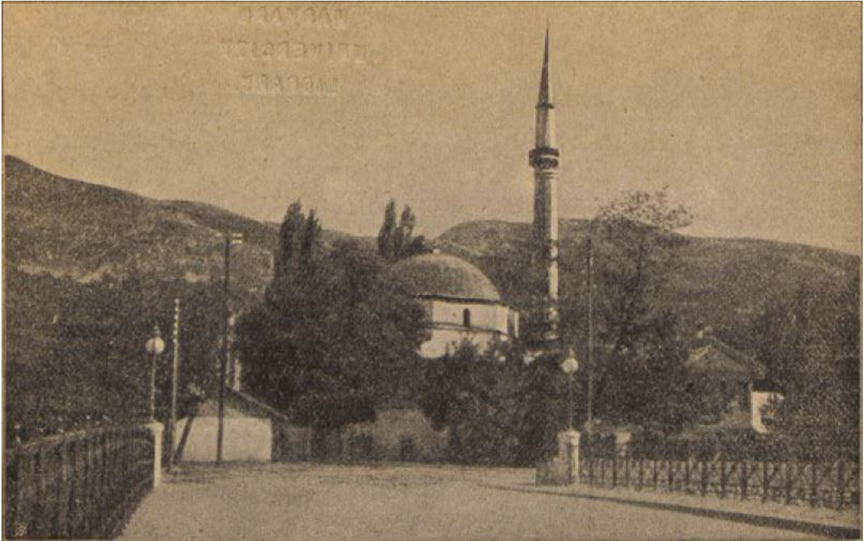
Fotoğraf: 27 İsa Bey Camii (Hünkâr Camii) cephesi ilavelerden önce. (K.S.Fehmi)
