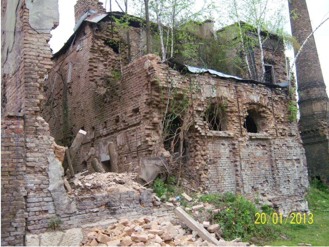
Fotoğraf: 67 İsa Bey Hamamı dođu cephesi, çürütme işlemleri. 2013
