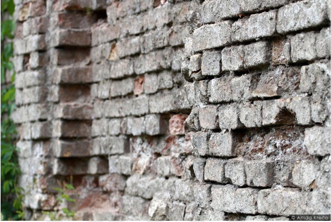
Fotoğraf: 71 İsa Bey Hamamı çürütme işlemleri ver derz işleri. 2013
