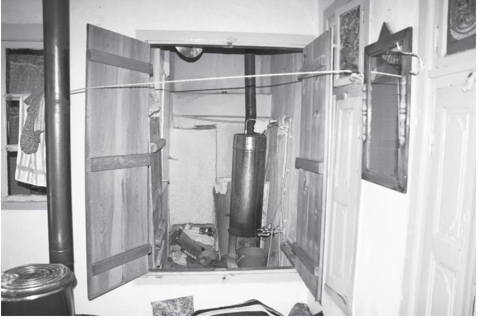
Resim 18. Başodanın yüklük donatısı ve gusülhanenin banyoya dönüşmüş hâli
