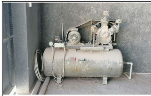
Şekil 4.26. Basınçlı Hava Motoru ve Tankı
