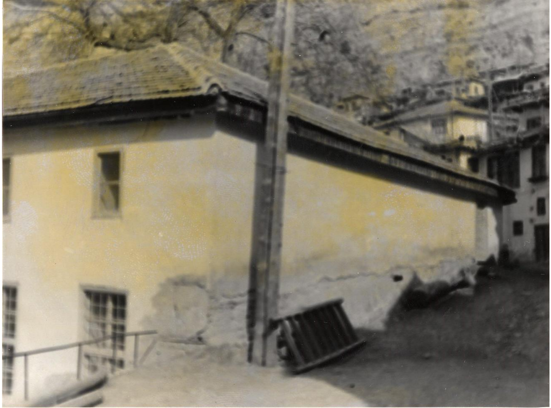
Resim 23: Sipas Cami Güney ve Doğu Cephe eski foto
