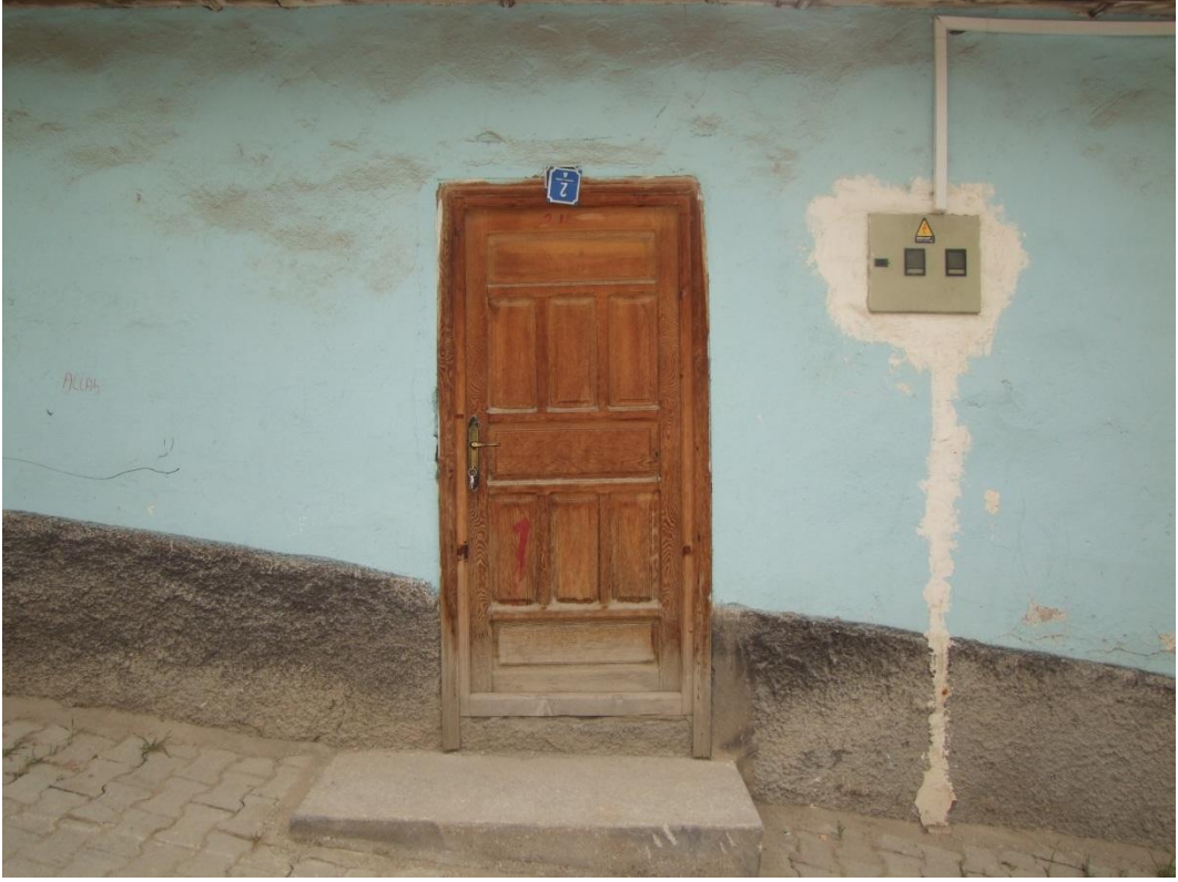
Resim 81: Susaklı Cami Kuzey Cephesindeki Mahfil Kapısı
