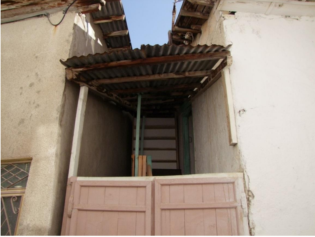
Resim 107: Arapşah Cami Doğu Cepheden Görünüş
