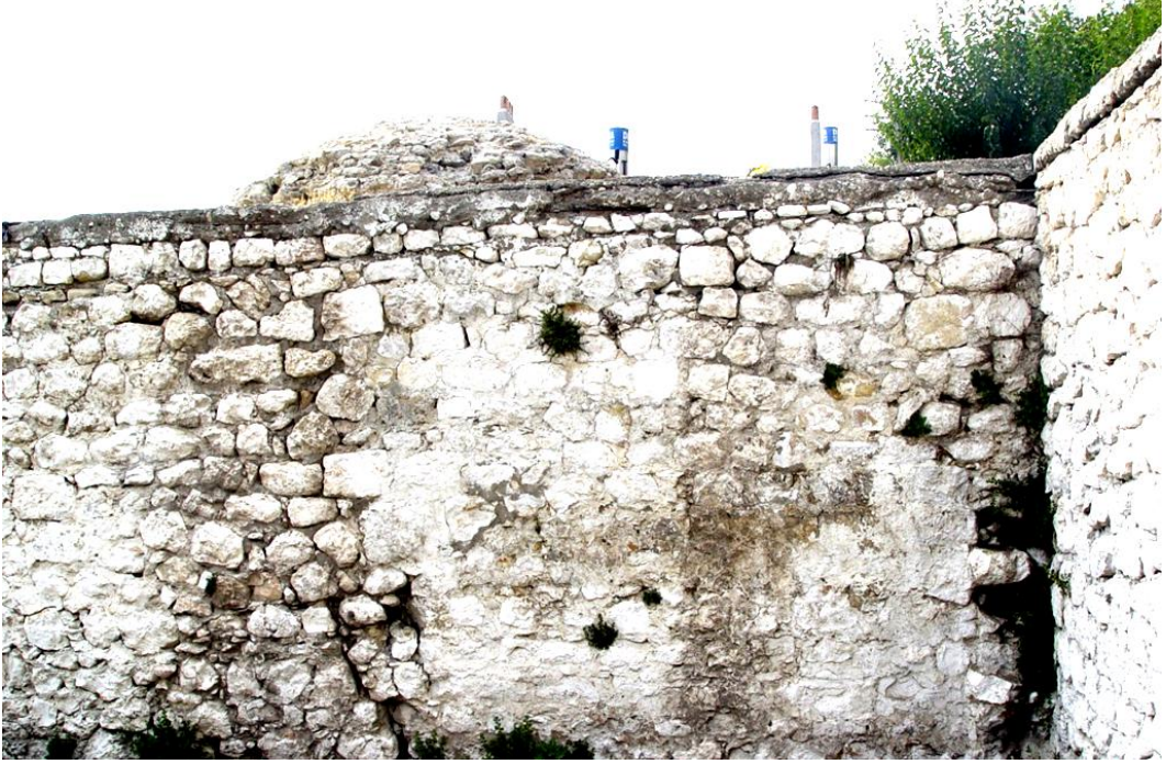
Resim 159: Hamamın dođu cephe duvarı
