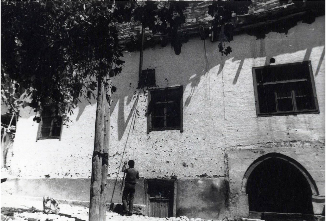
Resim 94: Akça Mescit güney cephe eski foto
