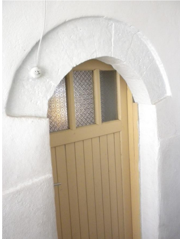
Resim 120: Batı Celaliye Giriş kapısı
