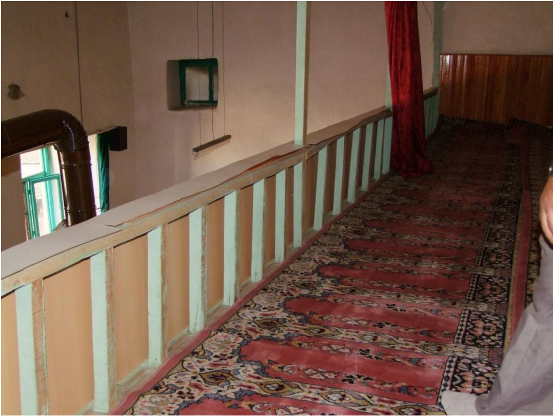
Resim 114: Arapşah Cami Mahfil Bölümü
