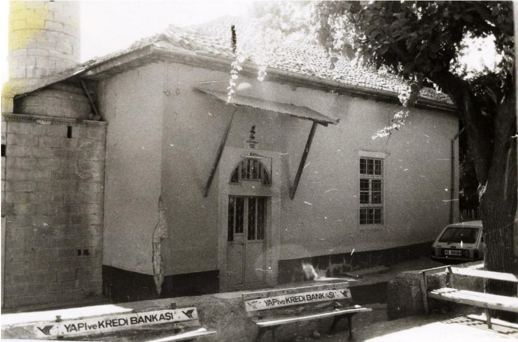
Resim 58: Değirmenlik Camii Giriş bölümü eski foto
