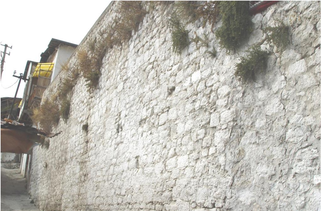
Resim 160: Hamamın gÜney cephe duvarı
