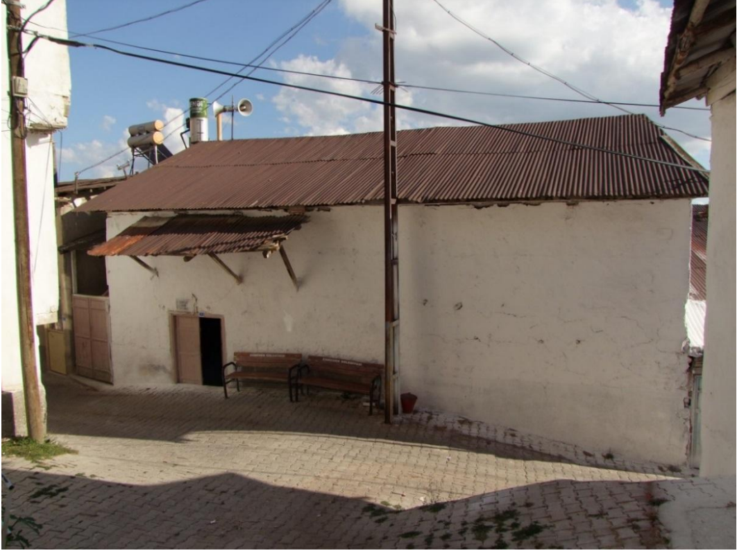
Resim 105: Arapşah Cami Kuzey Cepheden Görünüş
