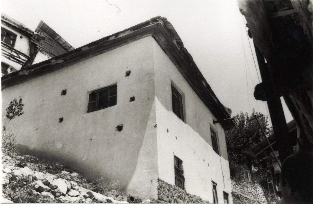
Resim 96: Akça Mescit doğu cephe eski foto
