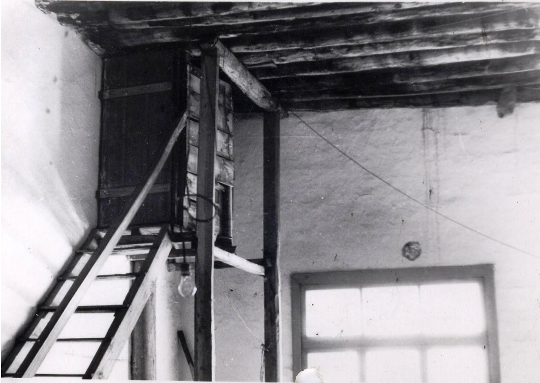
Resim 103: Akça Mescit minare çıkış merdivenleri eski fotoğraf
