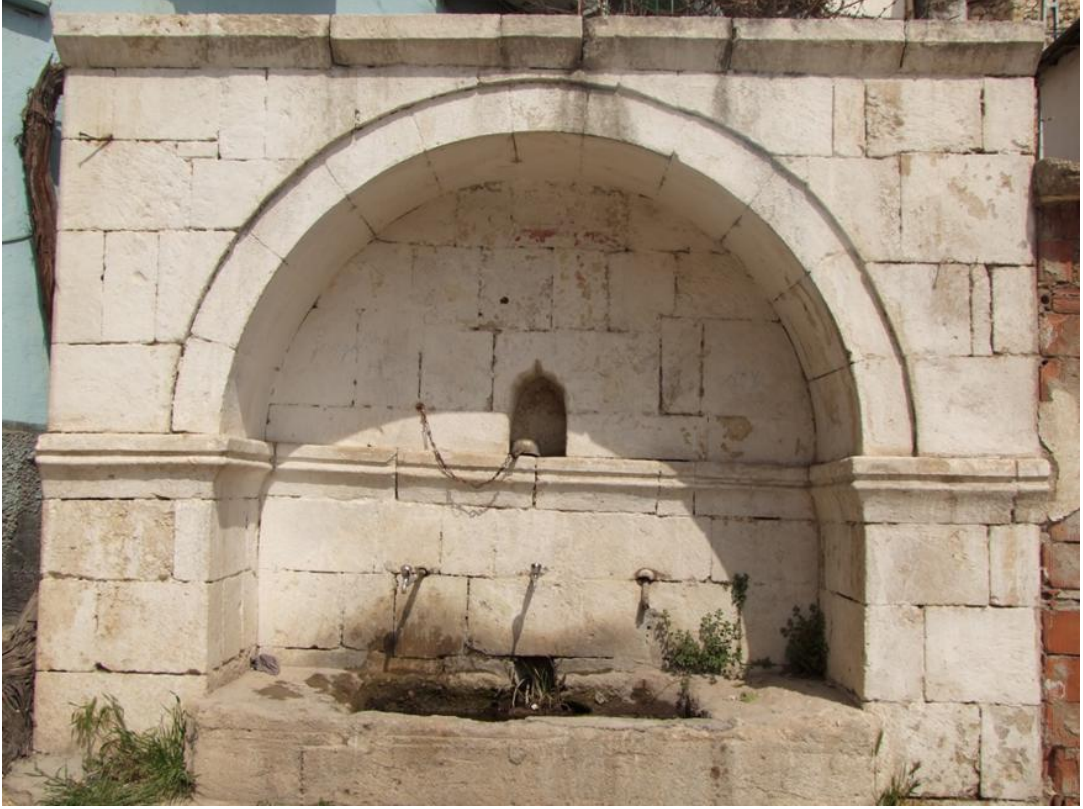
Resim 169: Susaklı Camii eşmesi genel
