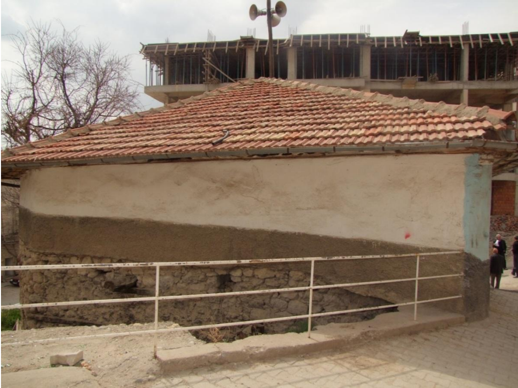
Resim 82: Susaklı Cami Doğu Cephesinden Genel Görünüş
