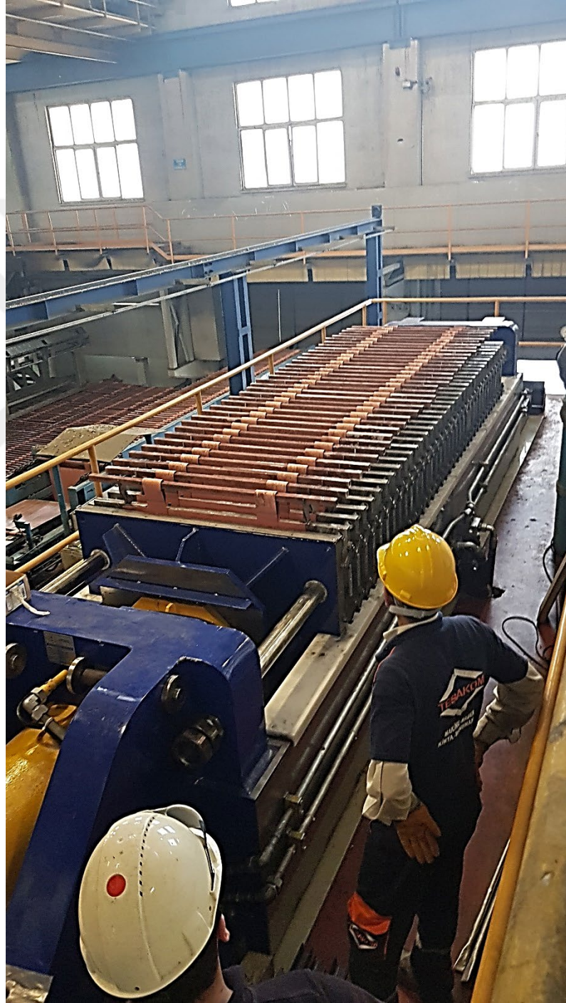
Şekil 5.3 Tesis kurulumu tamamlanmış makine görseli
