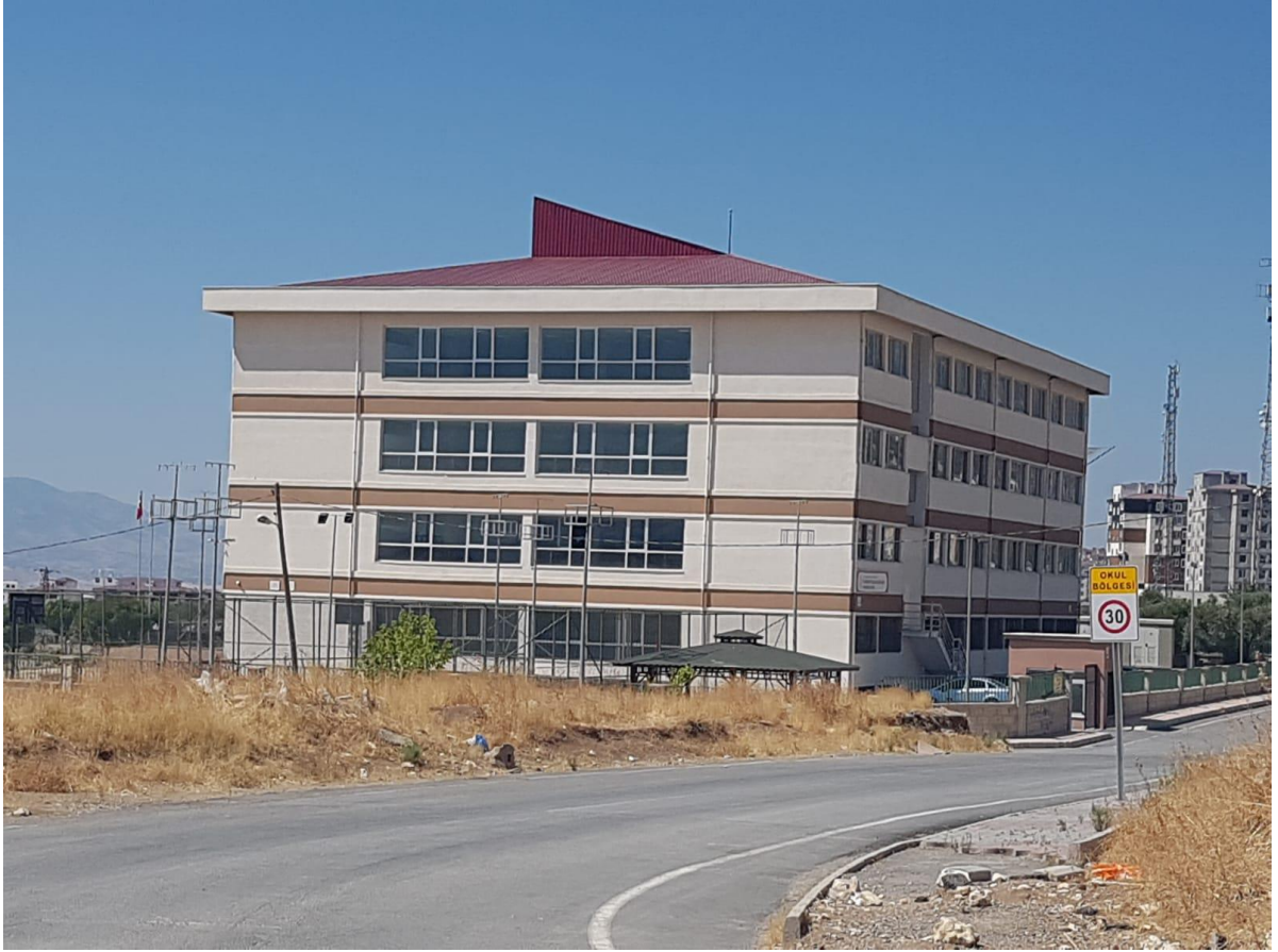
Resim 3.5. Kahramanmaraş Doğukent Sultan Alpaslan Anadolu Lisesi doğu cephesi (Koç, 2021 kişisel arşiv)
