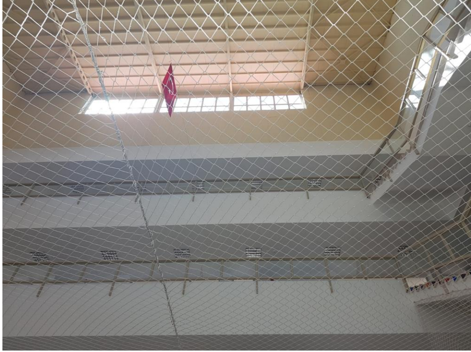
Resim 3.3. Kahramanmaraş Doğukent Sultan Alpaslan Anadolu Lisesi çatı penceresi (Koç, 2021 kişisel arşiv)
