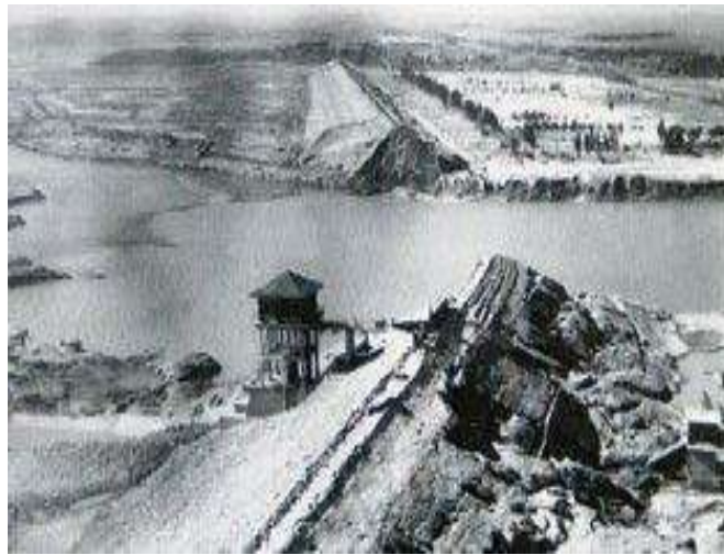
Şekil 1.1. Yıkımdan sonra Banqiao Barajı (Zhang vd., 2009)
