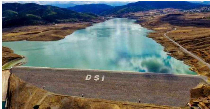
Şekil 2.6. Sadak Barajı (Kil çekirdekli kum çakıl dolgu baraj) (DSİ, 2025)
