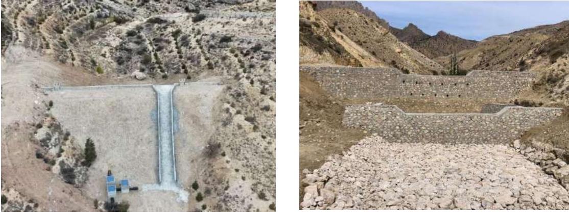
Şekil 2.4. Beton ve kagir tersip bendi
