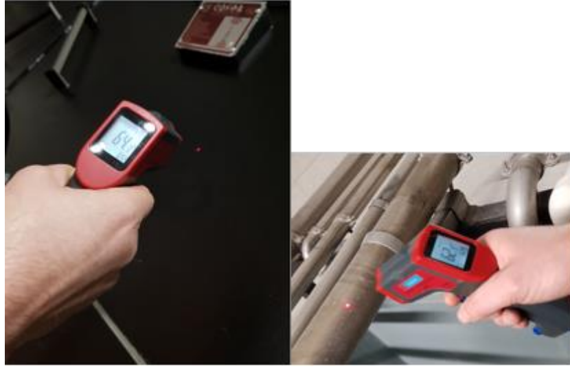
Şekil 1.3. Buhar dağıtım hatlarının sıcaklık ölçümü
