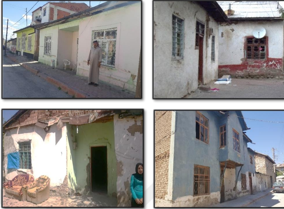
Şekil 4.5. Aksaray ve Hicret Mahallelerinde Yaşayan Mültecilerin Barınma Alanlarından Görünümler
