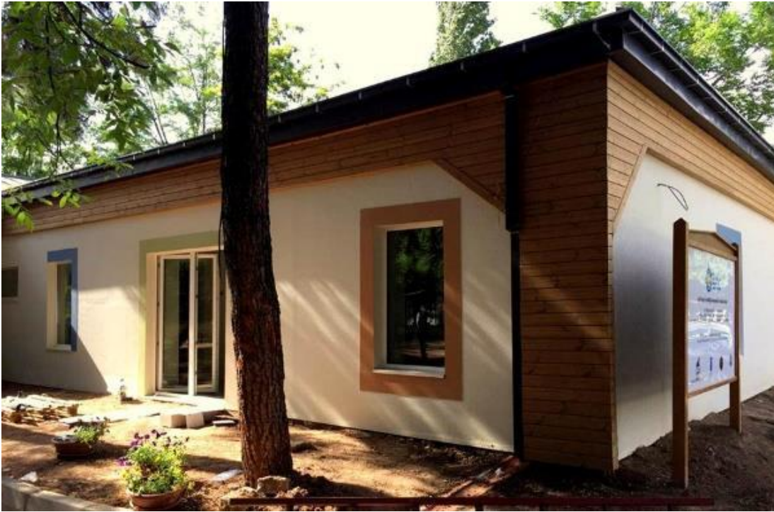
Őekil 3.14. Gaziantep Kuluka Merkezi (Ural Yertutan, 2018).
