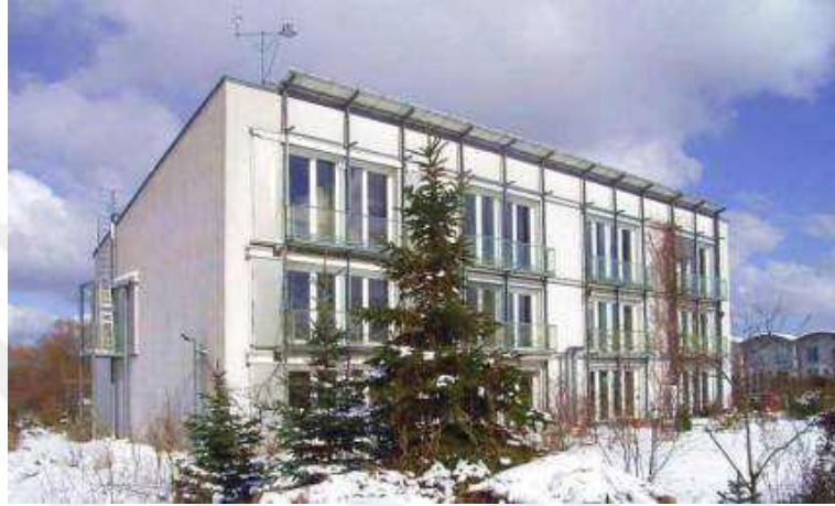
Şekil 3.2. 1991 yılında yapılan pasif ev
