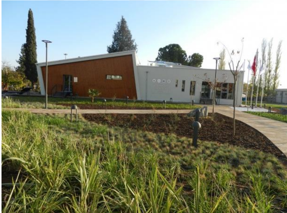
Şekil 3.13. Gaziantep İnsan Kaynakları Merkezi (Web-6)
