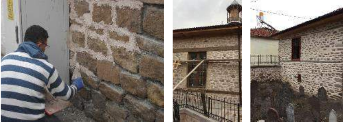
Şekil 2.7. Sille Subaşı Camii'nde Horasan harcı derz örnekleri.
