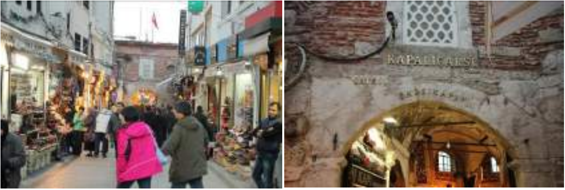
Şekil 2.21. Osmanlı dönemi Horasan harcı kullanılan taş-tuğla karışık kagir duvarlı Kapalı Çarşı.
