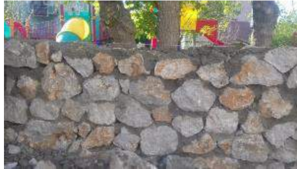
b. Çimento-Kireç karışımı örgü harcı örneği.
