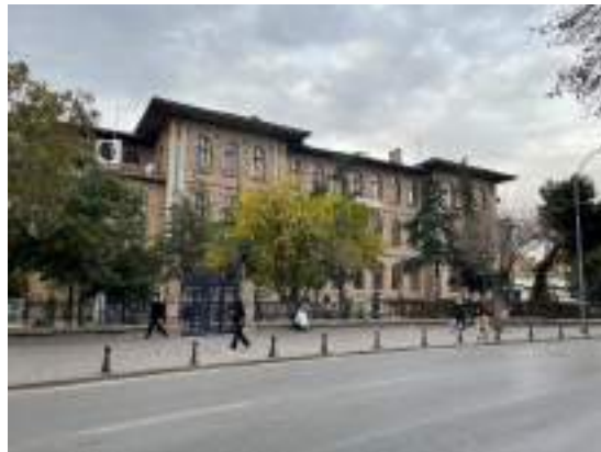
Şekil 3.53. Gazi Lisesi doğu cephesi.
