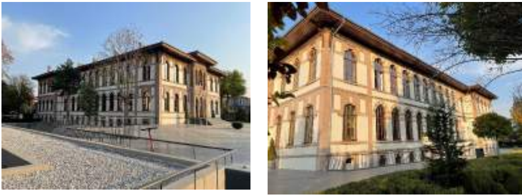
Şekil 3.28. Restorasyon sonrası Kız Öğretmen Okulu cepheleri.
