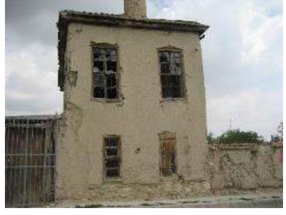
b. Meram'da bulunan kerpiç sıva ve duvarlı geleneksel konut yapısı.
