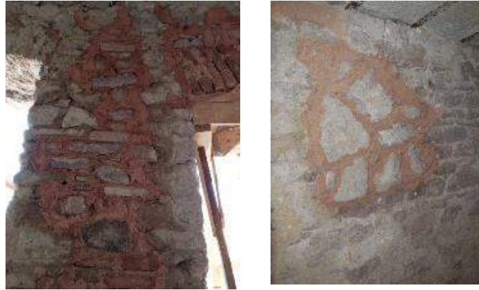
Şekil 2.8. Hemşire Lojmanı restorasyonunda Horasan harcı ile dikiş yaparak duvar onarımı örnekleri.
