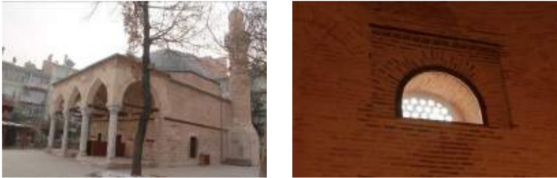
Şekil 2.19. Tuğla-taş karışık kagir duvarlı Beylikler dönemi yapısı Konya Tahir Paşa (Dursun Fakih) Camii.
