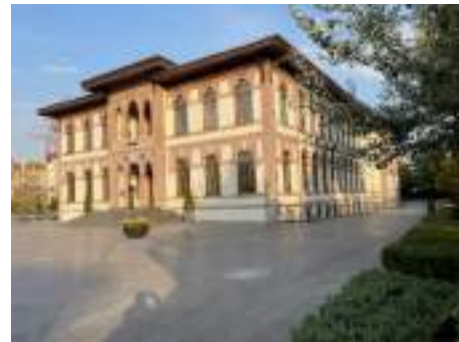
b. Restorasyon sonrasında batı cephe.
