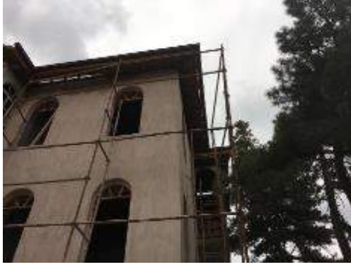
a. Kalfaoğlu Konağı restorasyonu
