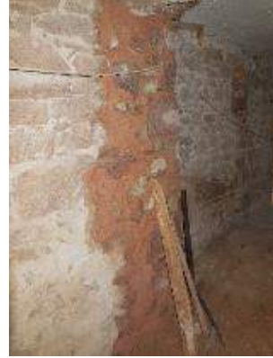
b. Hemşire Lojmanı restorasyonunda derz uygulaması.
