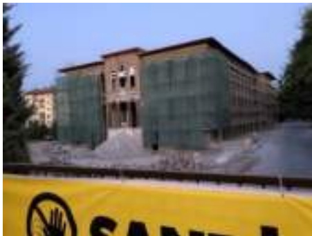
a. Restorasyon uygulaması sırasında ek bölüm kaldırıldıktan sonra özgün batı cephesi. (2022)
