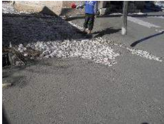
Şekil 2.4. Çimento-kireç karışımı tesfiye harcı örneği.
