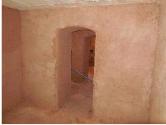
a. Hemşire Lojmanı restorasyonunda sıva uygulaması.
