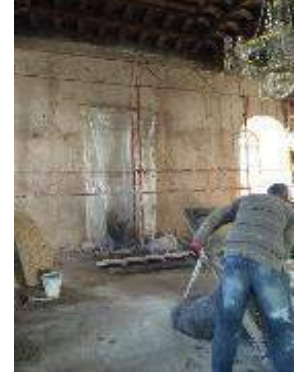
c. Yukarıçiğil Merkez Camii restorasyonu
