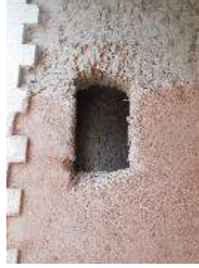
b. Hemşire Lojmanı restorasyonu
