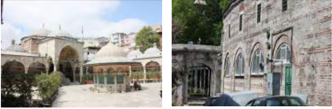
Şekil 2.20. Osmanlı dönemi Sokullu Mehmet Paşa Külliyesi ve Osmanlı dönemi almaşık örgülü dış duvarları.
