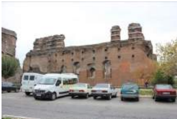
Şekil 2.15. Kireç harç bağlayıcılı, tuğla duvarlı Bergama Kızılavlu, Roma dönemi.
