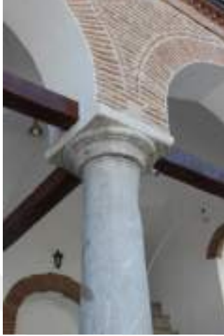
Şekil 357 Karacabey Camii dış duvarları ve mermer sütunlar (Sarı, 2021)
