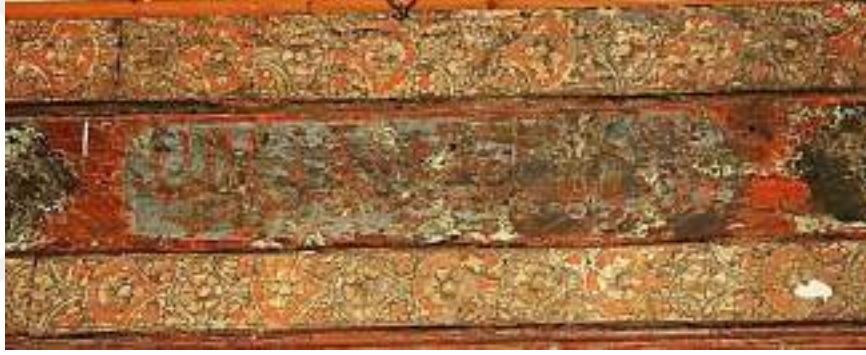
Şekil 623 Yeşil Ahi Camii iç giriş kapısı alınlık panosu (Sarı, 2023)
