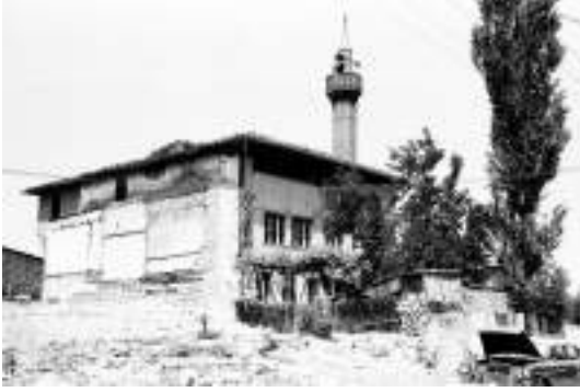
Şekil 177 Hacettepe Camii eski fotoğrafı (VGM Arşivi)
