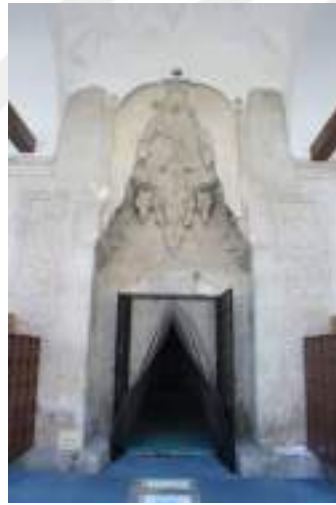
Şekil 359 Karacabey Camii giriş kapısı (Sarı, 2021)
