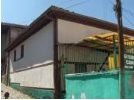
Şekil 126 Devduran Mescidi onarım öncesi fotoğrafı (VGM Arşivi)
