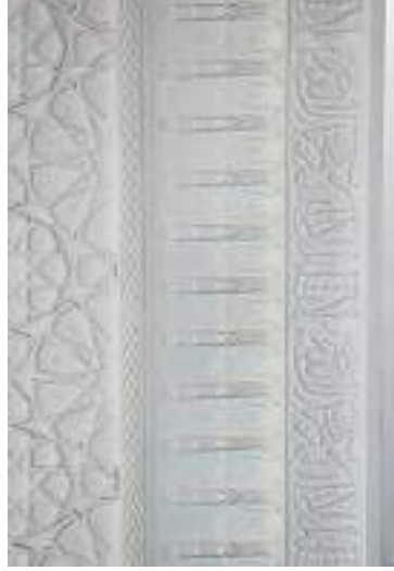
Şekil 514 Sultan Alaaddin Camii mihrap bordür detayı (Sarı, 2021)
