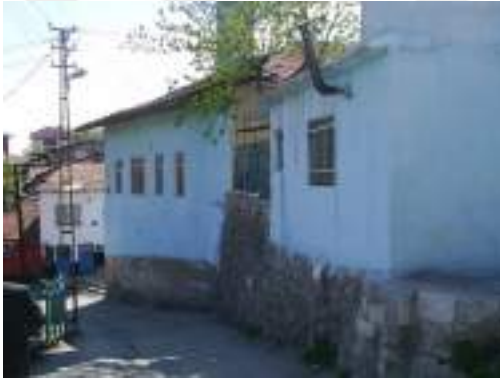
Şekil 132 Direkli Camii onarım öncesi fotoğrafı (VGM Arşiv)
