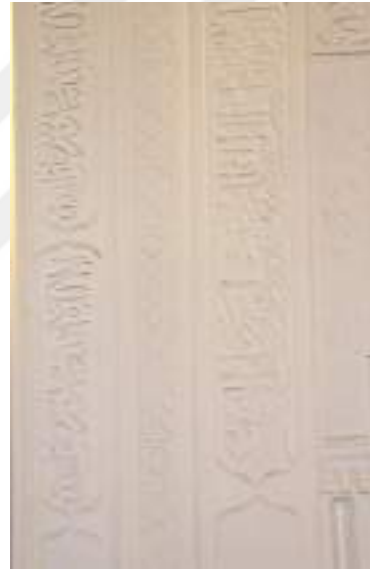
Şekil 327 İbadullah Camii mihrap 1-1-2-3.bordür detayı (Sarı, 2021)
