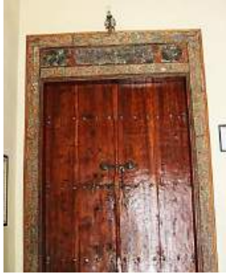
Şekil 621 Yeşil Ahi Camii iç giriş kapısı (Sarı, 2023)
