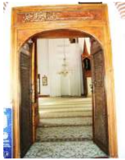
Şekil 270 Hacı Musa Camii giriş kapısı (Sarı,2023)
