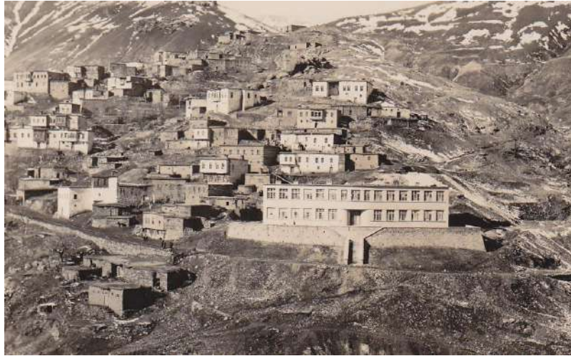
Resim 4. 16. İşletme Tarafından İnşa Edilen Atatürk İlkokulun Yer Aldığı Kent Dokusu 1933-34 Yıllarına Ait Fotoğraf (web 13)
