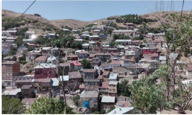
Resim 4. 3. Cami Kebir Mahallesi Konut Dokusu (web 7)
