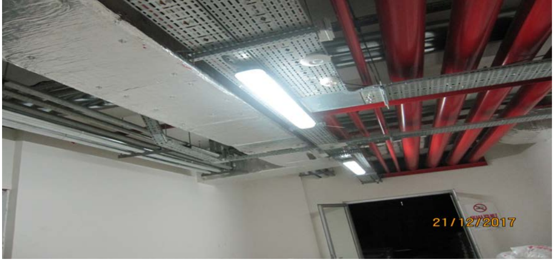
Şekil 5.10. Bodrum kattaki sensörsüz armatürlerin resmi
