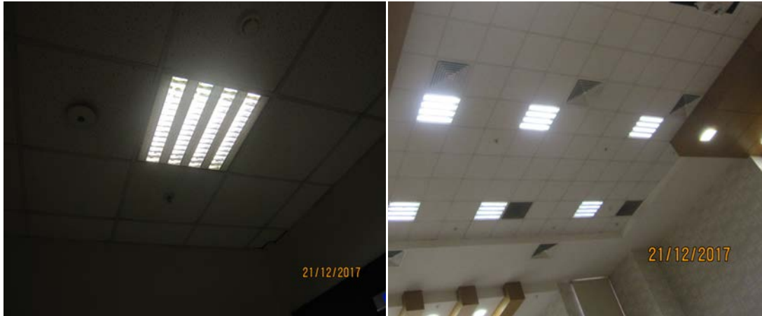
Şekil 5.9. Binanın oda içlerinde bulunan 4 gözlü 56 watt olan lambaların resmi
