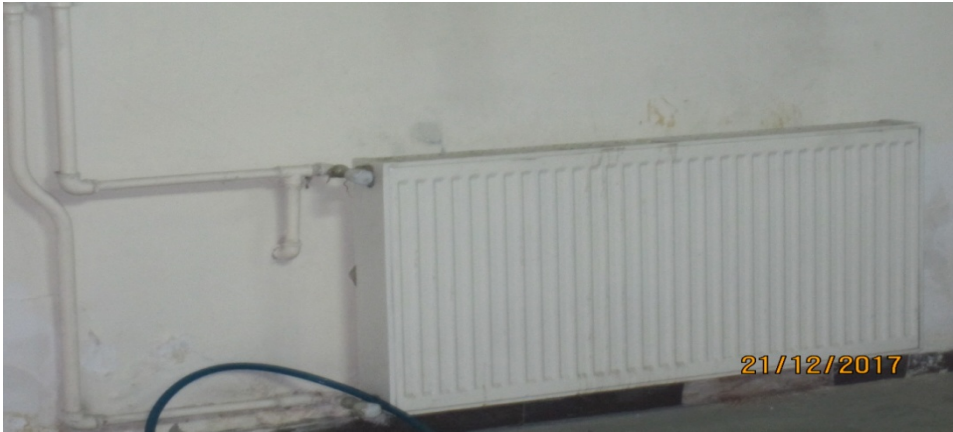
Şekil 5.7. Bodrum katta termostatik vanası olmayan Radyatör resmi
