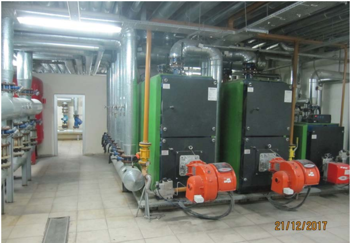
Şekil 5.8. Binanın Kalorifer Dairesinde Kazanlara Ekonomizerin Takılı Olmadığını Gösteren Resim
