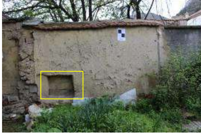
Fotoğraf 4.10. 137 ada, 32 parsel tescilli evin bahçesinin güney yönündeki kerpiç duvarında bulunan ocak (Yazarın arşivinden, 2018)
