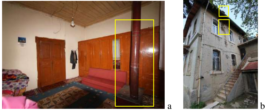
Fotoğraf 4.8. 137 ada, 32 parsel tescilli evin ZK-02(a) içerden dökme soba –Güney (sağ yan) (b) cepheden soba deliği ve dış cepheden bacanın görünüşü (Yazarın arşivinden, 2018)
