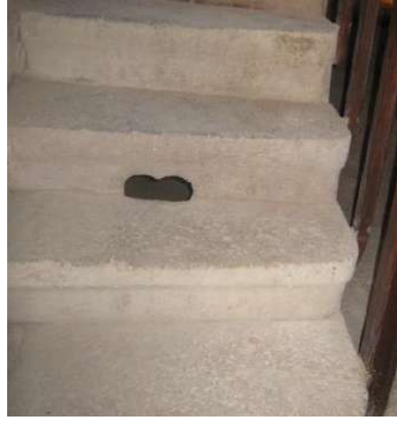
Fotoğraf 3.28. Kayseri-Ağırnas Mimar Sinan evinde merdivende hava ve aydınlatma deliği (Dişli, 2015)
