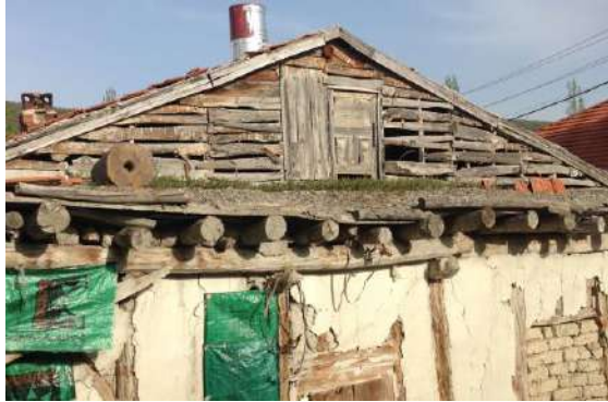
Fotoğraf 3.42. Ahşap kırma çatılı tarihi ev (Ankara, Çubuk, Hacılar Köyü) (Dişli, 2009)
