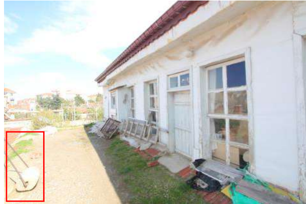
Fotoğraf 4.37. 137 ada, 34 parsel tescilli evin çatısında bulunan loğ taşı (Yazarın arşivinden, 2018)
