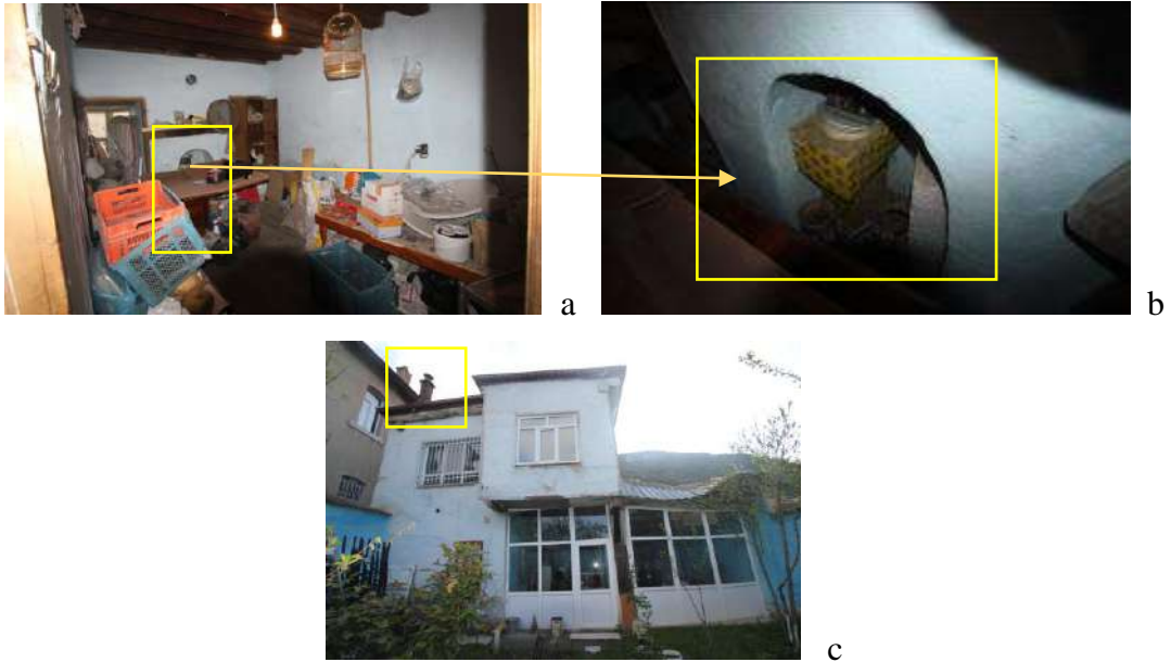
Fotoğraf 4.27. 137 ada, 34 parsel tescilli evin ZK-03(a) içerden mutfak–Batı (arka)(b) cephede bulunan ocak görünüşü–çatıdan(c) mutfak bacasının görünüşü (Yazarın arşivinden, 2018)
