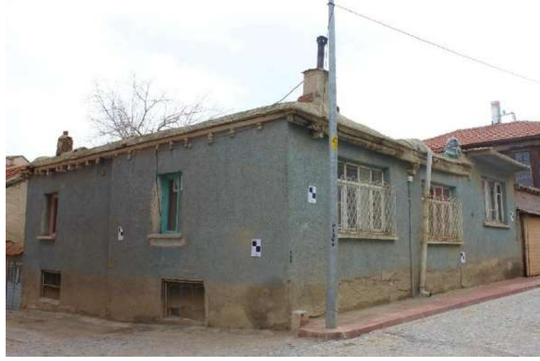
Fotoğraf 3.5. Geleneksel Akşehir evinde dam (Yazarın arşivinden, 2020)
