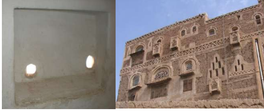
Fotoğraf 3.19. Yemen- İmam Yahya evinde soğutma pencereleri (Dişli, 2011)
