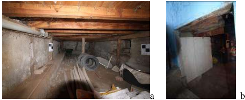
Fotoğraf 4.30. 137 ada, 34 parsel tescilli evin bodrum kat ambar olarak kullanıldığı düşünülen Oda-B-01 genel görünüşü (a), toprak zemin, ahşap hatıl- hasır tavan ve ahşap çakma kapı uygulaması (a-b) (Yazarın arşivinden, 2018)
