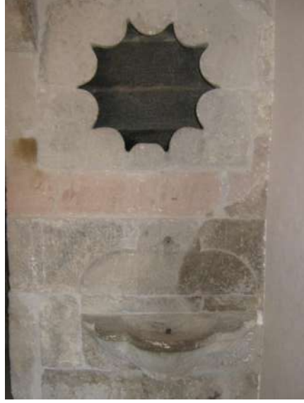
Fotoğraf 3.26. Kayseri-Ağırnas Mimar Sinan evinde havalandırma ve aydınlatma nişi (Dişli, 2015)
