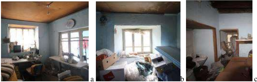
Fotoğraf 4.22. 137 ada, 34 parsel tescilli evin ZK-02(a)-ZK-03(b)-ZK-04(c) nolu odadan genel görünüşü (Yazarın arşivinden, 2018)
