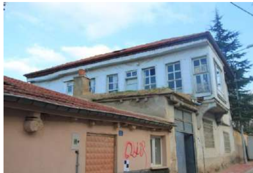
Fotoğraf 4.33. 137 ada, 34 parsel tescilli evin Sofa-1K-01 nolu mekânında bulunan pencerelerin dış görünüşü (Yazarın arşivinden, 2018)
