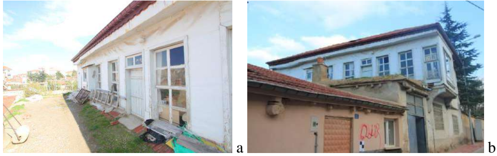
Fotoğraf 4.26. 137 ada, 34 parsel tescilli evin kuzeybatı cephesi (a) ve çıkmasında (b) sac kaplama görünüşü (Yazarın arşivinden, 2018)
