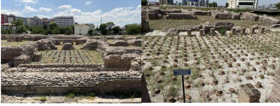
Fotoğraf 3.17. Ankara Roma Hamamı sıcaklık bölümü- hypocaust kanalları ve tuğla ayaklar (Dişli, 2020)
