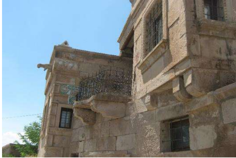
Fotoğraf 3.18. Kayseri-Ağırnas Mimar Sinan evinde balkon (Dişli, 2015.)
