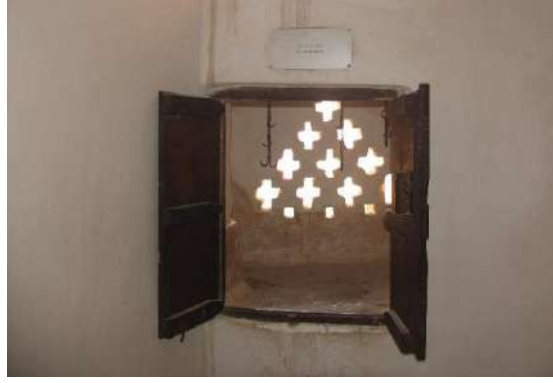
Fotoğraf 3.20. Yemen- İmam Yahya evinde soğutma pencereleri (Dişli, 2011)
