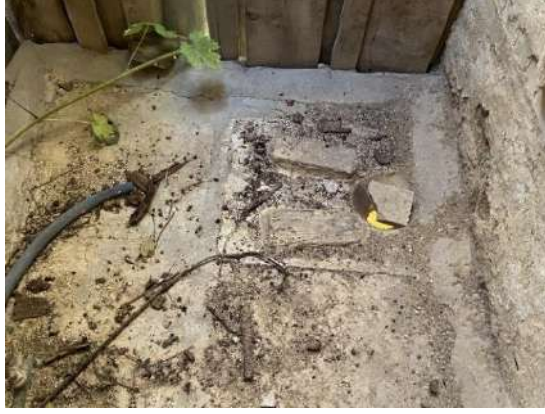
Fotoğraf 3.35. Beyşehir Üstünler kasabasındaki tarihi bir konut yapısında hela taşı (Dişli, 2022)
