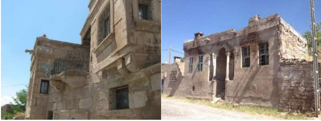
Fotoğraf 3.46. Kayseri Ağırnas kabasında kesme taş parapetli düz dam ev ve taş çörlen (Dişli, 2015.)
