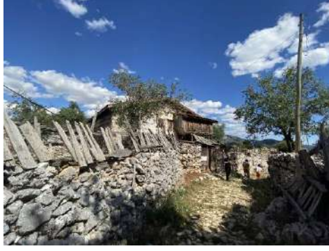
Fotoğraf 3.50. Antalya Sarıhacılar köyü evindeki daraba (Dişli,2021)
