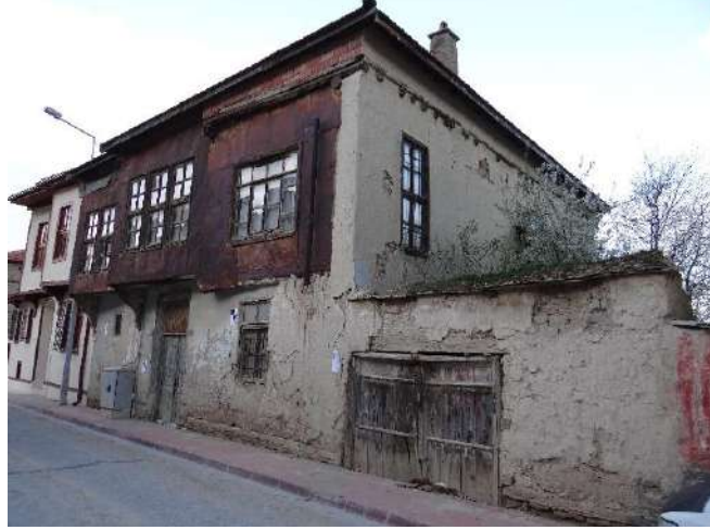
Fotoğraf 3.3. Geleneksel Akşehir evinde cephede sac kaplama (Yazarın arşivinden, 2020)
