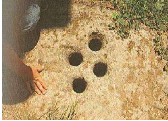
Fotoğraf 3.27. Kayseri, Vekse'de bir yer altı mekânının sokak üzerinde oluşturulan havalandırma delikleri (İmamoğlu, 1992)
