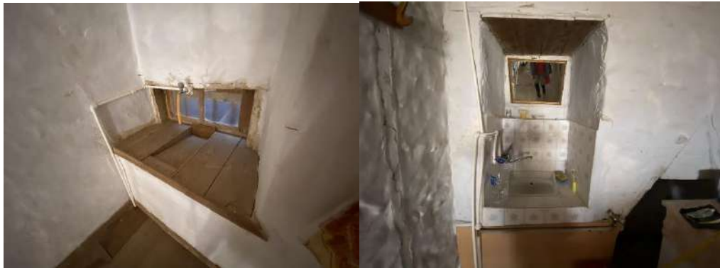
Fotoğraf 3.39. Beyşehir Üstünler kasabesindeki tarihi konut yapısında pencere boşluklarındaki lavabolar (Dişli, 2022)
