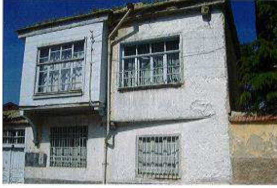
Fotoğraf 4.38. 137 ada, 34 parsel tescilli evin toprak dam olan hali (Akşehir Kültür Envanteri,2012)
