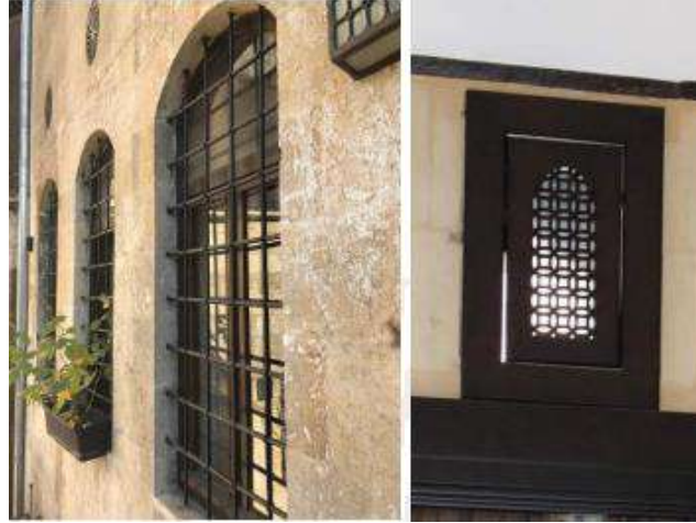
Fotoğraf 3.25. Gaziantep evlerinde taş (sol) ve ahşap (sağ) kafes üst dış pencere (Gezinmez, s:50-51, 2019).
