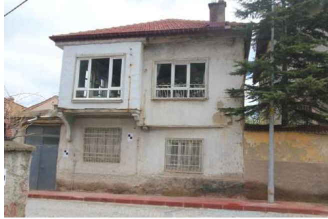
Fotoğraf 4.19. 137 ada, 34 parsel tescilli evin ön (kuzeybatı) cephe görünümü (Yazarın arşivinden, 2018)
