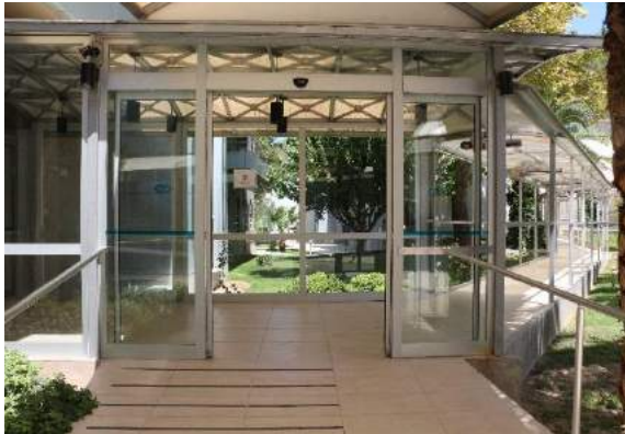
Resim 4.97: Rüzgarlık giriş kapısı
