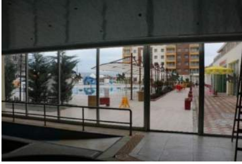
Resim 4.31: Havuzdan açık alanın görünümü
