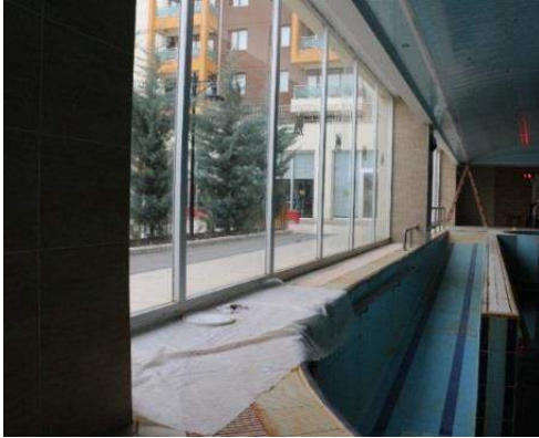
Resim 4.33: Havuz giriş rampası
