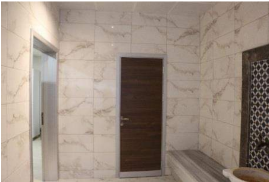
Resim 4.45: Girdap havuzu duvar ve tavan
