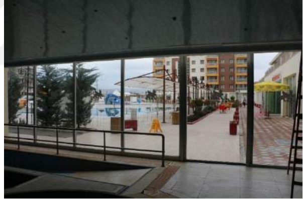
Resim 4.34: Havuza giriş rampa korkuluk
