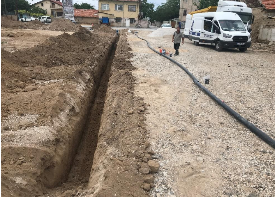
Şekil 7.7. İçme suyu şebeke hattında eski boru hattının iptal edilip PE boru ile deplase işlemi (KOSKİ, 2022)
