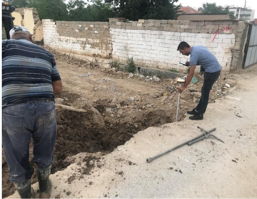
Şekil 7.9. Şebeke hattında eski borunun körlenerek şebeke hattında devreden çıkarılması, körlenen borunun koordinatının CBS sistemine kaydedilmesi ve işaretleme yapılması (KOSKİ, 2022)
