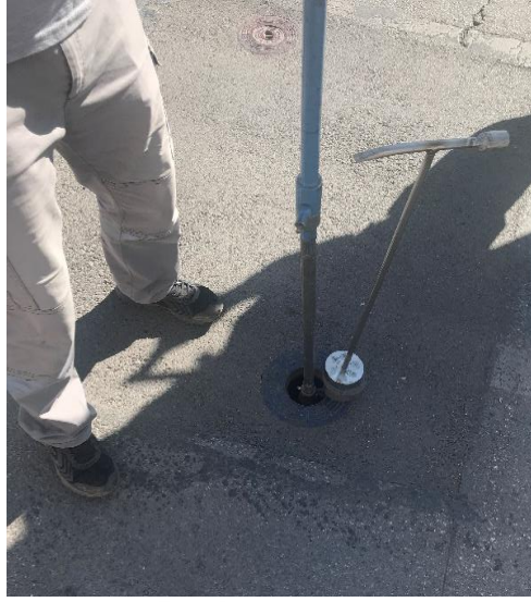
Şekil 4. 16. Karatay DMA giriş vanası kapatma (KOSKİ, 2021)
