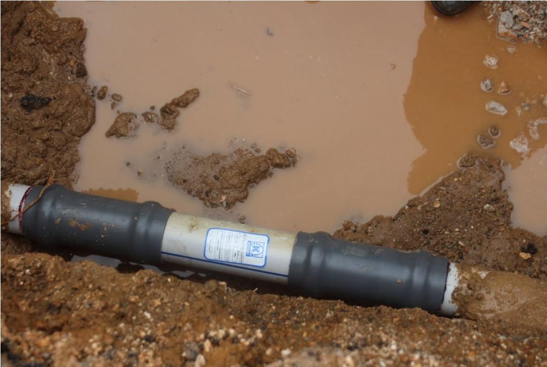
Şekil 7.5. PVC boruda ek parçalar yardımı ile bakım-onarım yapılması (KOSKİ, 2021)
