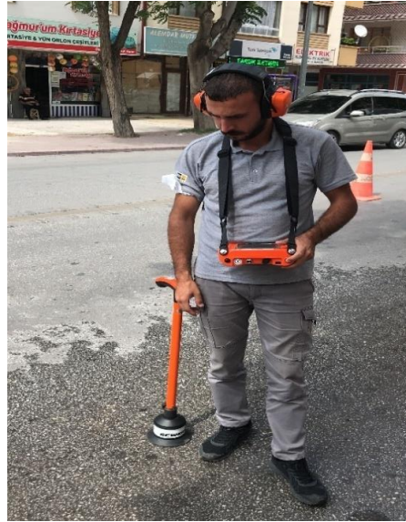
Şekil 4.6. Zemin mikrofonu arazi kaçak uygulaması (KOSKİ, 2021)
