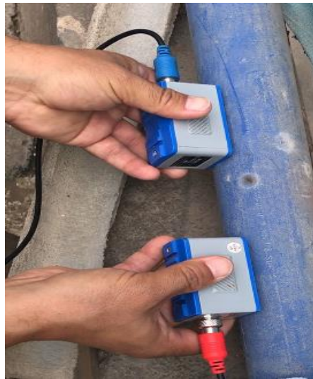
Şekil 4.11. Debimetre sensörlerinin boruya doğru şekilde montajı (KOSKİ, 2021)
