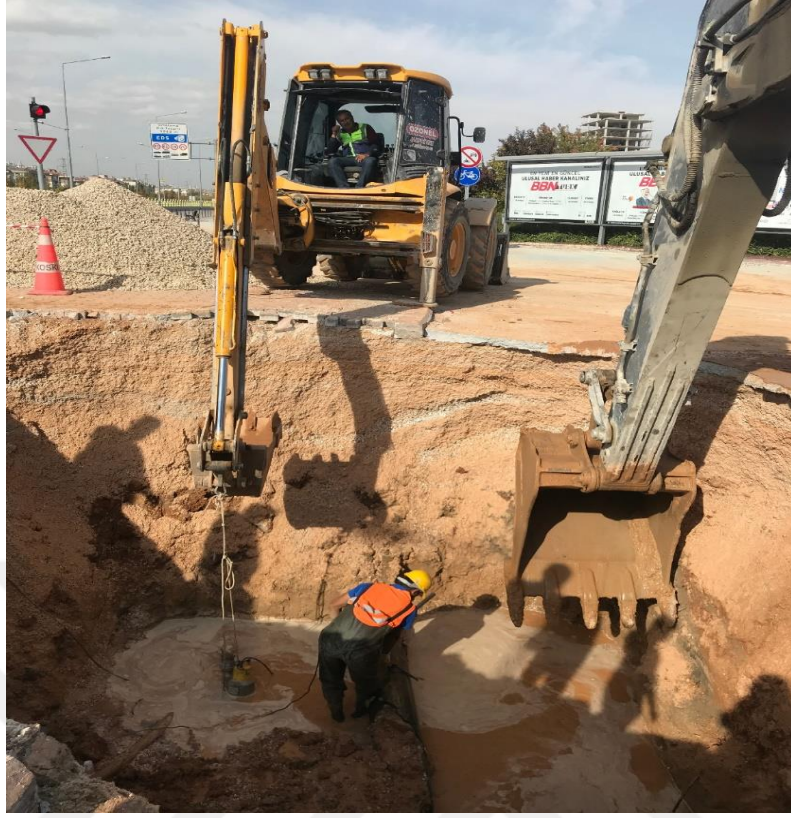
Şekil 7.8. Bakım-onarım esnasında kazı çukurundaki fazla su dalgıç pompa ile tahliye edilmesi (KOSKİ, 2021)
