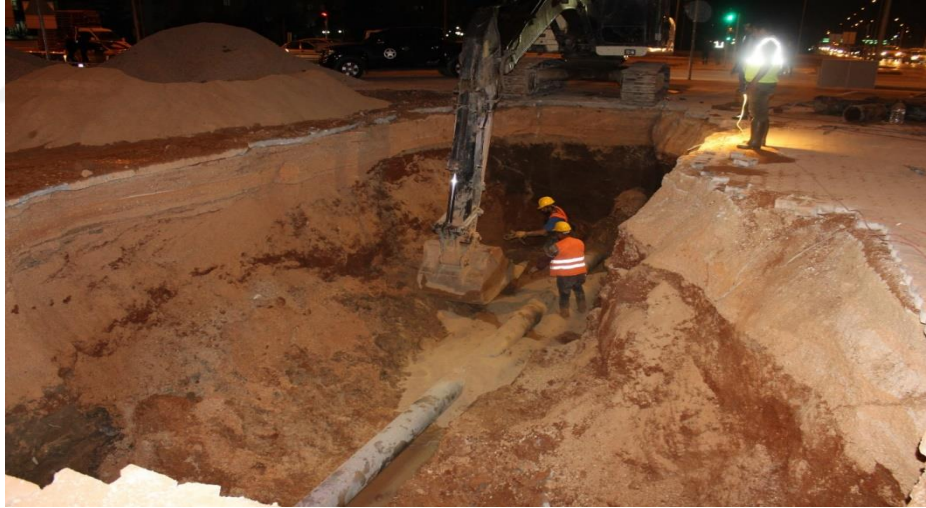
Şekil 7.1. Şebeke hattında bakım-onarım sonrası dolgu işlemi (KOSKİ, 2022)
