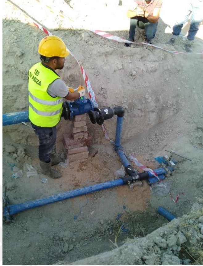
Şekil 7. 10. Şebeke hattında eski vananın değiştirilme işlemi (KOSKİ, 2021)
