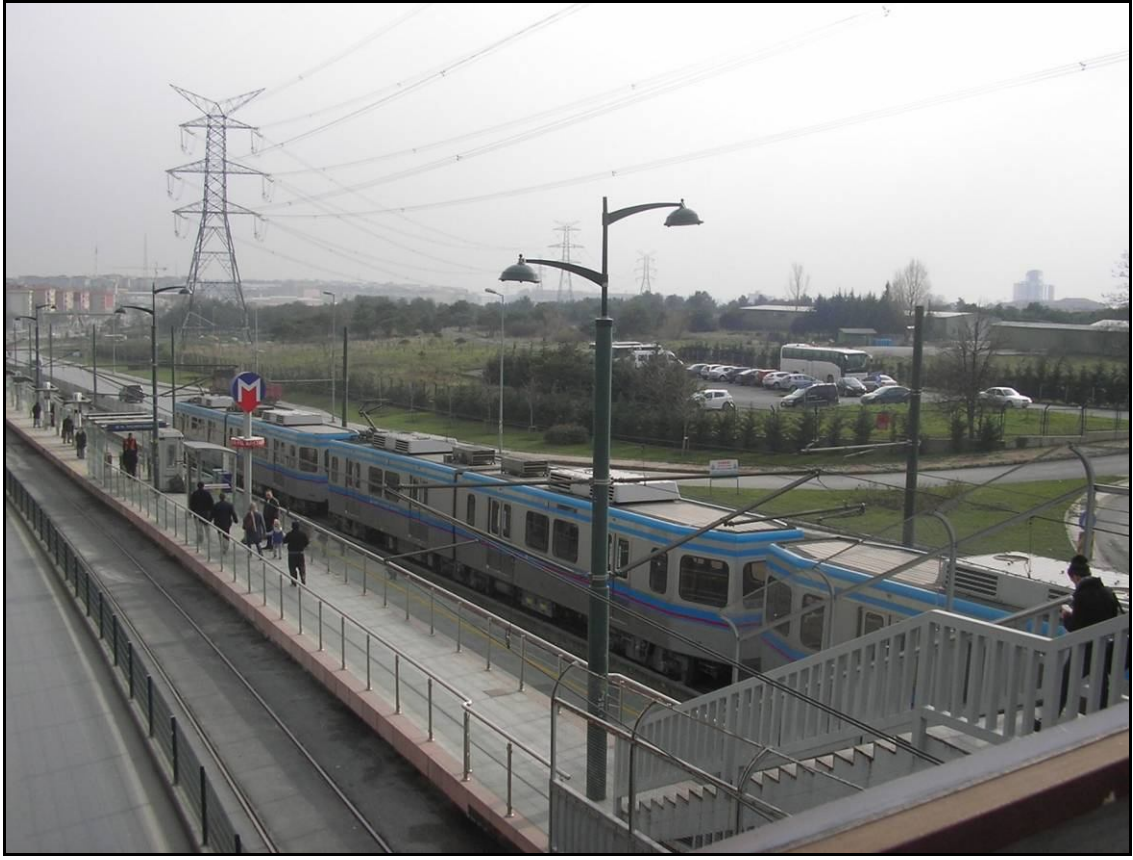
Şekil 19: Sultangazi İlçesi 50. Yıl Mahallesi Tramvay durağından bir görünüm
