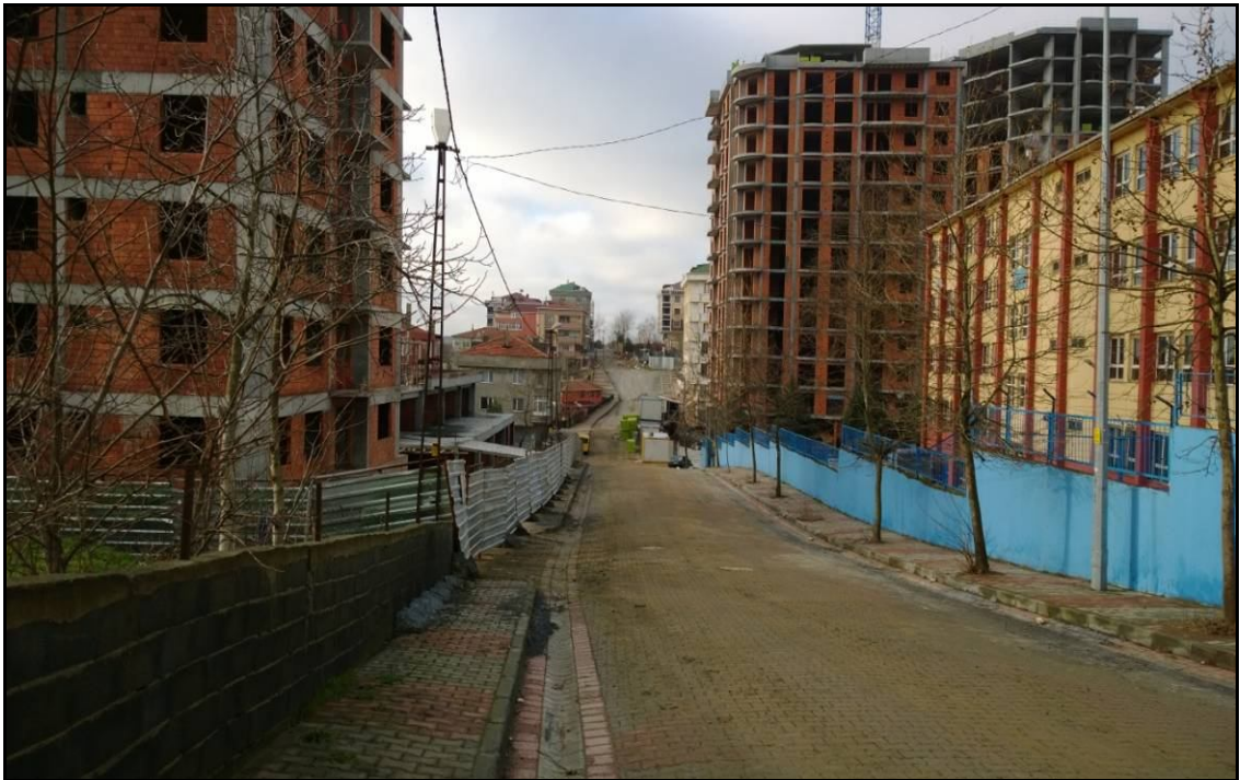
Şekil 28: Sultangazi İlçesi Eski Habipler Mahallesi'ndeki inşaatlardan bir görünüm
