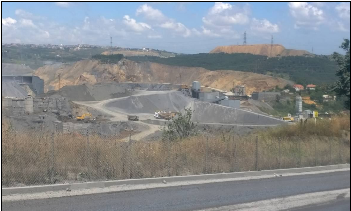
Şekil 24: Sultangazi İlçesi Cebeci Mahallesi Cebeci Köyü çevresindeki taş ocaklarından bir görünüm
