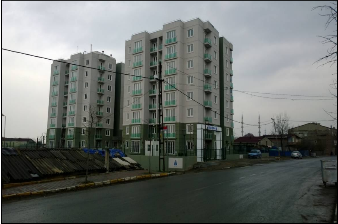
Şekil 31: Sultangazi İlçesi Habipler Mahallesi'ndeki İBB Evlerinden bir görünüm
