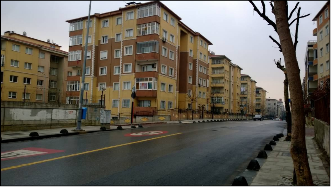
Şekil 35: Sultangazi İlçesi Uğur Mumcu Mahallesi'nde yer alan sitelerden bir görünüm
