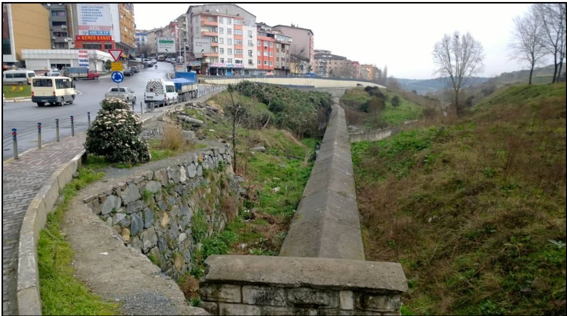
Şekil 42: Sultangazi İlçesi 75.Yıl Mahallesi Lütfi Aykaç Bulvarı’ndaki Apartmanlar ve Tarihi Su Kemerinden bir görünüm
