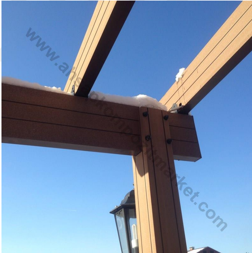
Şekil 1.1. Kompozit ahşap kiriş maket örneđi (Anonim, 2018a)
