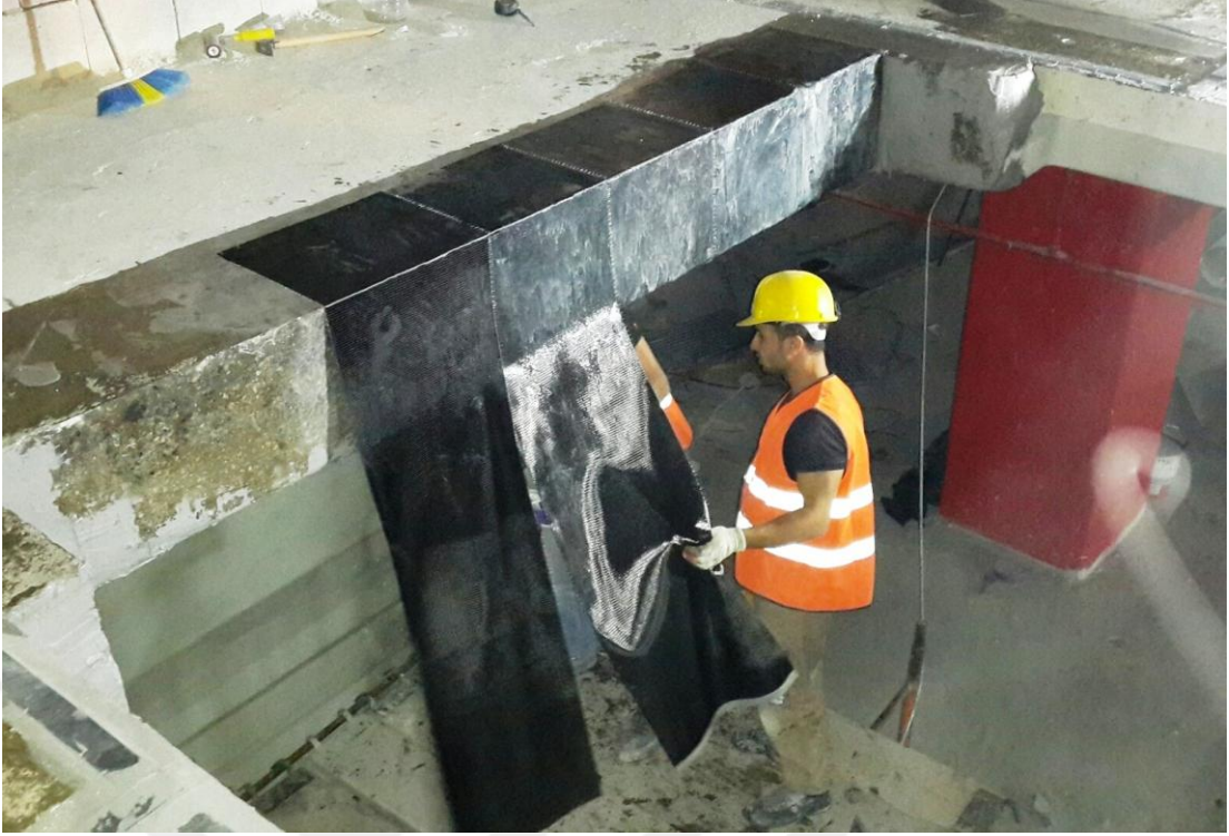
Şekil 2.6. FRP ile kiriş güçlendirme uygulaması (Anonim 2018h)
