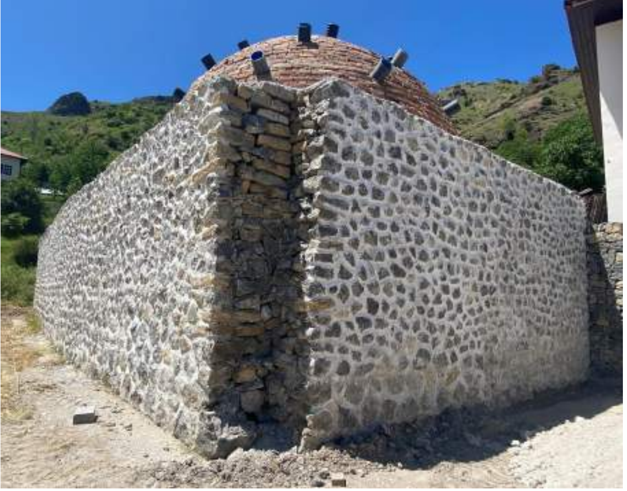
Şekil 178: Hamamın dış cepheden görünümü
