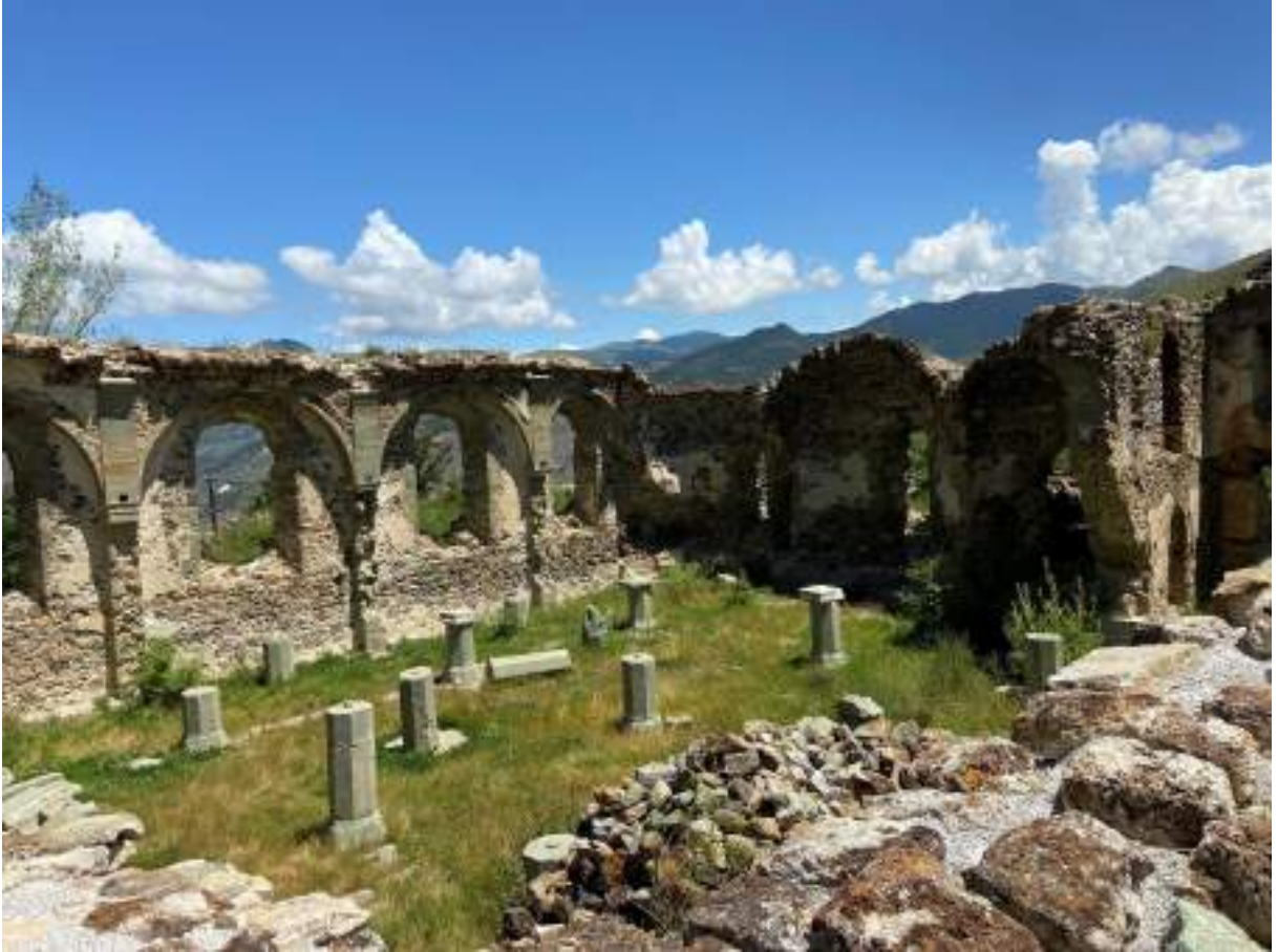
Şekil 87: Güneybatı köşeden iç mekan görünümü
