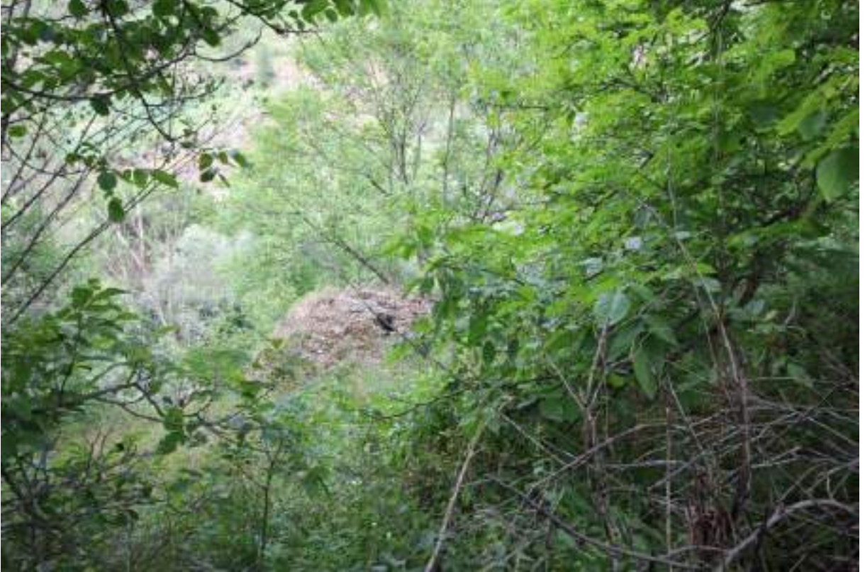
Şekil 169: Kavaklık hamamı güneyden görünümü
