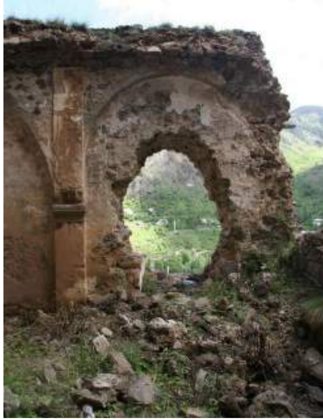
Şekil 107: Ioannes Prodromos Kaya Kilisesinin güney cephesi pencere açıklıkları
