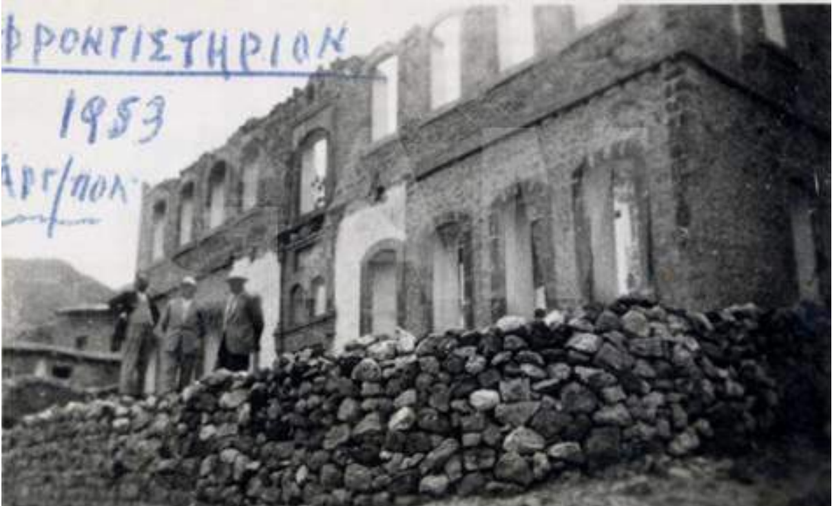
Şekil 128: Yapının 1953'te görünümü (Kostas Papadopoulos Arşivi)
