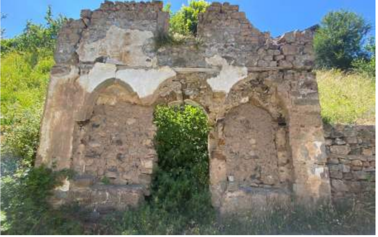
Şekil 211: Taş Dükkan 1'in giriş cephesi
