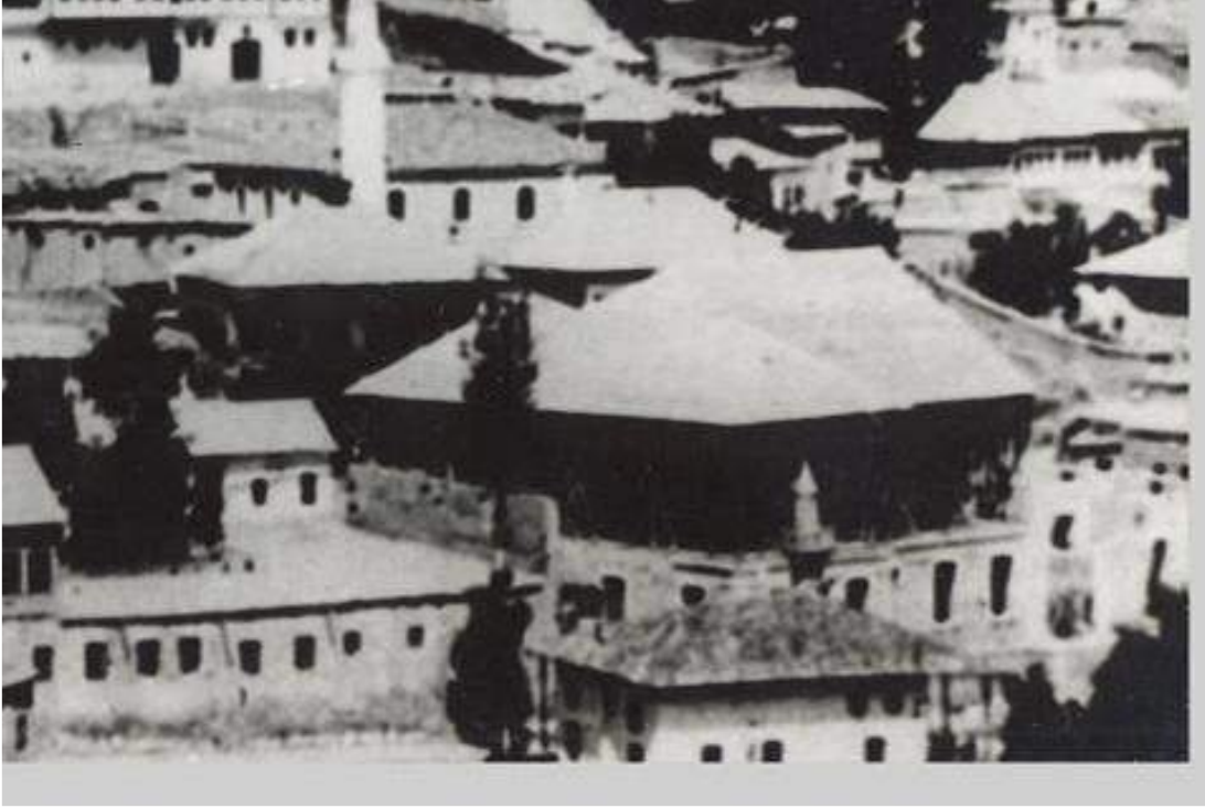
Şekil 140: 20. yy başında inşaat halindeyken görünümü (Güneri Kadirbeyoğlu Arşivi)
