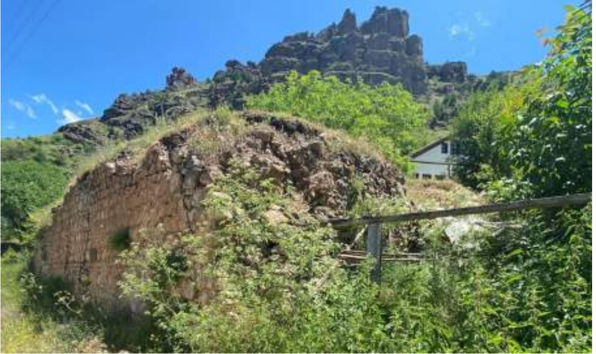
Şekil 157: Hamamın dış cepheden görünümü
