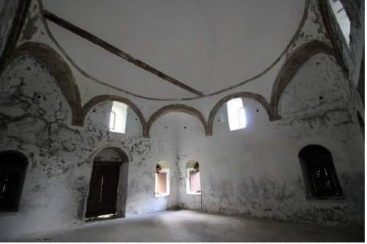
Şekil 24: Küçük Camii iç cephesinin genel görünümü (Karadeniz Kültür Envanteri)
