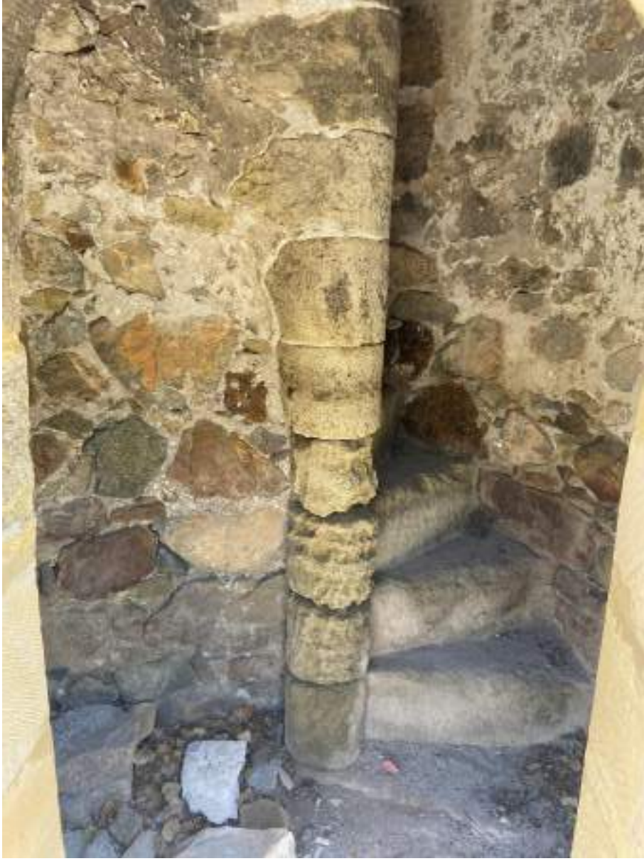
Şekil 51: Minarede yer alan merdivenin görünümü
