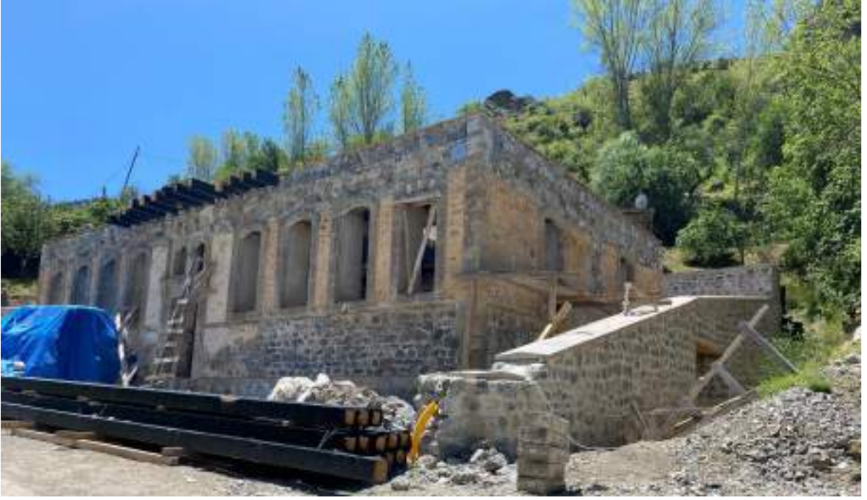
Şekil 131: Yapıdaki restorasyon çalışmaları
