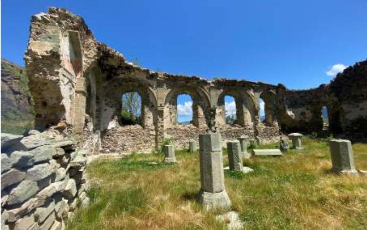
Şekil 89: Kuzey duvarı görünümü
