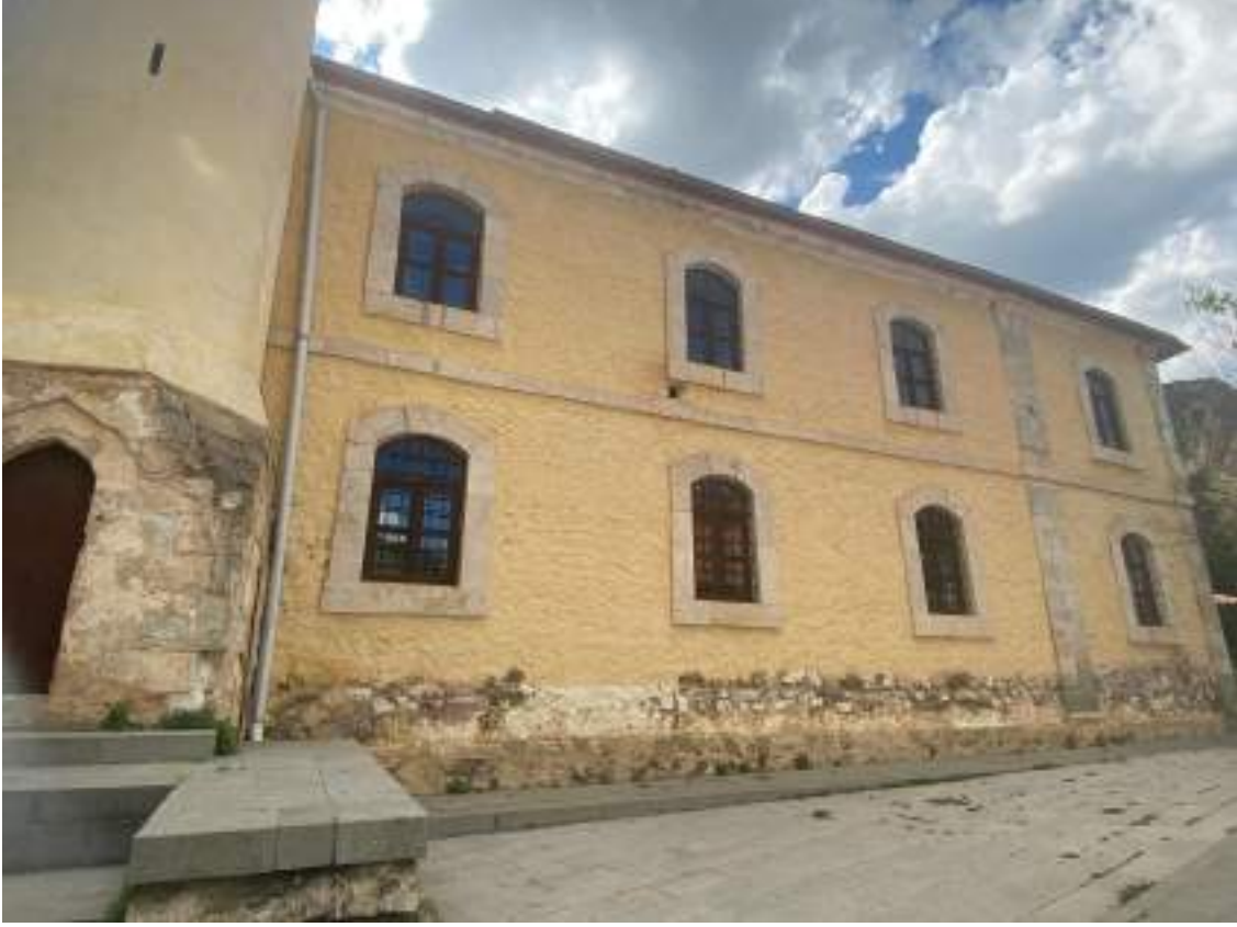
Şekil 36: Camiinin doğu cephesi
