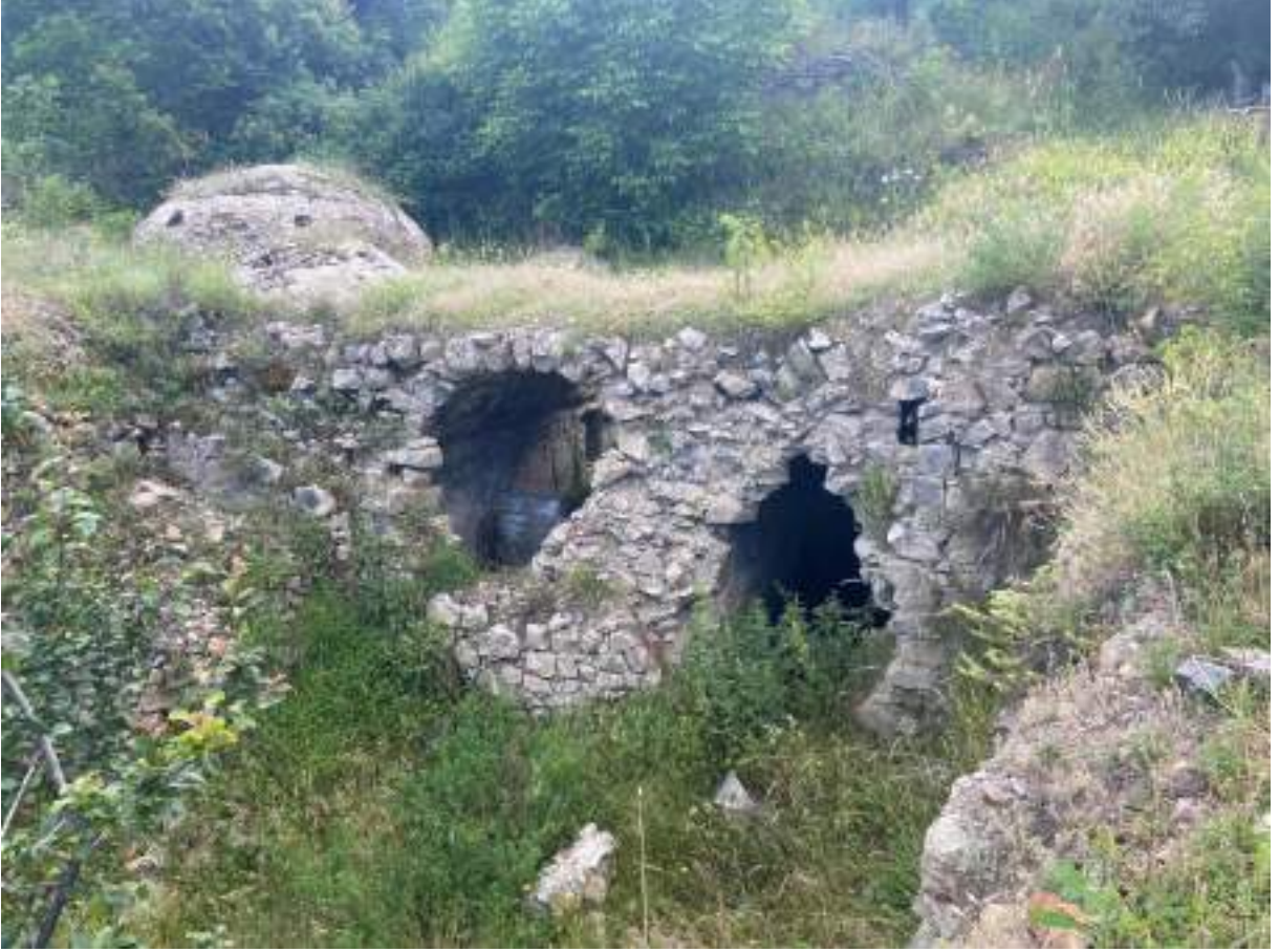
Şekil 190: Hamamın dış cepheden görünümü
