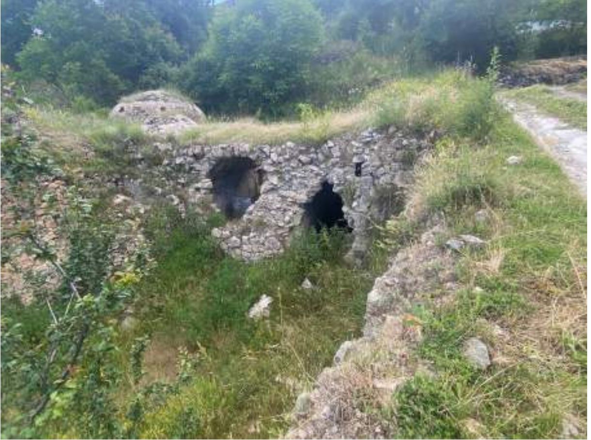
Şekil 189: Hamamın dış cepheden görünümü
