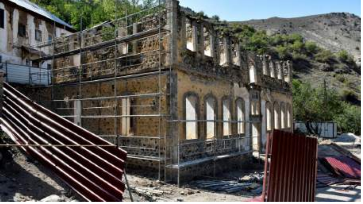
Şekil 133: Yapıdaki restorasyon çalışmaları
