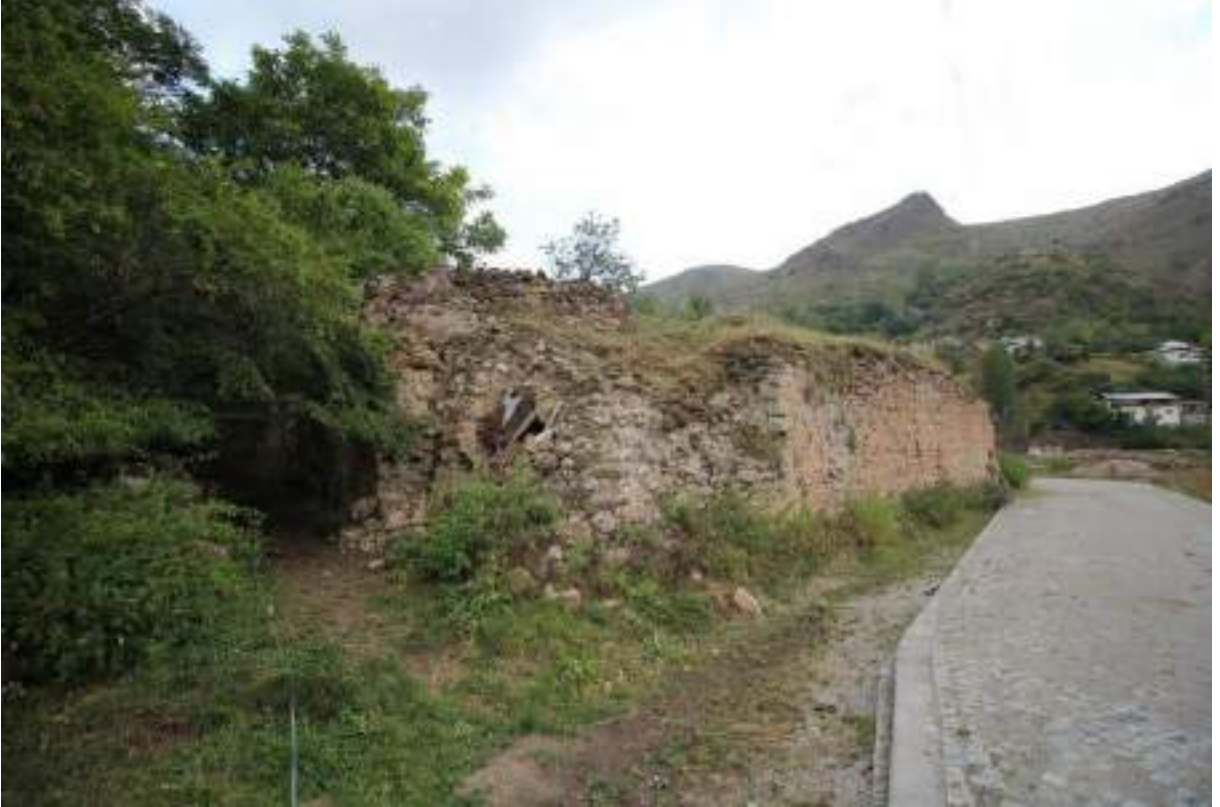
Şekil 155: Hamamın dış cepheden görünümü
