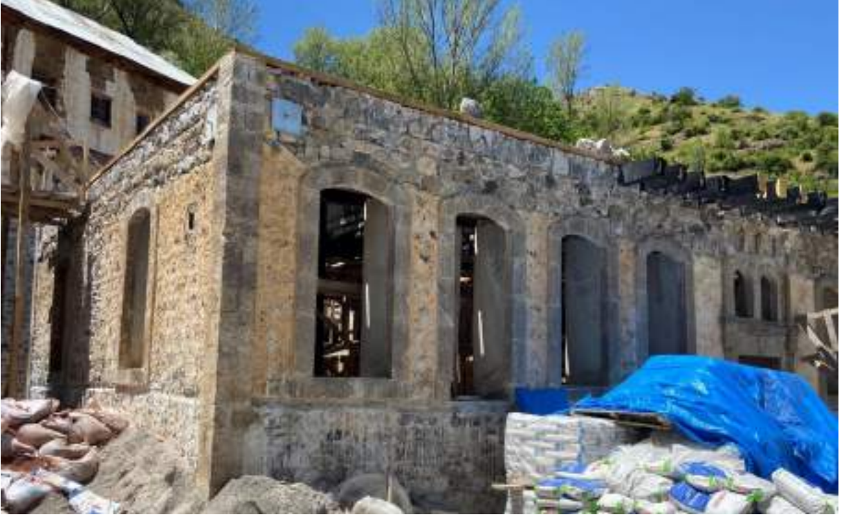
Şekil 132: Yapıdaki restorasyon çalışmaları
