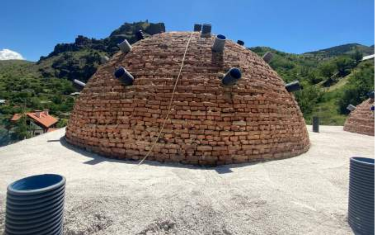
Şekil 181: Hamamın kubbe ve filgözü
