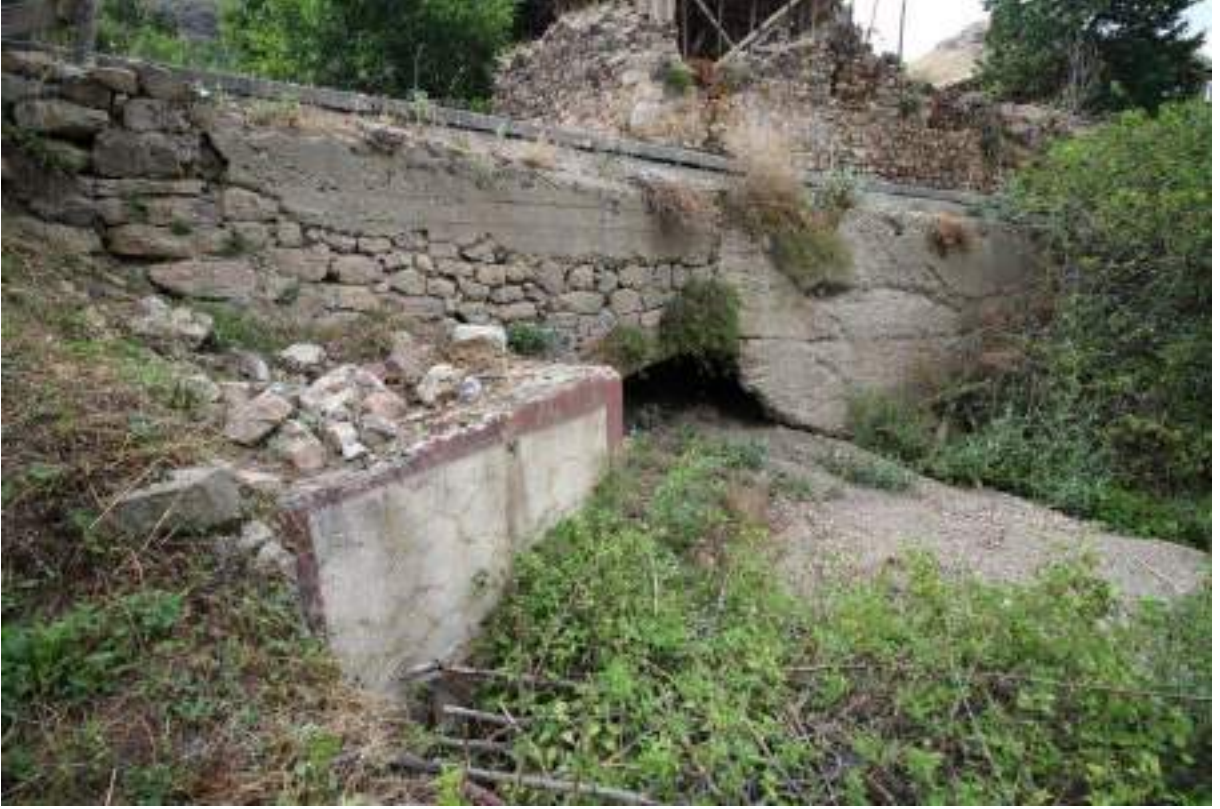
Şekil 198: Dalbatan Köprüsünün görünümü
