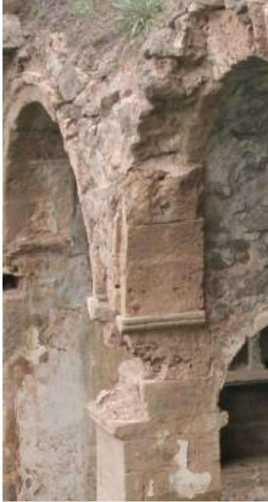
Şekil 98: Hagios Theodoros Kilisesi iç mekan detayı
