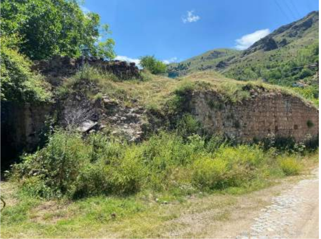
Şekil 161: Hamamın dış cepheden görünümü
