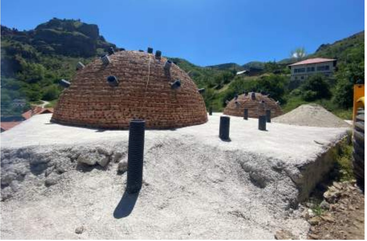
Şekil 180: Hamamın kubbe ve filgözü
