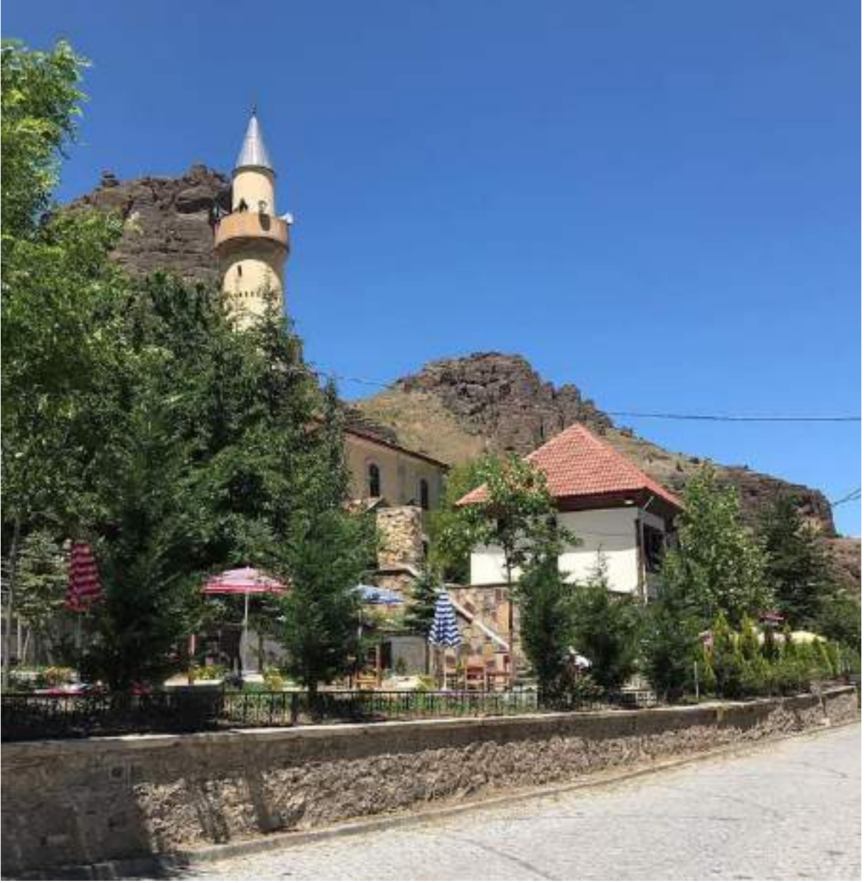
Şekil 124: Yapının bahçe ve dış cepheden görünümü
