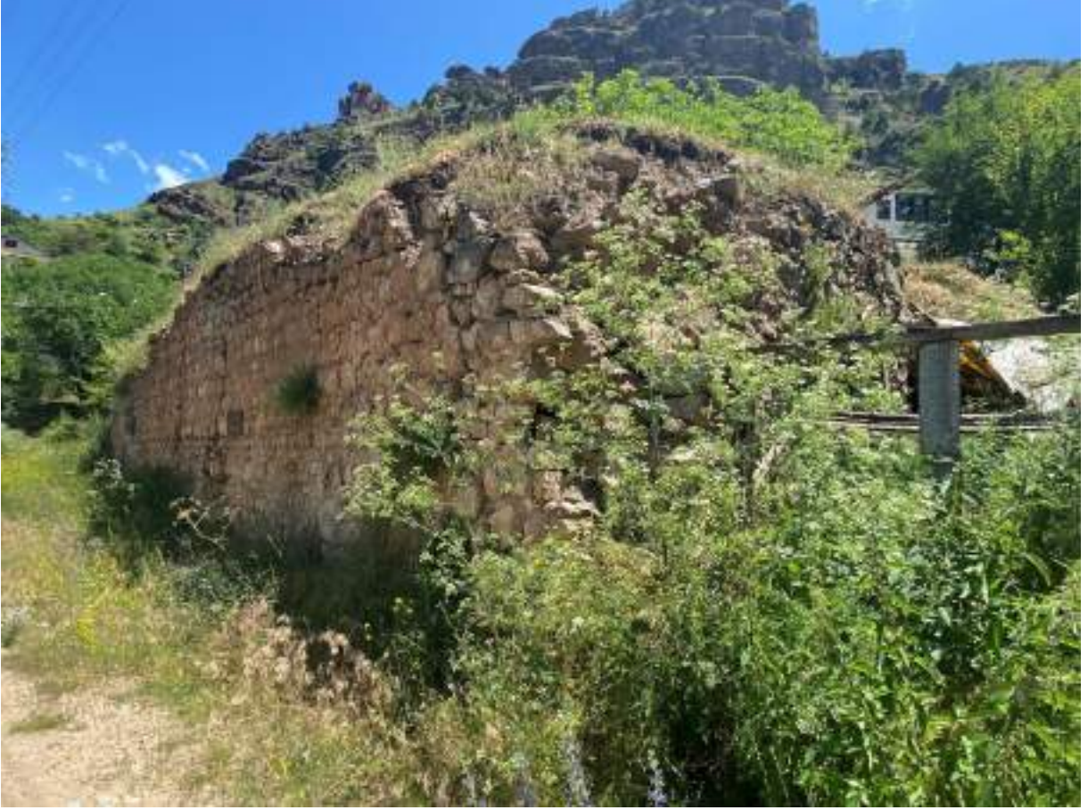
Şekil 158: Hamamın dış cepheden görünümü
