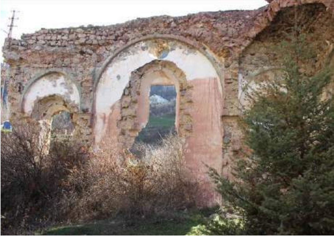
Şekil 115: Kilisenin kuzey duvarı ve üst örtüye ait izler (D. Okuyucu'dan)
