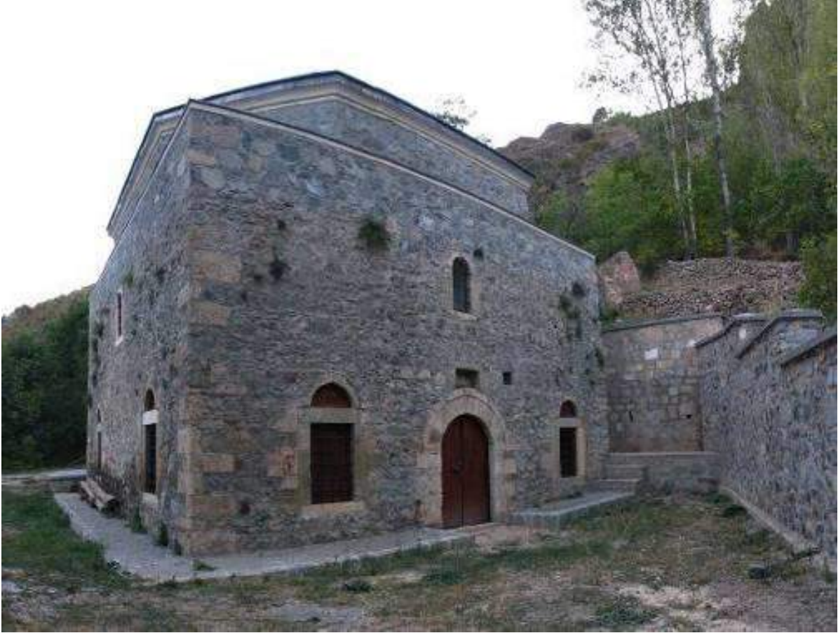
Şekil 16: Küçük Cami restorasyon sonrası
