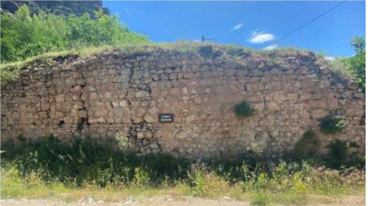
Şekil 159: Hamamın dış cepheden görünümü
