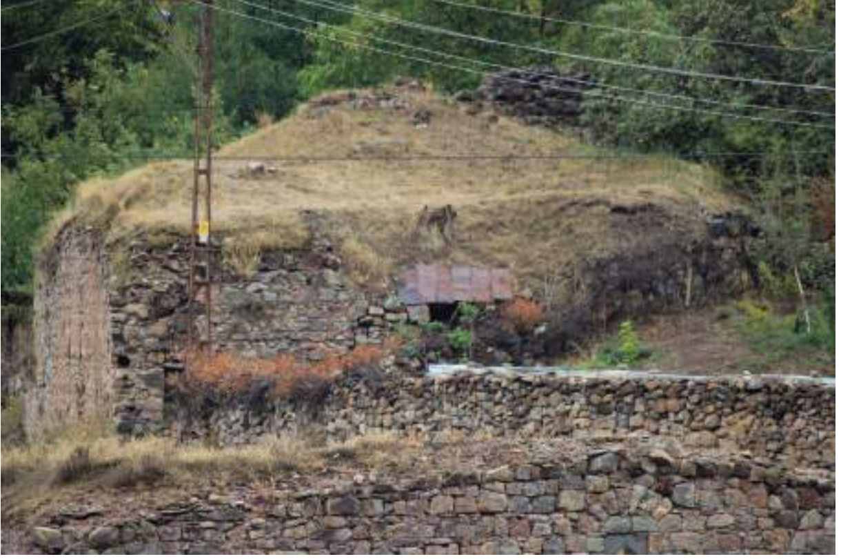
Şekil 154: Hamamın dış cepheden görünümü
