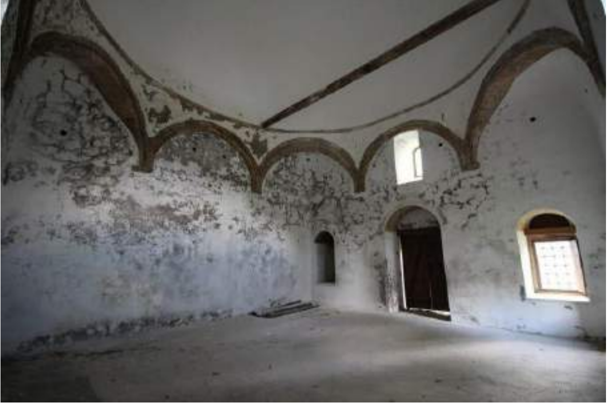
Şekil 22: Küçük Camii iç cephesinin genel görünümü (Karadeniz Kültür Envanteri)
