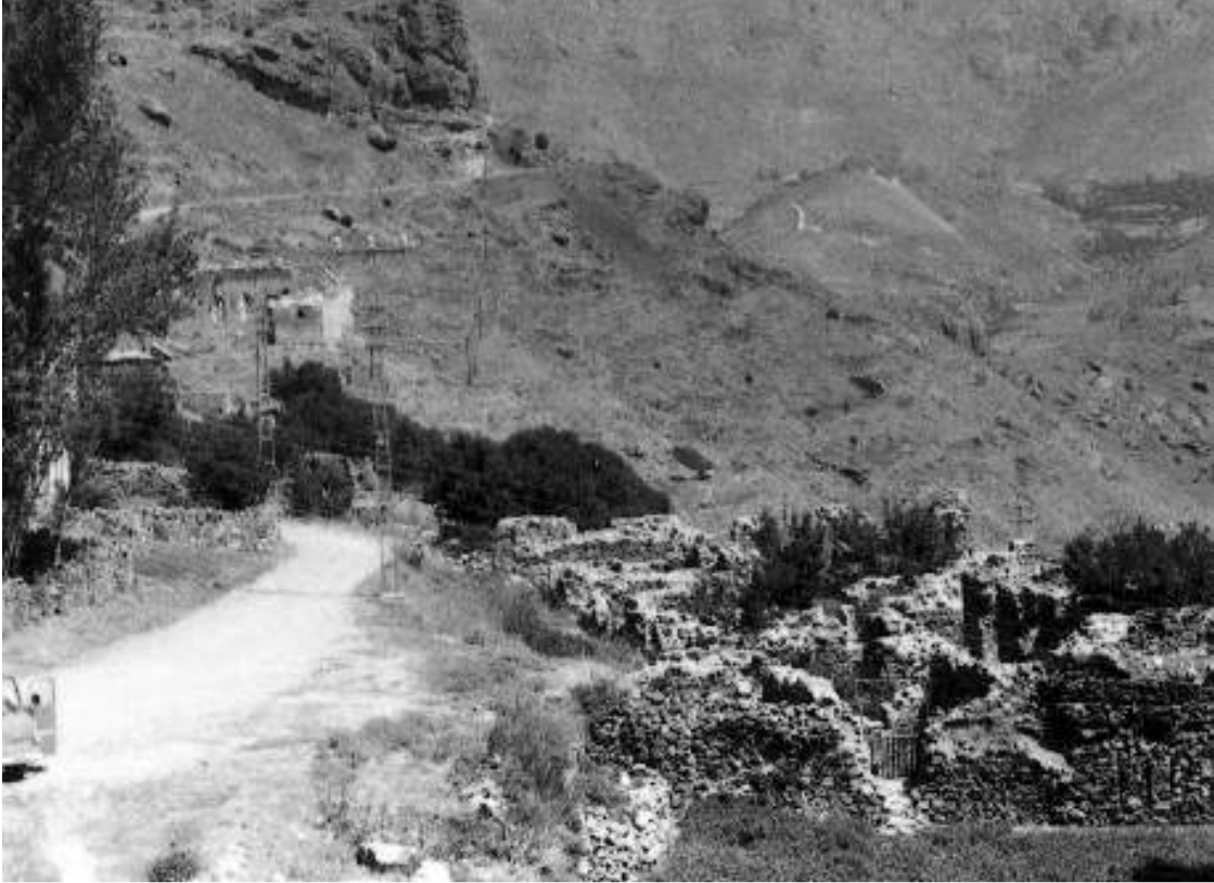
Şekil 141: Yapının 1970'lerde görünümü (Güneri Kadirbeyoğlu Arşivi)
