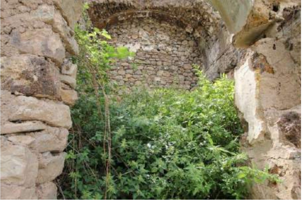
Şekil 219: Taş Dükkan 1'in iç cephesi
