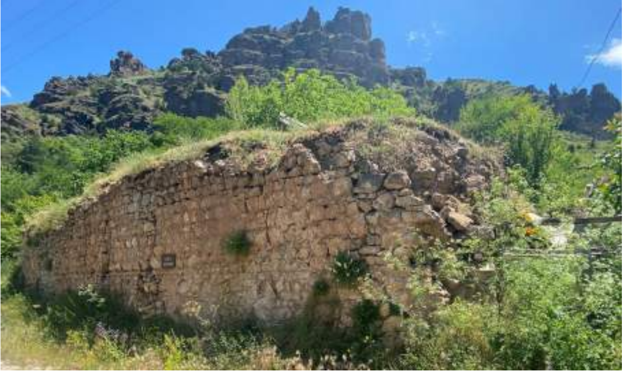
Şekil 156: Hamamın dış cepheden görünümü
