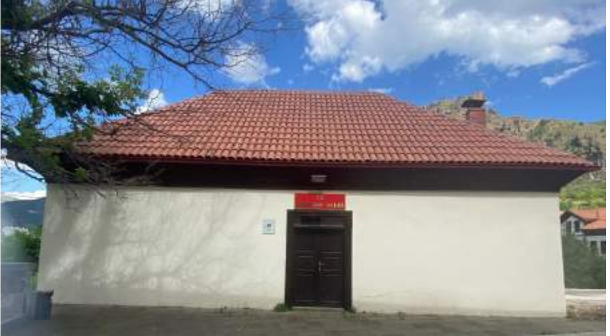
Şekil 123: Yapının Gümüşhane Valiliği'ne ait cephesi
