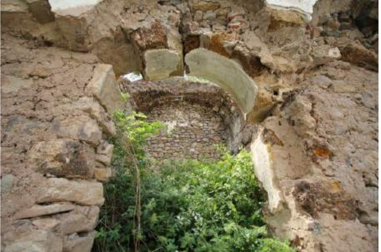
Şekil 218: Taş Dükkan 1'in iç cephesi
