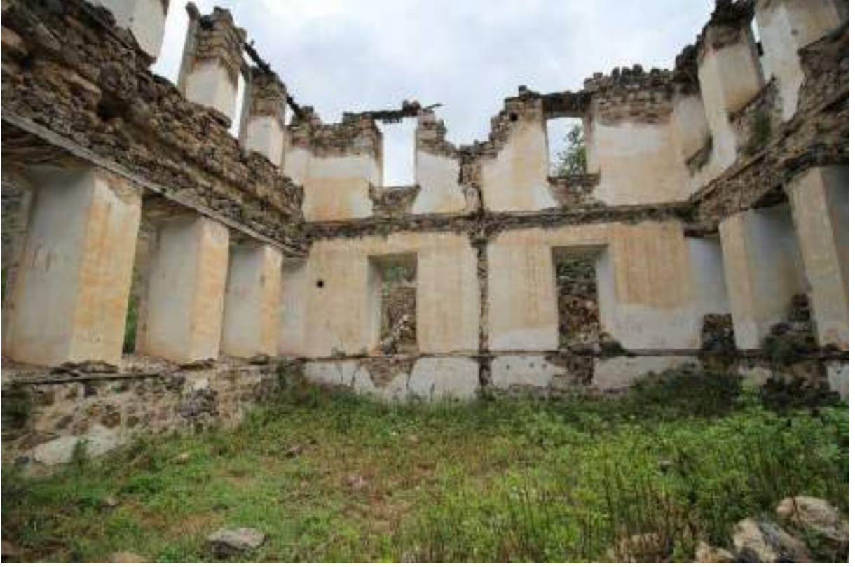
Şekil 135: Yapının iç cephe görünümü
