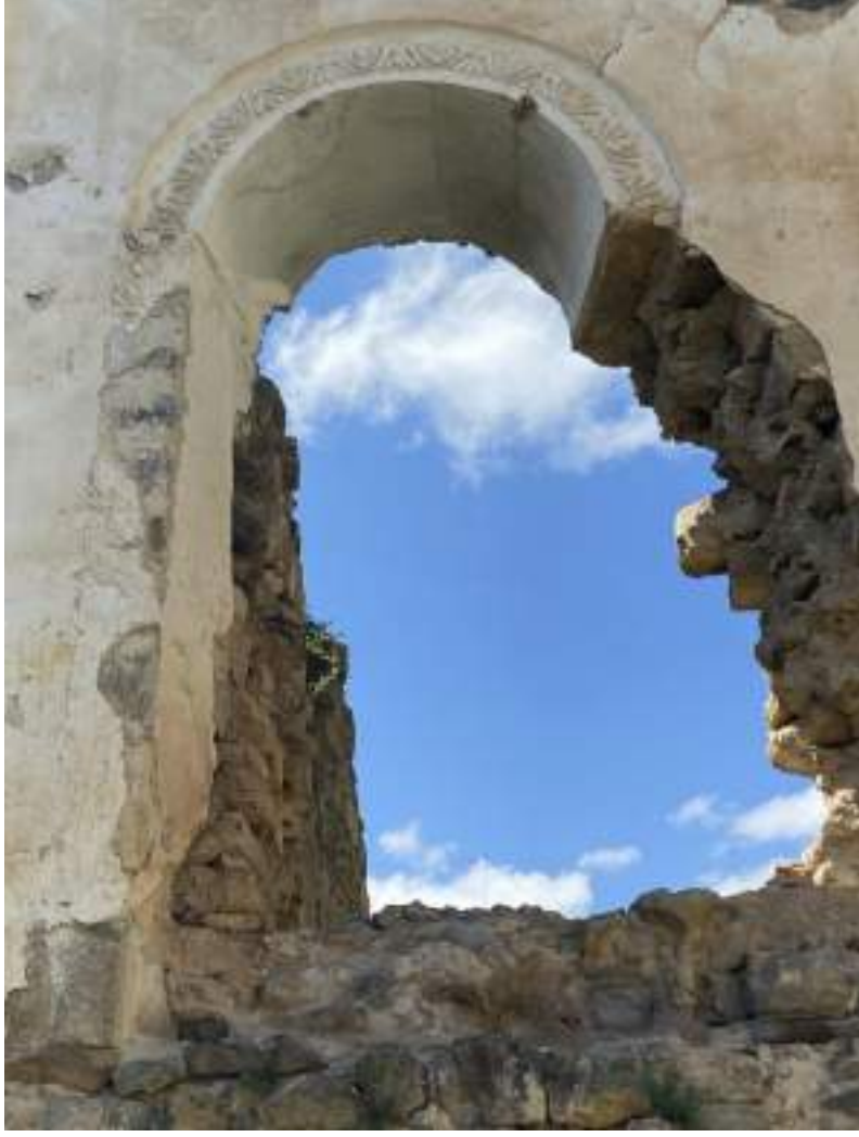
Şekil 72: Kuzey duvarında yer alan pencere nişlerinin üzerindeki bitkisel bordür
