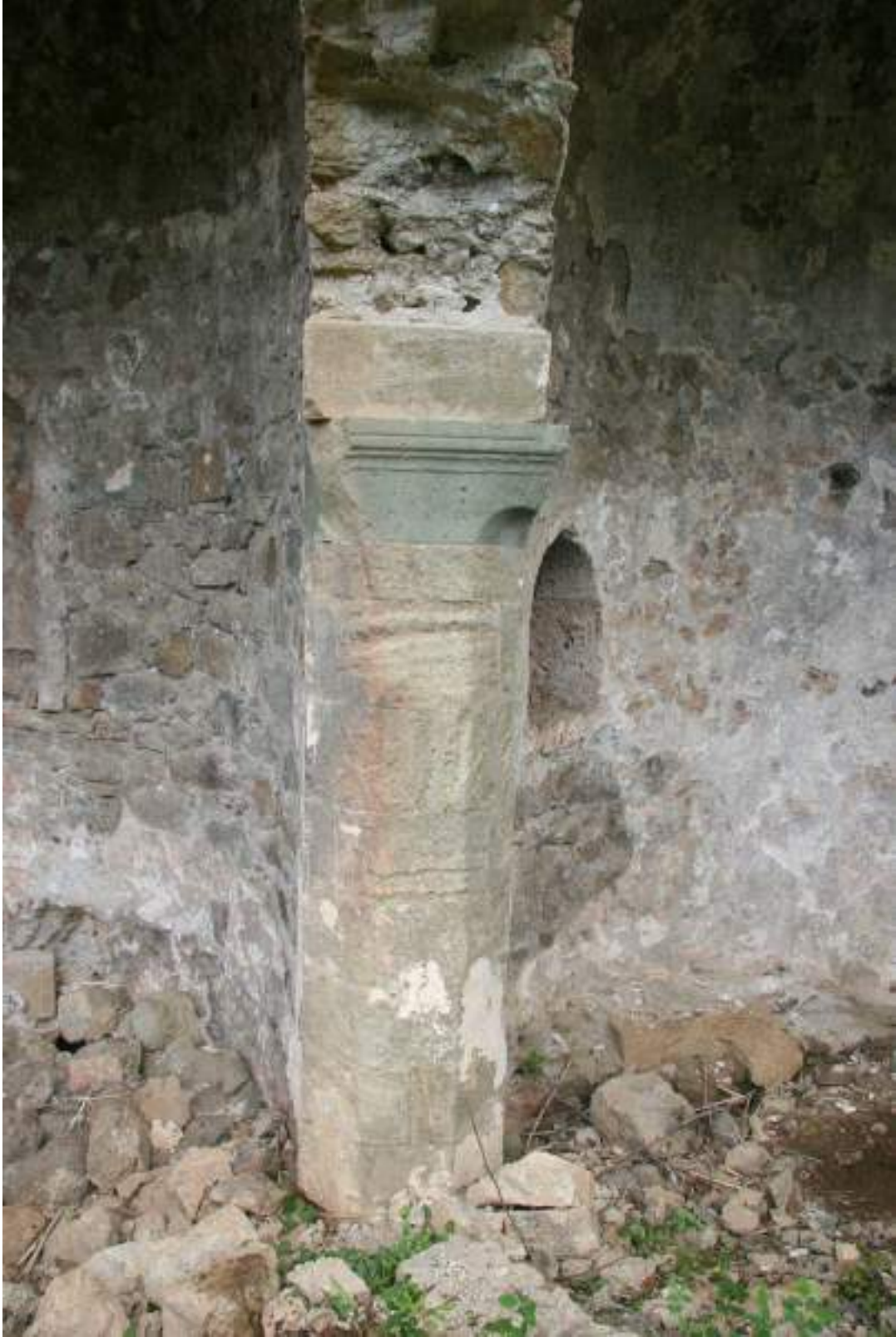
Şekil 99: Hagios Theodoros Kilisesi iç mekan detayı
