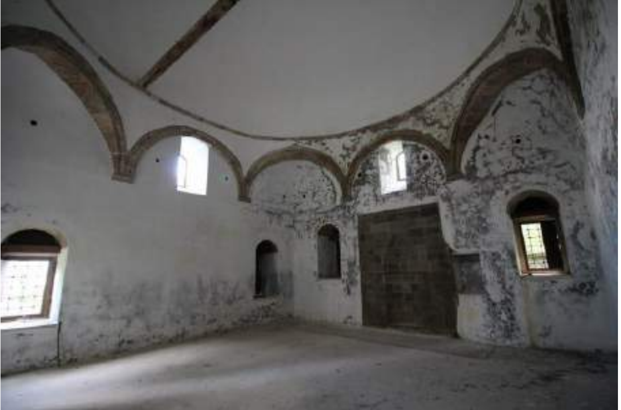
Şekil 21: Küçük Camii iç cephesinin genel görünümü (Karadeniz Kültür Envanteri)
