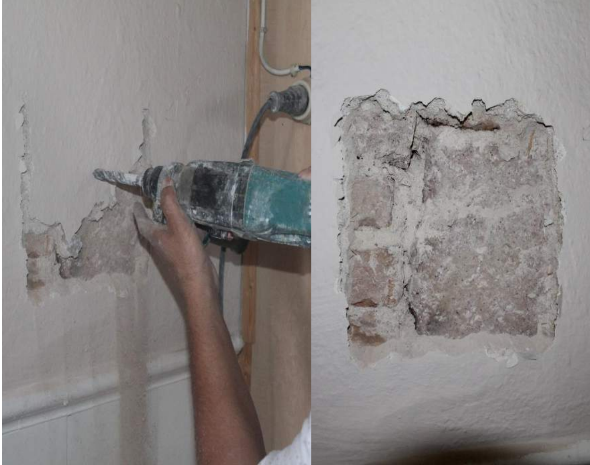
Şekil 4.1.7 : İkinci Katta Yapılan Sıva Kaldırma Uygulaması ile Malzeme Tespit İşlemi, a) Uygulama, b) Duvarın Görünümü.
