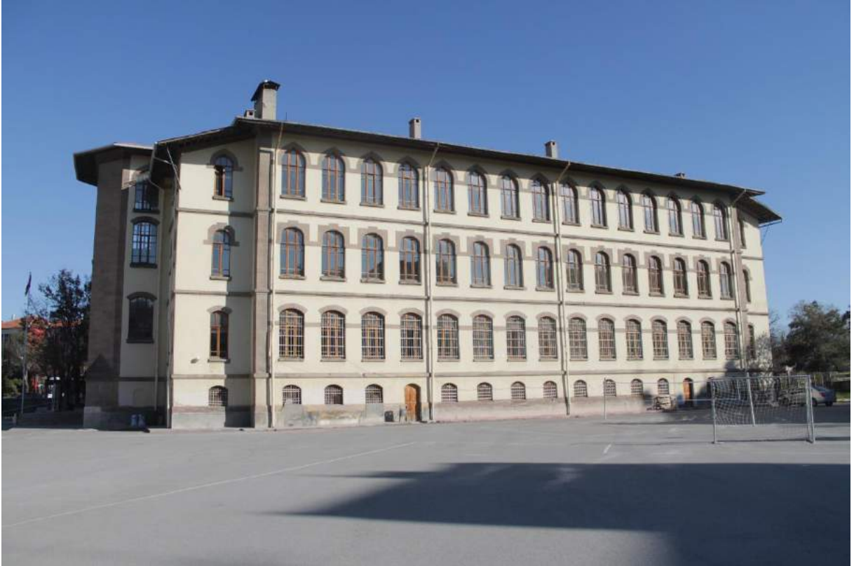
Şekil 3.5.3 : Konya Lisesi Arka Cephesi.
