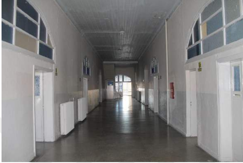
Şekil 4.1.11 : İkinci Kat Tavan Ahşap Döşemesi.
