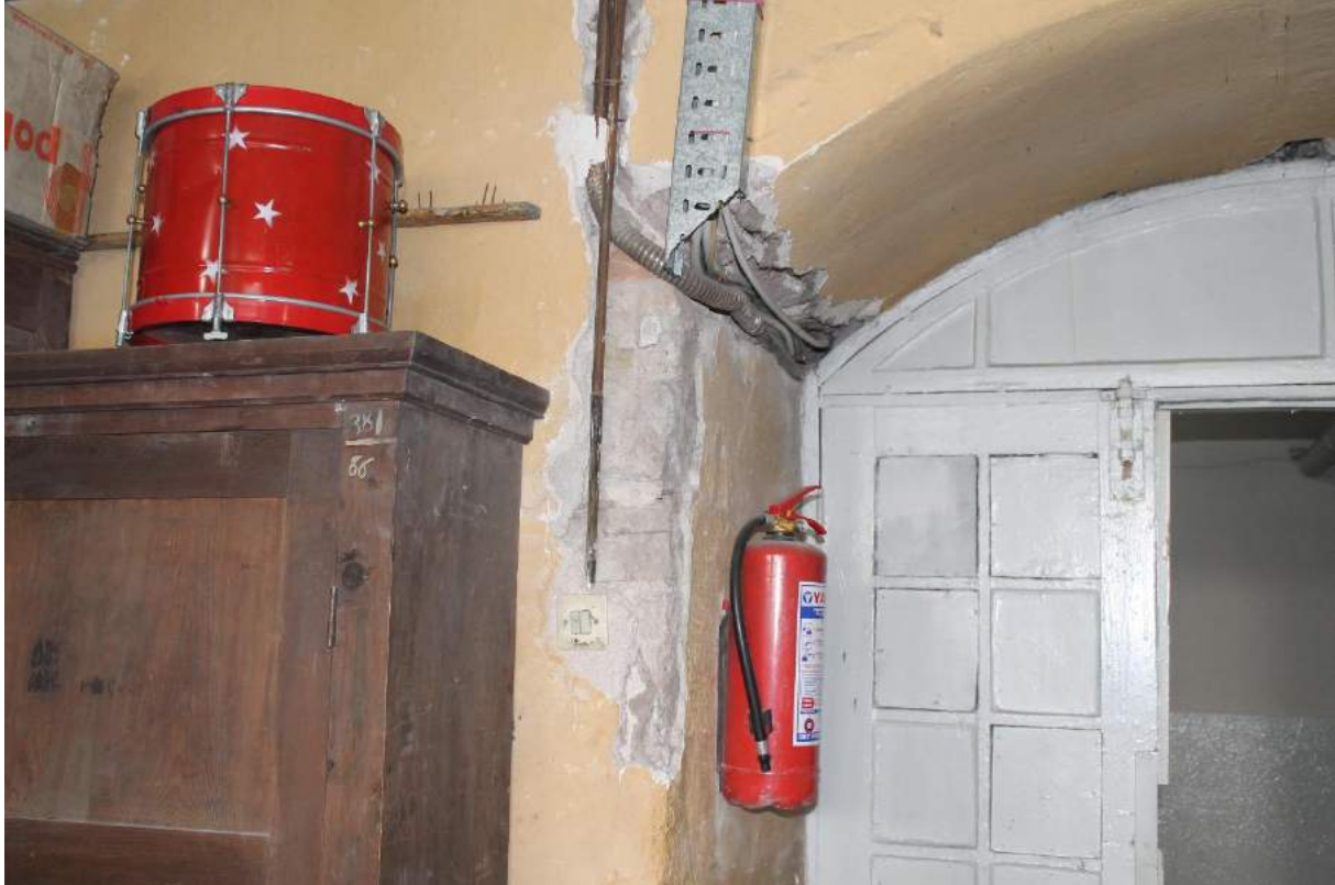
Şekil 4.1.6 : Bodrum Katta Kapı Kemerini Taşıyan Duvarda Malzeme Tespiti.
