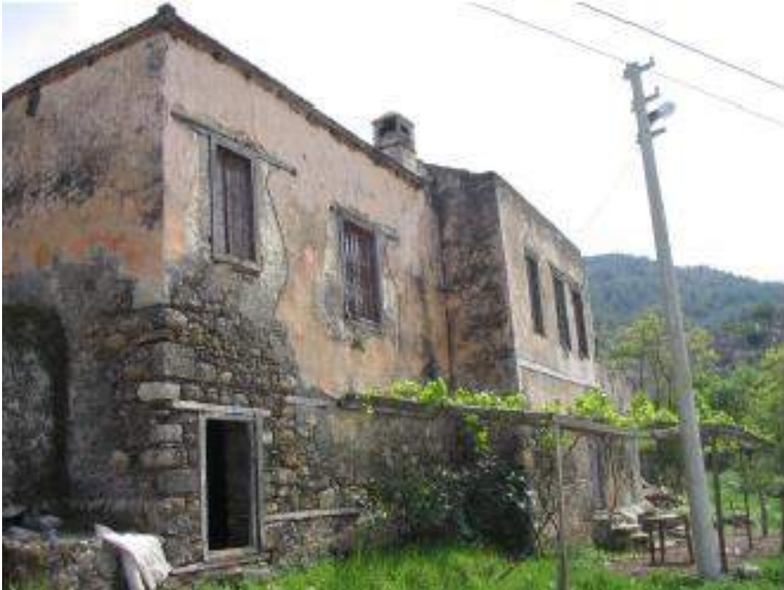
Şekil 3.7: Doğal taş yığma yapı örneği. (Korkmaz, 2007)
