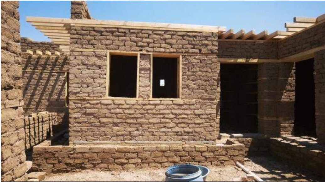
Şekil 3.6: Kerpiç yiğma yapı örneği. (Web iletisi 3)
