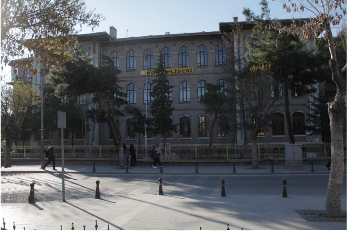
Şekil 3.5.2 : Konya Lisesi Ön Cephesi.
