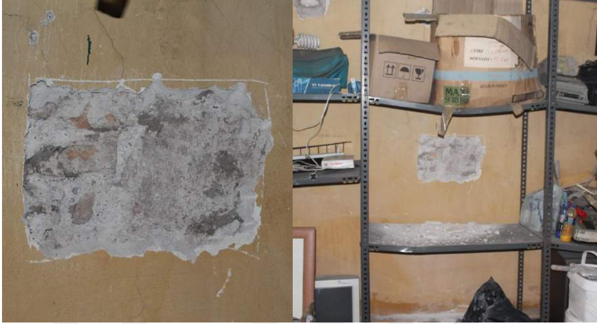
Şekil 4.1.5 : Bodrum Katta Yapılan Sıva Kaldırma Uygulaması ile Malzeme Tespit İşlemi, a)Yakın Görünüm, b)Duvarın Geniş Görünümü.
