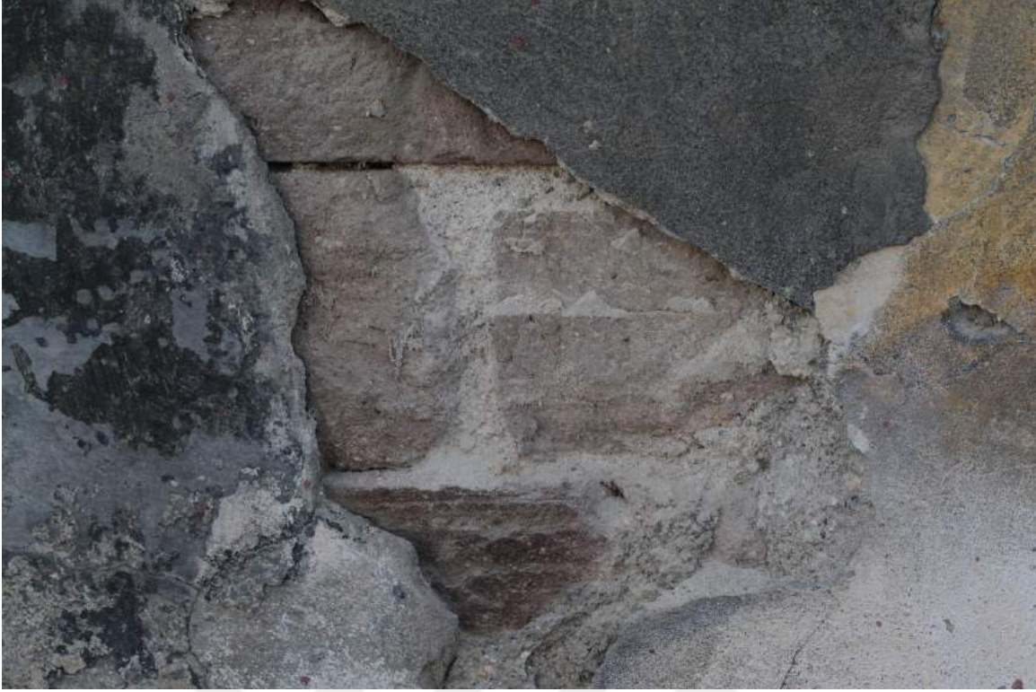
Şekil 4.1.8 : Dış Cephe Duvarında Malzeme Tespiti.
