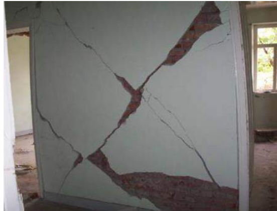
Şekil 3.10: Yığma yapılarda kesme hasarı (Doğangün ve ark., 2008).
