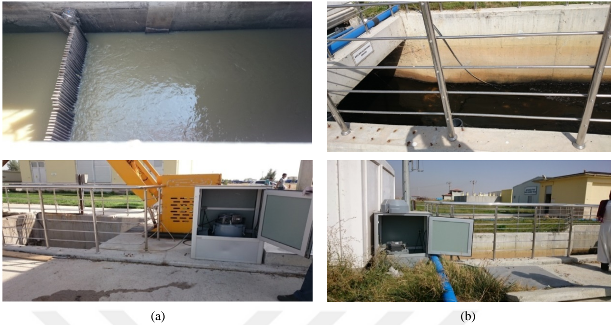
Şekil 3.2. Konya Kentsel Atıksu Arıtma Tesis giriş (a) ve çıkışından (b) atıksu örneklerinin alınması
