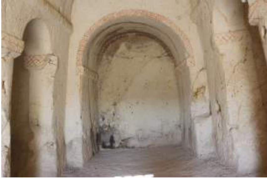
Fotoğraf 473: Toplantı Bölümü Kuzey Cephesi
