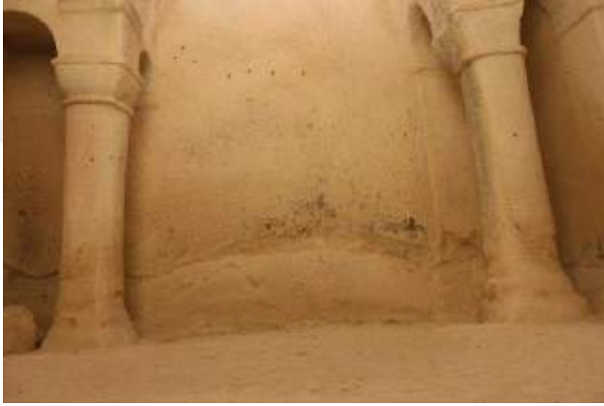
Fotoğraf 502: Hastane Bölümü Güney Cephe ve Sütun Görünümü
