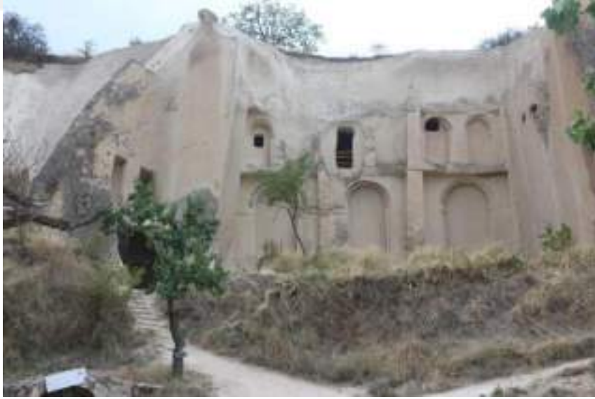
Fotoğraf 150: Aynalı (Fırkatan) Kilisesi Genel Görünüm
