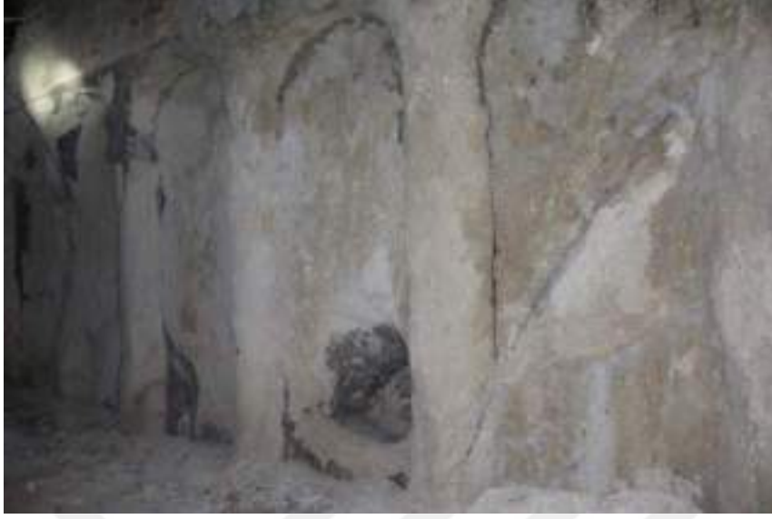
Fotoğraf 517: Mehmet Akcur Evi Yapısı Kuzey Nef Beden Duvarı
