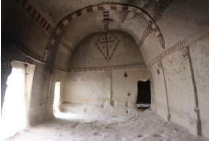
Fotoğraf 167: Aynalı (Fırkatan) Kilisesi Toplantı Salonu Batı Cephesi ve Üst Örtü
