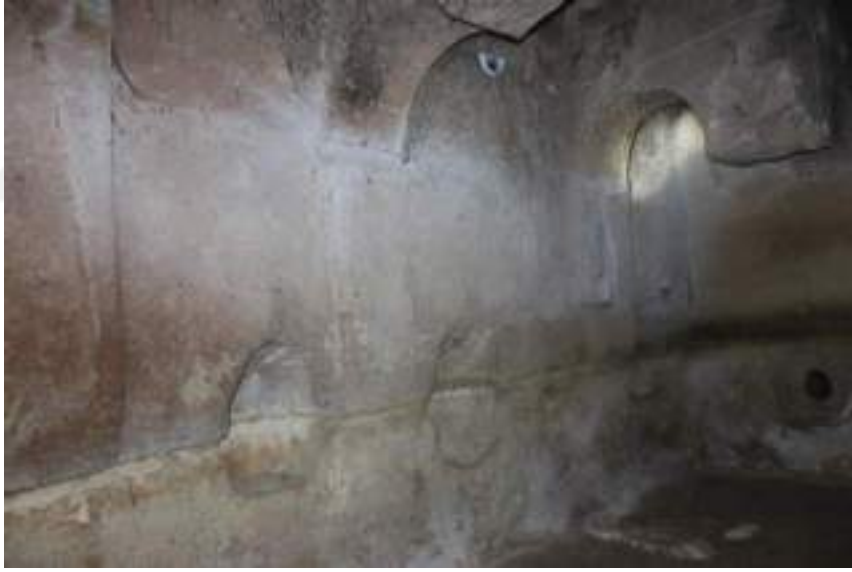
Fotoğraf 426: Mehmet Gül Evi Kilisesi Güney Haç Kolu Duvarı
