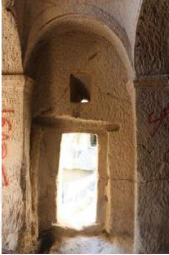
Fotoğraf 209: Kanlıbağ Mevki 1 Nolu Kilise Batı Cepheden Görünüm
