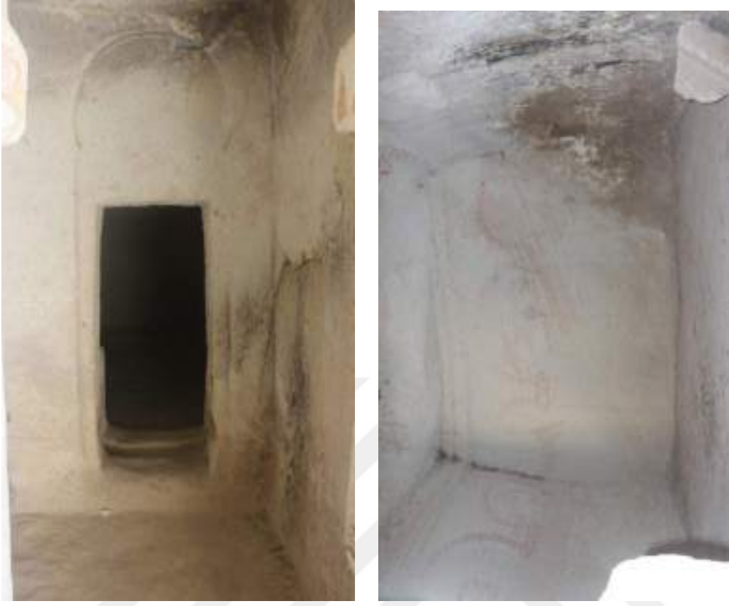
Fotoğraf 479: Mutfak Bölümü Giriş Cephesi ve İçerisinden Genel Görünüm
