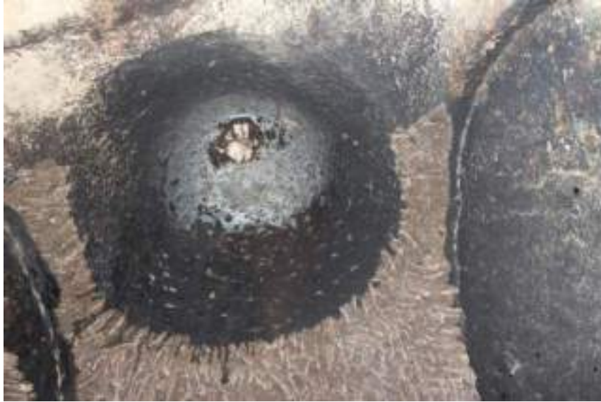
Fotoğraf 537: Ali Yetim Evi Yapısı Pastophoria Mekânı Üst Örtüsü
