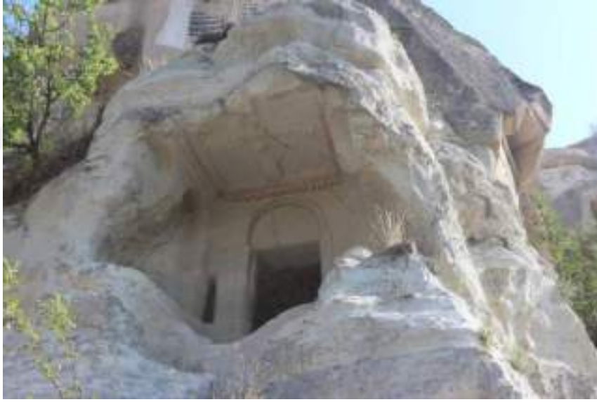
Fotoğraf 6: Beybağı Geçiti 1 Nolu Kilise Giriş Cephesi Görünümü
