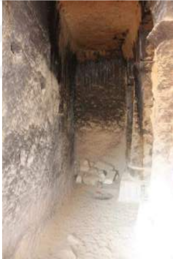
Fotoğraf 539: Ali Yetim Evi Yapısı Kuzey Nef İçi Görünümü
