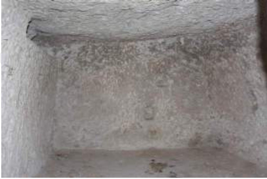
Fotoğraf 534: Ali Yetim Evi Yapısı Ek Mekân İçinden Görünüm
