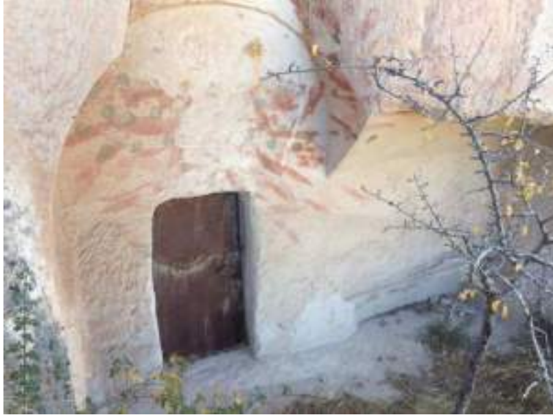
Fotoğraf 325: Beybağı Geçiti 3 Nolu Kilise Giriş Cephesi
