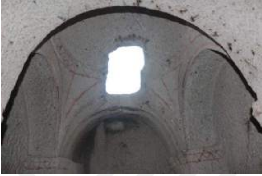
Fotoğraf 203: Kanlıbağ Mevki 1 Nolu Kilise Üst Örtüsü
