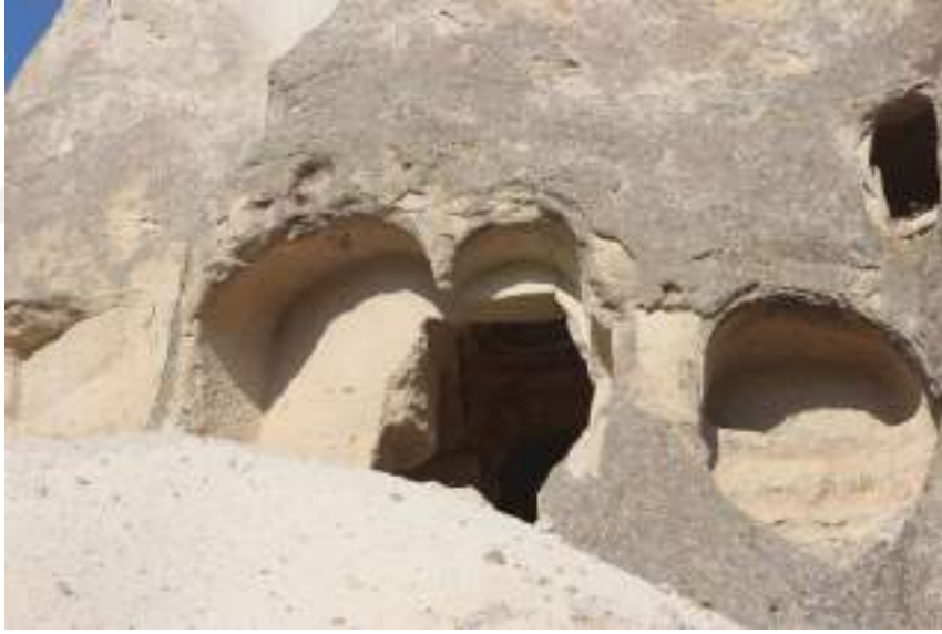
Fotoğraf 289: Balkan Deresi 2 Nolu Kilise Giriş Cephesi
