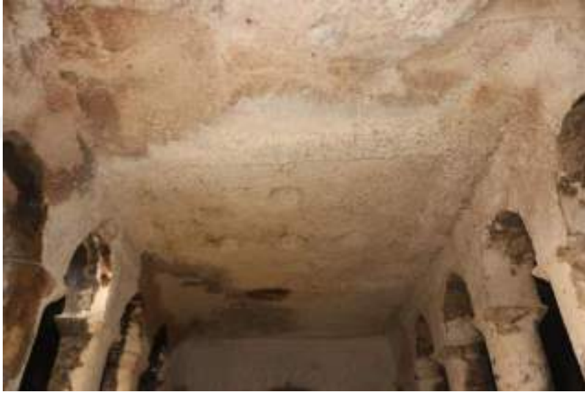
Fotoğraf 532: Ali Yetim Evi Yapısı Üst Örtüsü
