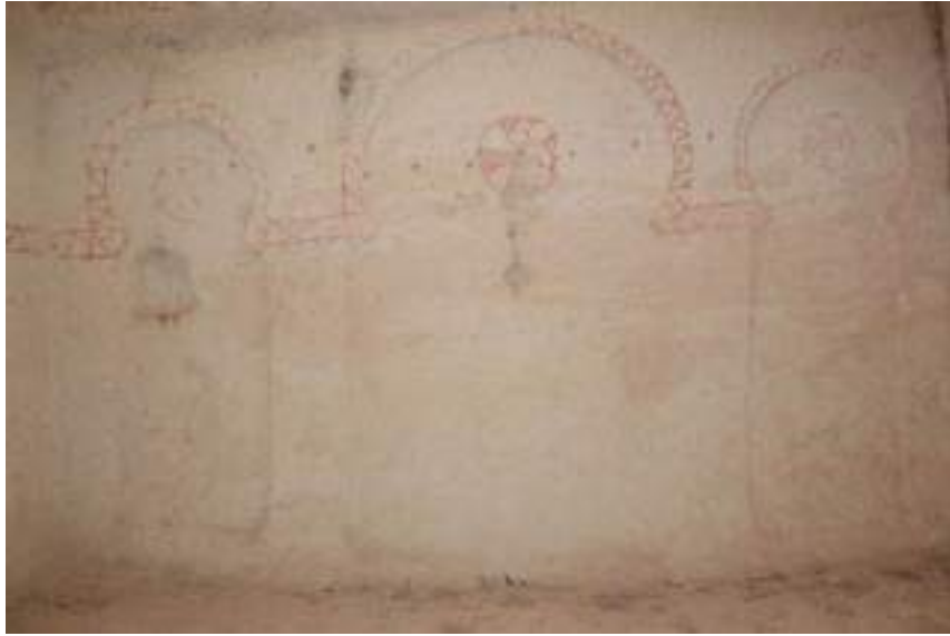
Fotoğraf 480: Mutfak Bölümü Kuzey Cephesi
