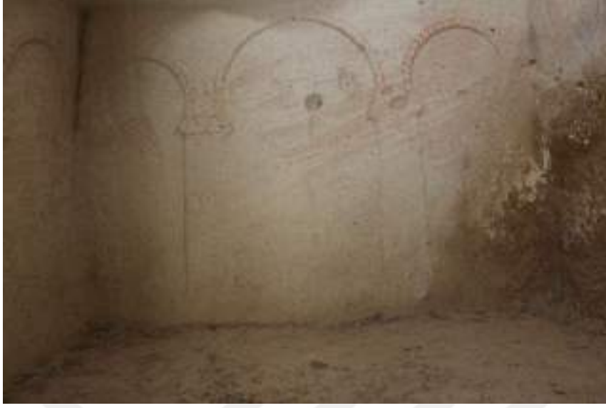
Fotoğraf 481: Mutfak Bölümü Doğu Cephesi
