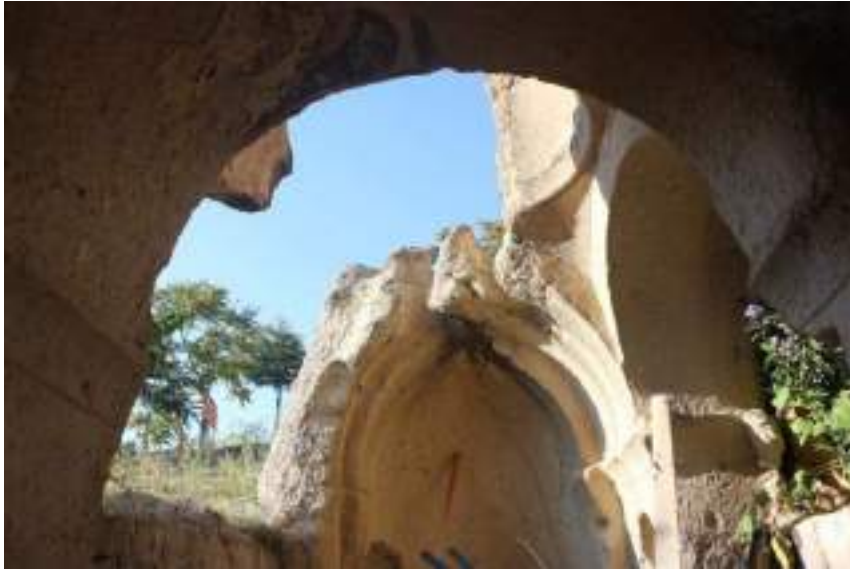
Fotoğraf 216: Kanlıbağ Mevki 2 Nolu Kilise Üst Örtüsü
