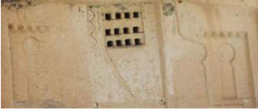
Fotoğraf 451: St. Paul Kilisesi Giriş Cephesi Testere Dişi Kabartması
