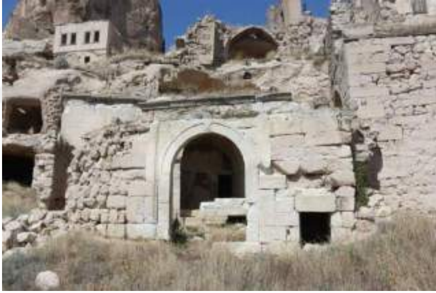
Fotoğraf 528: Ali Yetim Evi Yapısı Dış Cephe
