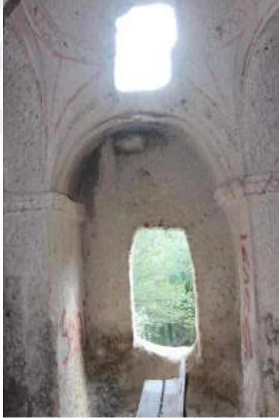
Fotoğraf 208: Kanlıbağ Mevki 1 Nolu Kilise Güney Cephe Görünümü
