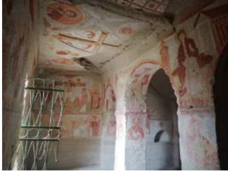
Fotoğraf 140: Saklı Kilise Narteks Bölümü Güney Cephe Görünümü (Kaya, 2014)
