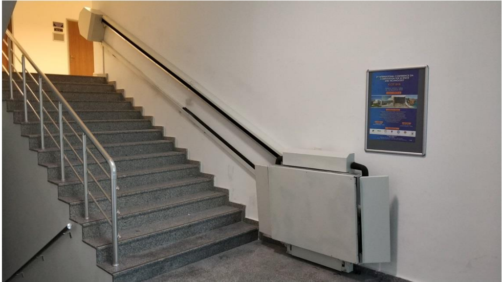
Şekil 5.7 Montajı Tamamlanmış Platform
