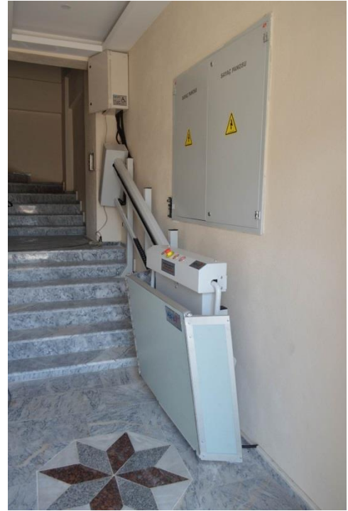
Şekil 1.2 Yatay Tip Engelli Platformları
