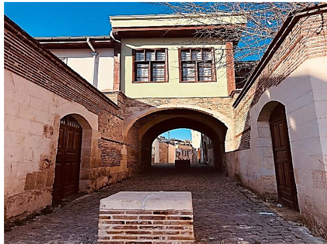
Resim 1: Tepebağ Bölgesi Musa Balı Konağı
