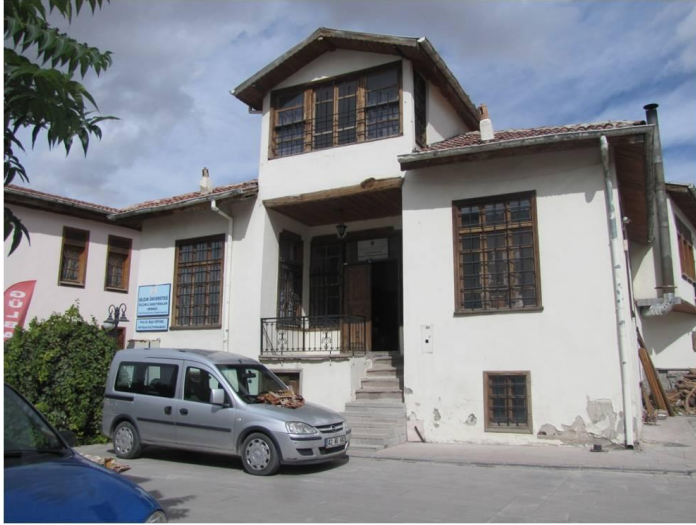
Resim 11: Eski Selçuklu Araştırmaları Merkezi Cihannüma Görünüş
