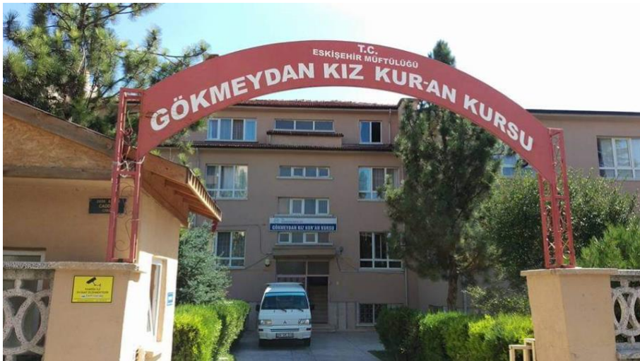
Ek-42 Gökmeydan Kız Kur'an Kursu'nun Yıkılan Binası
