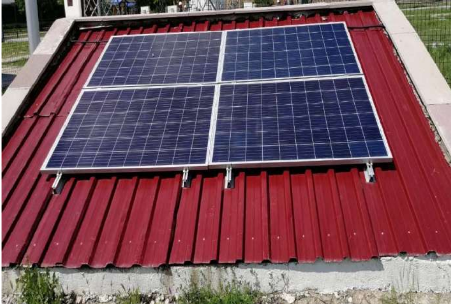
Şekil 3.14. Çatı üzerine montaj şekli
