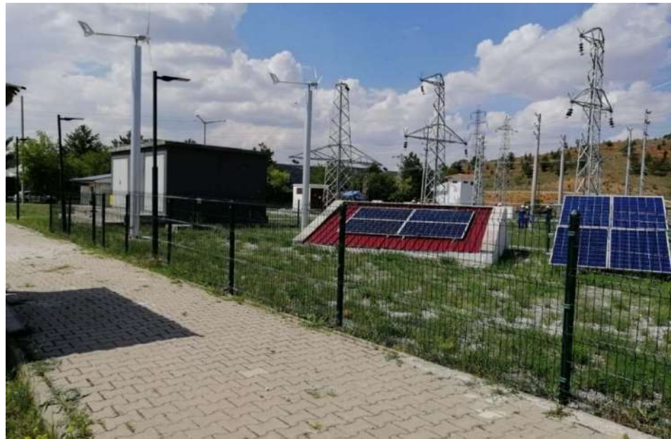
Şekil 3.2. Hibrit sistemin sahadaki kurulmuş hali
