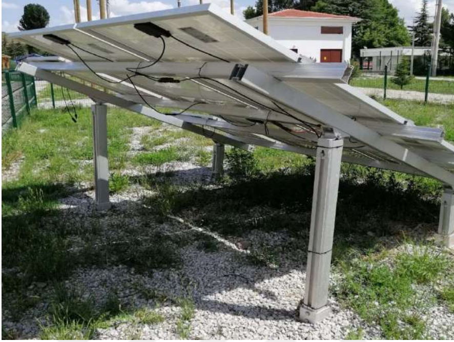
Şekil 3.13. Alüminyum konstrüksiyon üzerine montaj şekli
