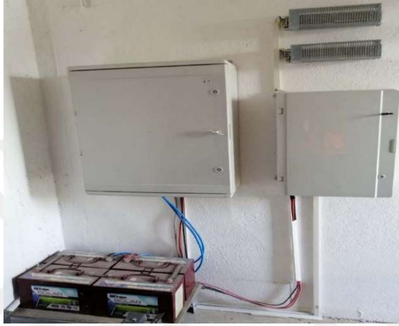
Şekil 3.15. Hibrit sistemin panoları ve akü grubunun genel görüntüsü
